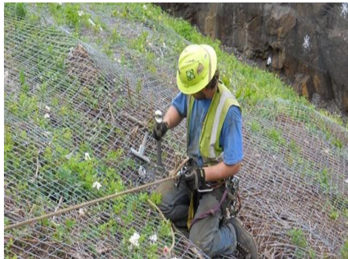
Εικόνα 2.8 Εφαρμογή μεταλλικού πλέγματος για τον περιορισμό της κίνησης των τεμαχών ( www.geobrugg.com )
