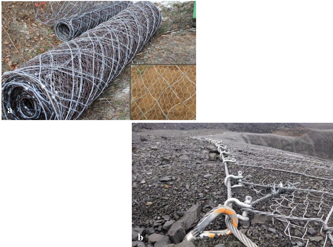
Εικόνα 2.9 α)Μεταλλικά πλέγματα πριν και μετά την εφαρμογή τους ( www.ameritech.pro ), β)Αγκύρωση μεταλλικού πλέγματος στη στέψη πρανούς ( www.ameritech.pro )
