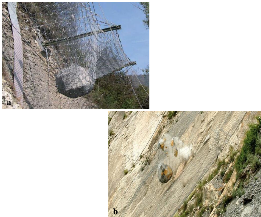
Εικόνα 2.10 Ανάσχεση βράχων: α) από ευκάμπτη μεταλλική βραχοπαγίδα ( www.externalworksindex.co.uk ), και β) από μεταλλικά μετωπικά πλέγματα ( www.geobrugg.com )
