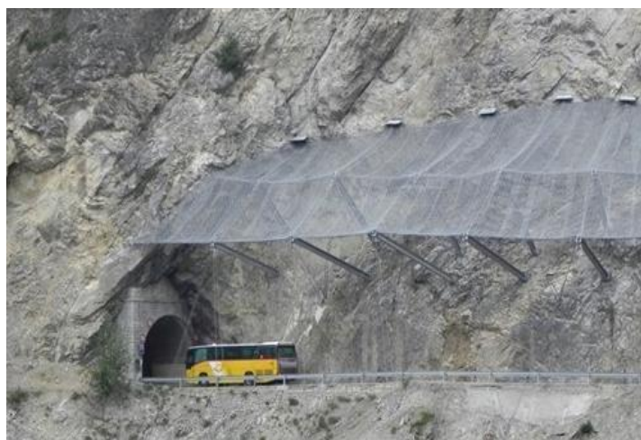
Εικόνα 2.6 Μεταλλικό στέγαστρο ( www.geobrugg.com )
