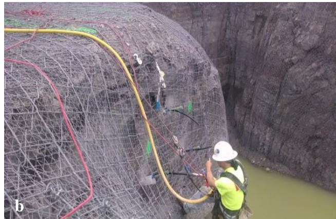
Εικόνα 2.7 Εργασίες κατασκευών μέτρων αντιμετώπισης: a) Εφαρμογή μεταλλικού πλέγματος ( www.geobrugg.com ), b) Εγκατάσταση αγκυρίων ( www.ameritech.com )
