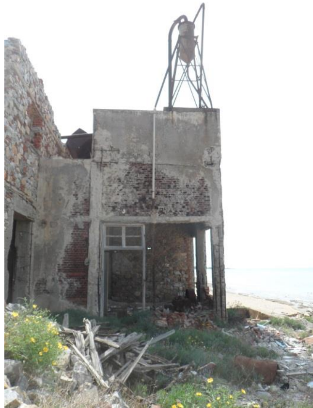
Εικόνα 41: Δεξαμενή και καταρράκτης από την ραφινερία στον Άγιο Ισίδωρο (πηγή: προσωπικό αρχείο)
