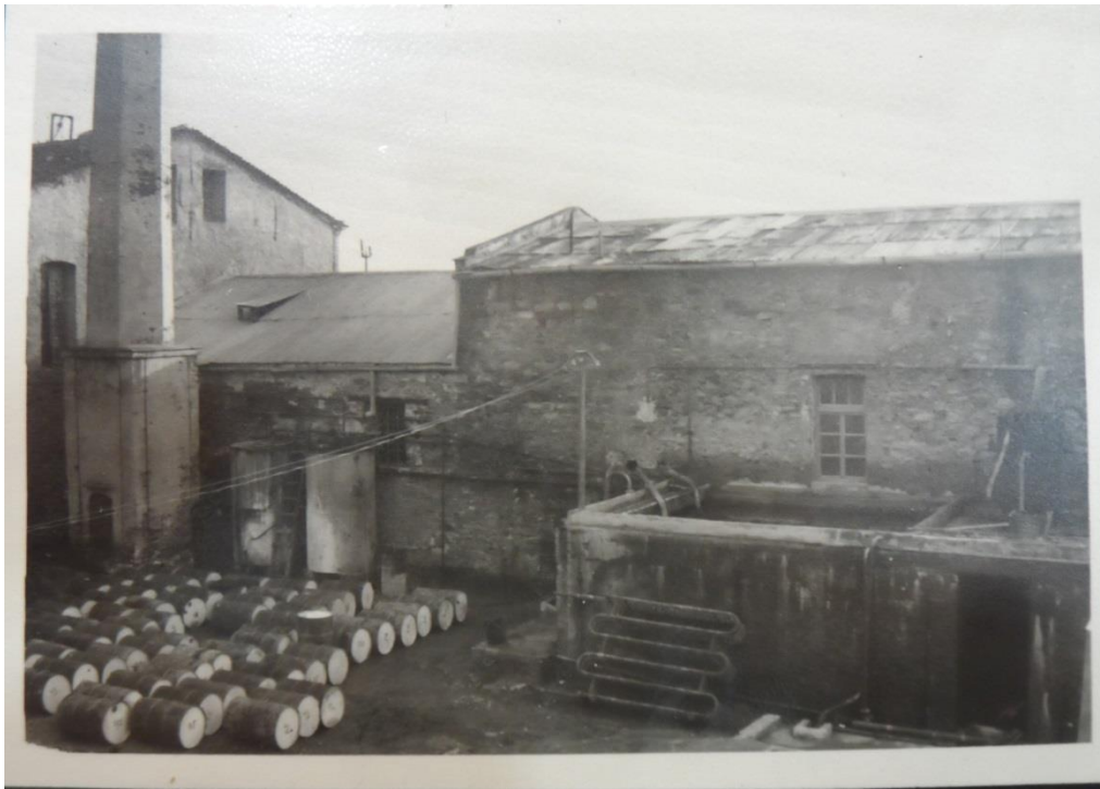
Εικόνα 104: Το πυρηελαιουργείο από τα βορειοδυτικά μετά το 1957 (πηγή: αρχείο Κώνστα)
