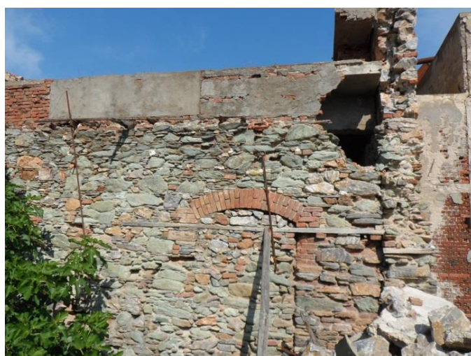
Εικόνα 96: Ο εγκάρσιος τοίχος του σαπωνοποιείου που δεν συνδέεται με τους διαμήκεις (πηγή: προσωπικό αρχείο)
