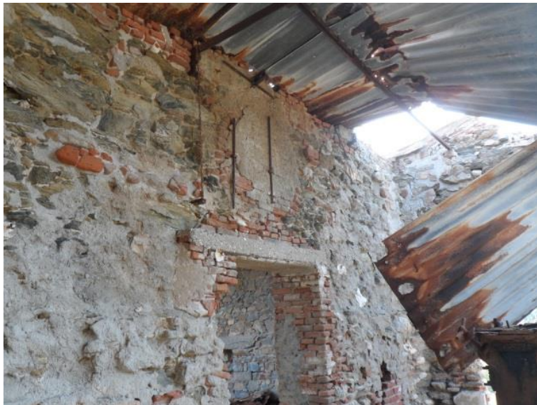
Εικόνα 163: Στέψη του νότιου τοίχου του εκχυλιστηρίου με συμπαγείς πλίνθους (πηγή: προσωπικό αρχείο)
