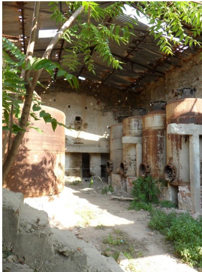
Εικόνα 58: Οι οπές στους τοίχους (και η μείωση του πλάτους των πλευρικών τοίχων) του εκχυλιστηρίου πιθανώς συνδέονται (εκτός από κατασκευαστικά θέματα) με την πιθανή ύπαρξη ξύλινων παταριών σε διάφορες φάσεις, επίσης, διακρίνεται η κεντρική οπή του άξονα κίνησης που εντοπίζεται και στους δύο παράλληλους τοίχους προς τα ανατολικά (πηγή: προσωπικό αρχείο)
