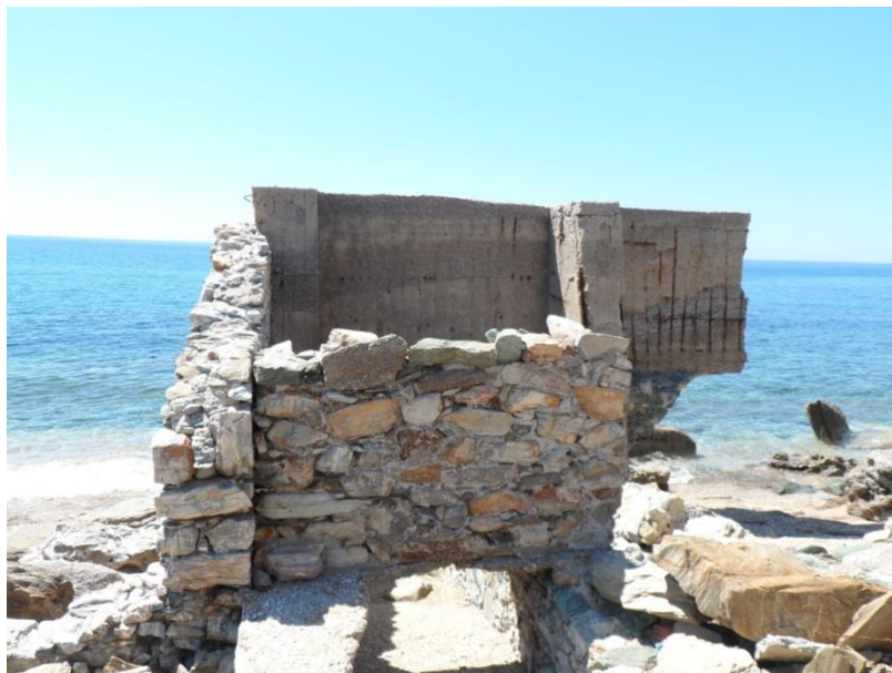
Εικόνα 219: Το κομμάτι του νεότερου προστατευτικού τοίχου που αφαιρείται (πηγή: προσωπικό αρχείο)
