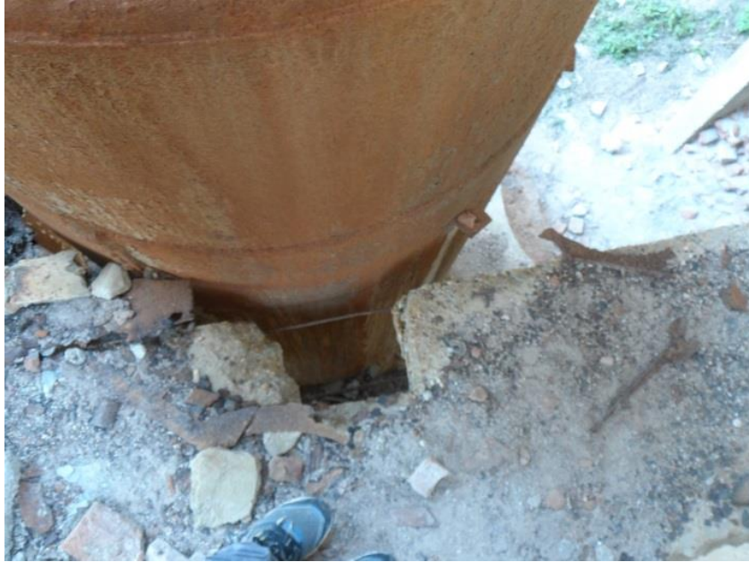
Εικόνα 121: Εγκοπή στο μπετονένιο πατάρι του εκχυλιστηρίου πίσω από τους εκχυλιστήρες (πηγή: προσωπικό αρχείο)
