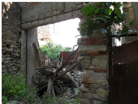
Εικόνα 95: Βόρεια είσοδος στο σαπωνοποιείο όπου δεν "γυρνάει" η γωνία (πηγή: προσωπικό αρχείο)
