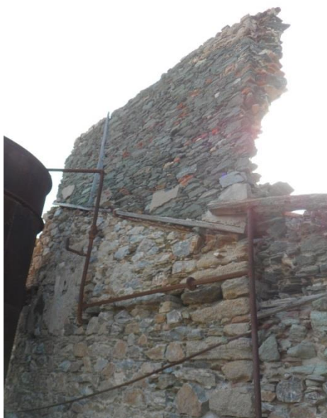
Εικόνα 94: Ξύλινα στοιχεία στον τοίχο πάνω από το αέτωμα (πηγή: προσωπικό αρχείο)
