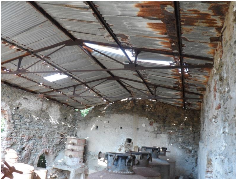
Εικόνα 168: Τα δικτυώματα της στέγης του εκχυλιστηρίου (πηγή: προσωπικό αρχείο)
