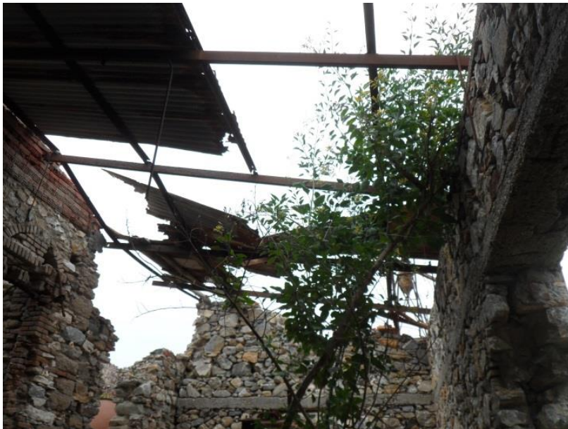
Εικόνα 172: Η μονόριχτη στέγη του νέου λεβητοστασίου (πηγή: προσωπικό αρχείο)
