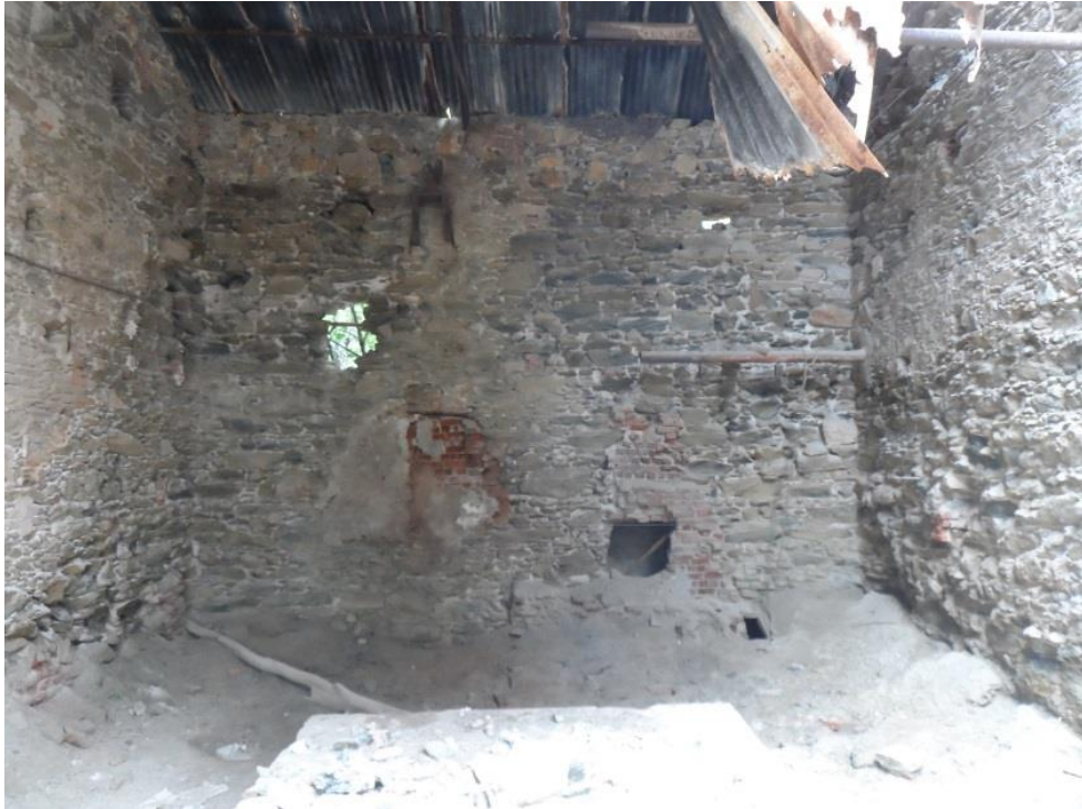
Εικόνα 89: Η οπή στον βόρειο τοίχο του λεβητοστασίου που πιθανώς ανοίχτηκε για την επικοινωνία με την βόρεια αυλή (πηγή: προσωπικό αρχείο)
