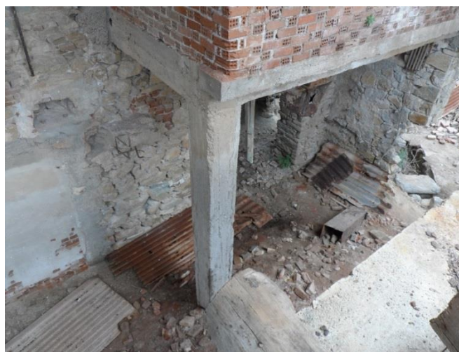
Εικόνα 112: Το κομμένο σενάζ στον χώρο του ξηραντηρίου, διακρίνεται και η κλεισμένη διαγώνια θύρα της προηγούμενης φάσης και η κλεισμένη οπή από την οποία διερχόταν ο άξονας που κινούσε τον πρώτο ξηραντήριο (πηγή: προσωπικό αρχείο)
