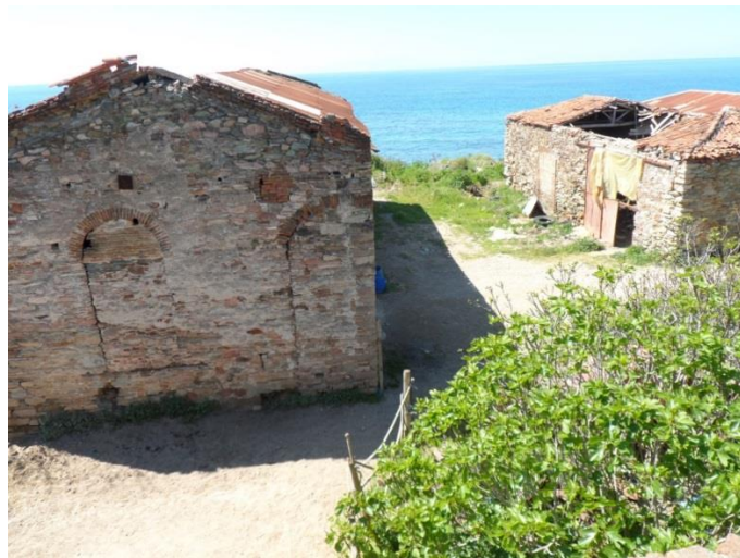
Εικόνα 230: Δεξιά τα κτίρια που γίνονται εστιατόριο του συγκροτήματος και αριστερά το εκχυλιστήριο που γίνεται ξενώνας
