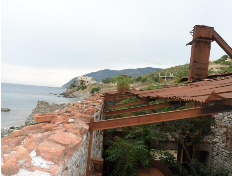
Εικόνα 171: Η μονόριχτη στέγη του ξηραντηρίου (πηγή: προσωπικό αρχείο)
