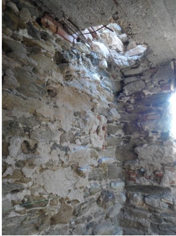
Εικόνα 162: Η εσωτερική παρειά του νότιου τοίχου του εκχυλιστηρίου όπως και όλοι οι τοίχοι του πυρηνελαιουργείου εσωτερικά είναι κατασκευασμένοι από σχιστόλιθους (πηγή: προσωπικό αρχείο)
