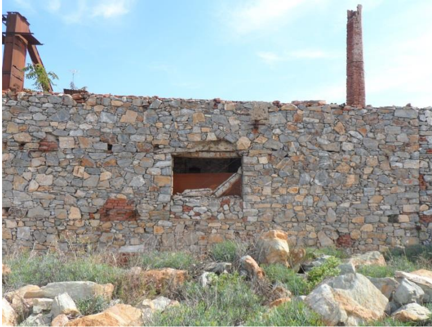
Εικόνα 176: Τμήμα της νότιας όψης του ξηραντηρίου (πηγή: προσωπικό αρχείο)
