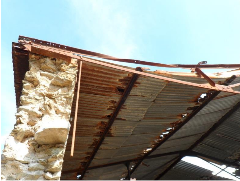
Εικόνα 160: Ο βόρειος τοίχος του εκχυλιστηρίου στο σημείο της κατάρρευσης (πηγή: προσωπικό αρχείο)
