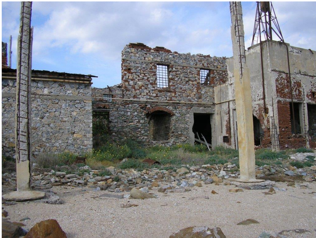
Εικόνα 179: Τα χθαμαλά τόξα του ισογείου του σαπωνοποιείου με τον νέο όροφο πριν την μερική κατάρρευση του (πηγή: http://www.panoramio.com/ )
