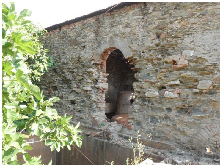
Εικόνα 201: Η καμπύλωση του βόρειου τοίχου του εκχυλιστηρίου προς τα μέσα (πηγή: προσωπικό αρχείο)
