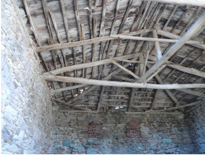
Εικόνα 52: Ο νότιος τοίχος του κτιρίου Κ εσωτερικά, διακρίνονται τα μικρά ανοίγματα που έχουν κλειστεί (πηγή: προσωπικό αρχείο)
