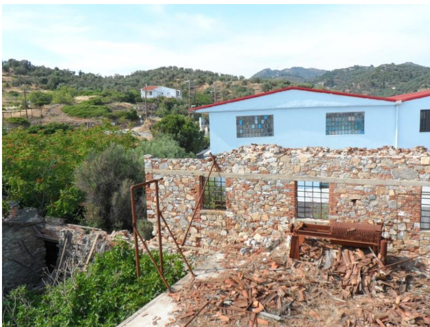
Εικόνα 98: Ο νέος βόρειος τοίχος του σαπωνοποιείου που τελειώνει χωρίς να συνεχίζει πάνω από το υπόλοιπο ισόγειο, το ίδιο ίσχυε και για τον νότιο πριν καταρρεύσει μερικώς (πηγή: προσωπικό αρχείο)
