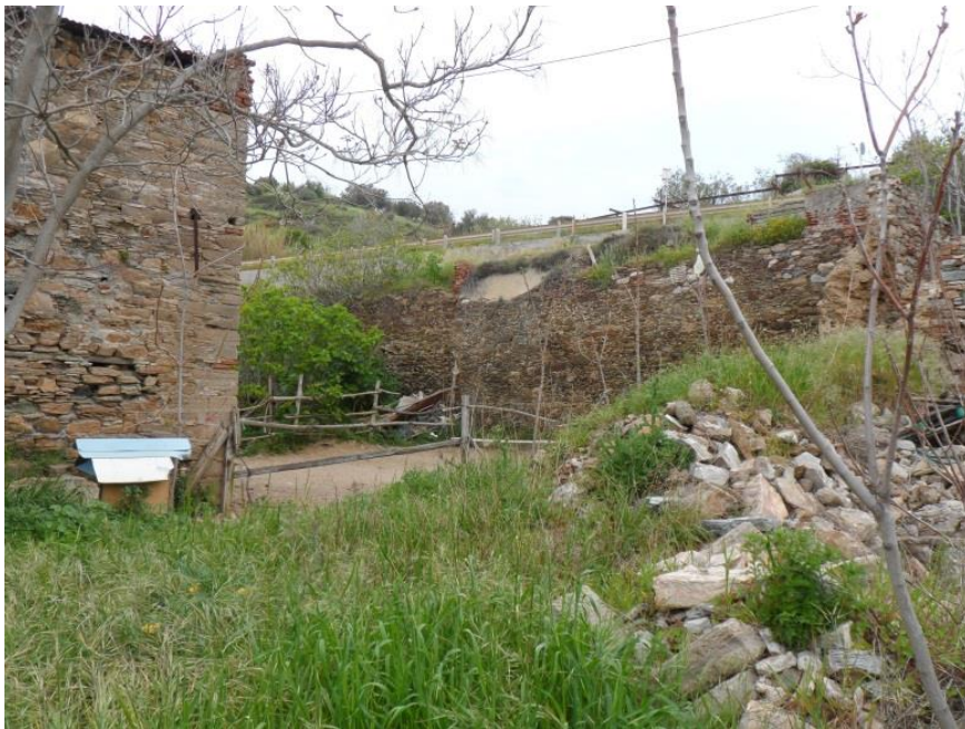
Εικόνα 53: Το ερειπώδες κτίριο Η από τα νοτιοανατολικά (πηγή: προσωπικό αρχείο)
