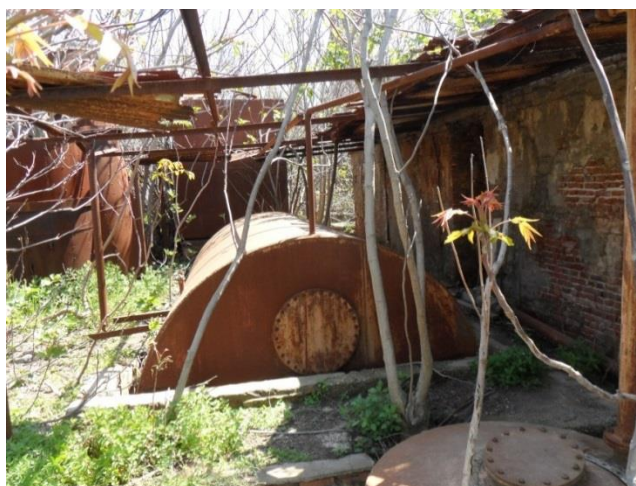
Εικόνα 30: Το σύστημα αποθήκευσης διαλύτη (εξανίου) και τα ψυγεία του πυρηνελαιουργείου Παπαγεωργίου (πηγή: προσωπικό αρχείο)
