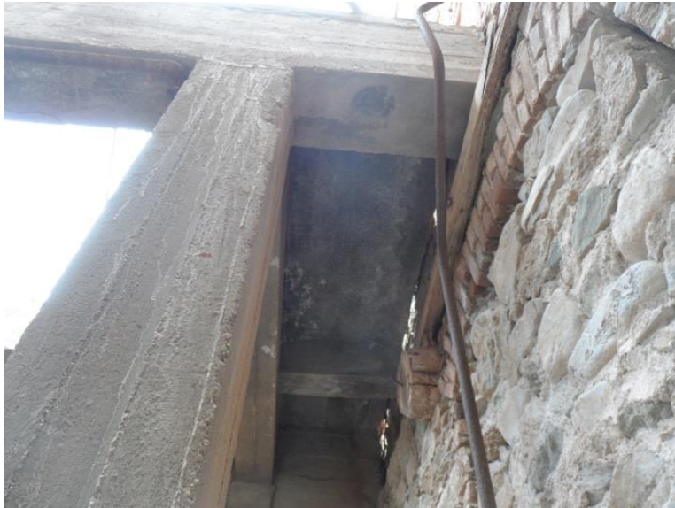
Εικόνα 173: Κομμένο μεσοδόκι στο ισόγειο της ραφινερίας (πηγή: προσωπικό αρχείο)
