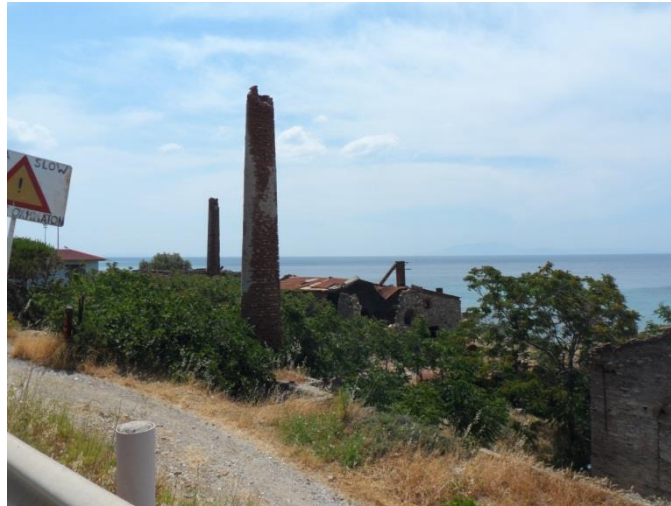
Εικόνα 226: Η δυτική είσοδος απ' όπου θα γίνεται η είσοδος στους ξενώνες(πηγή: προσωπικό αρχείο)
