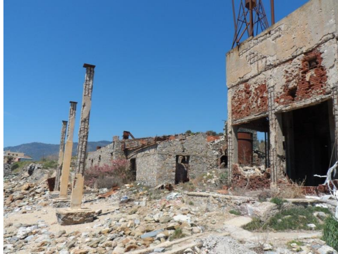
Εικόνα 232: Τα κτίρια και η δεξαμενή που κατεδαφίζονται
