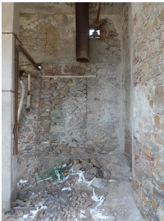
Εικόνα 100: Φωτογραφία από τον χώρο κάτω από την μπετονένια δεξαμενή, διακρίνεται πάνω αριστερά ένα από τα κλεισμένα παράθυρα του ορόφου και κάτω το κλεισμένο παράθυρο του ισογείου στο σημείο όπου υπήρχε ο υπερθερμαντής ατμού (πηγή: προσωπικό αρχείο)
