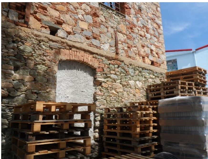
Εικόνα 125: Άνοιγμα του ισογείου της ραφιναρίας στον ανατολικό του τοίχο που βλέπει στο οικόπεδο του εργοστασίου του Βαρβαγιάννη και έχει κλειστεί με τσιμεντόλιθους στην τελευταία φάση (πηγή: προσωπικό αρχείο)
