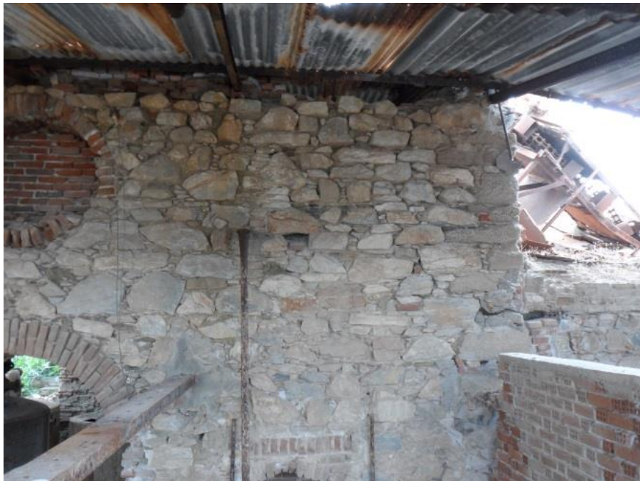
Εικόνα 155: Ασβεστόλιθος από τον νότιο τοίχο του εκχυλιστηρίου (πηγή: προσωπικό αρχείο)
