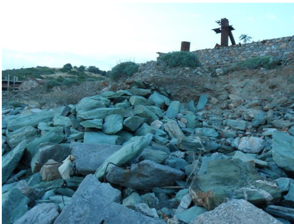
Εικόνα 127: Προσχώσεις μπροστά στο πυρηνελαιουργείο Παπαγεωργίου που υποχωρούν με την καταστροφή του προστατευτικού τοίχου (πηγή: προσωπικό αρχείο)
