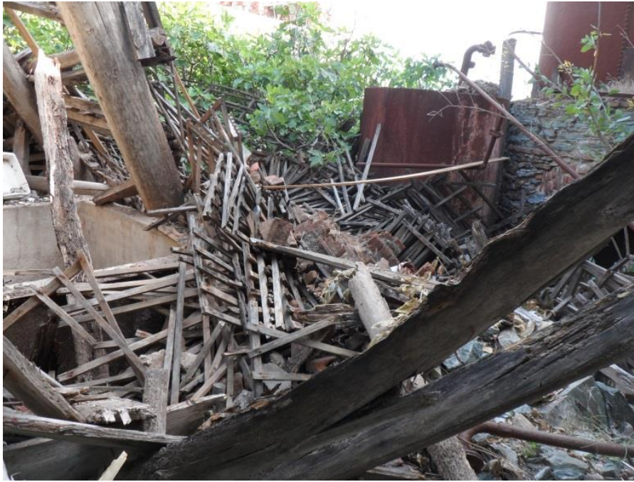
Εικόνα 65: Ξύλινα στοιχεία που σώζονται μέσα στο ερείπιο του σαπωνοποιείου και είναι είτε τελάρα για την ξήρανση των σαπουνιών (μεταγενέστερα) είτε στοιχεία ξυλόπηκτων κατασκευών (πηγή: προσωπικό αρχείο)
