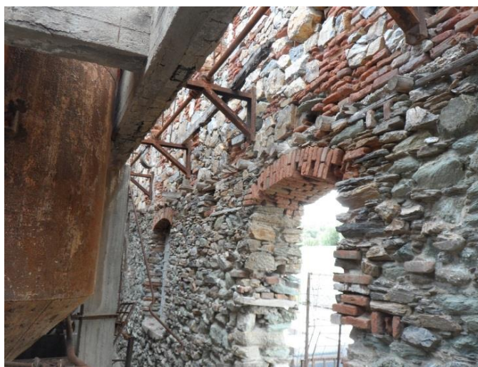
Εικόνα 92: Ανοίγματα με μείωση του πλάτους από το ισόγειο του σαπωνοποιείου που έγινε ραφινερία (πηγή: προσωπικό αρχείο)
