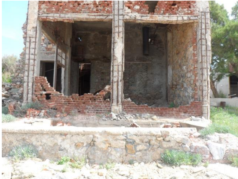
Εικόνα 194: Κλοπή πλίνθων από την δεξαμενή της ραφινερίας (πηγή: προσωπικό αρχείο)
