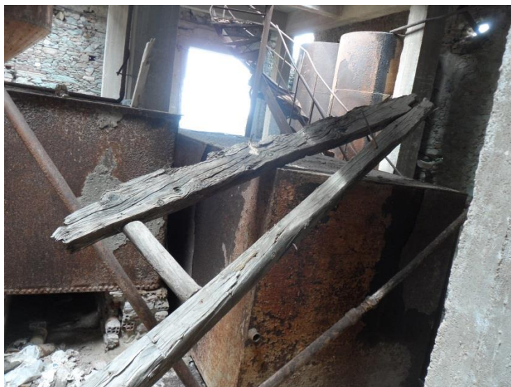
Εικόνα 148: Τμήμα του φορέα της στέγης της ραφινερίας (πηγή: προσωπικό αρχείο)
