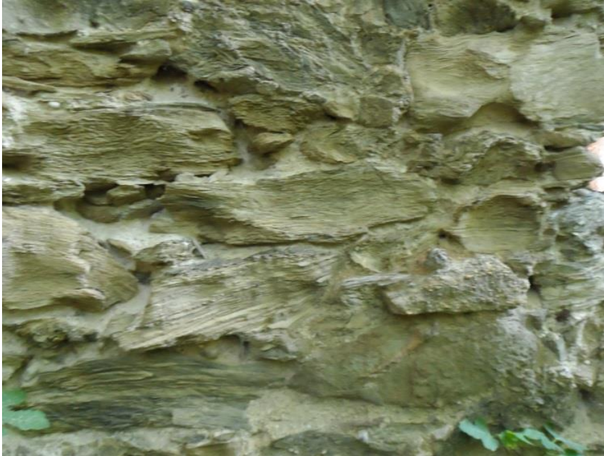
Εικόνα 154: Πράσινο σχιστόλιθος από τον βόρειο τοίχο του εκχυλιστηρίου (πηγή: προσωπικό αρχείο)
