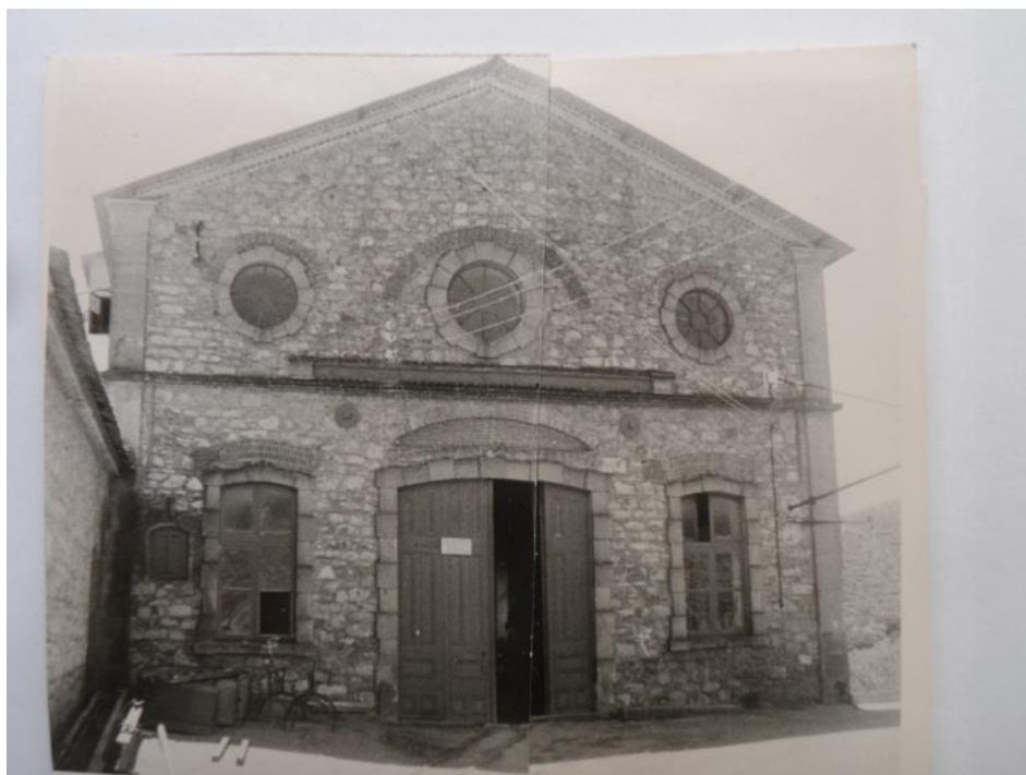
Εικόνα 182: Φεγγίτες στο πυρηνελαιουργείο Βασιλείου, εδώ η κατασκευή και η μορφολογία είναι πολύ πιο προσεγμένη αλλά και το κτίριο μεταγενέστερο (πηγή: αρχείο Κώνστα)
