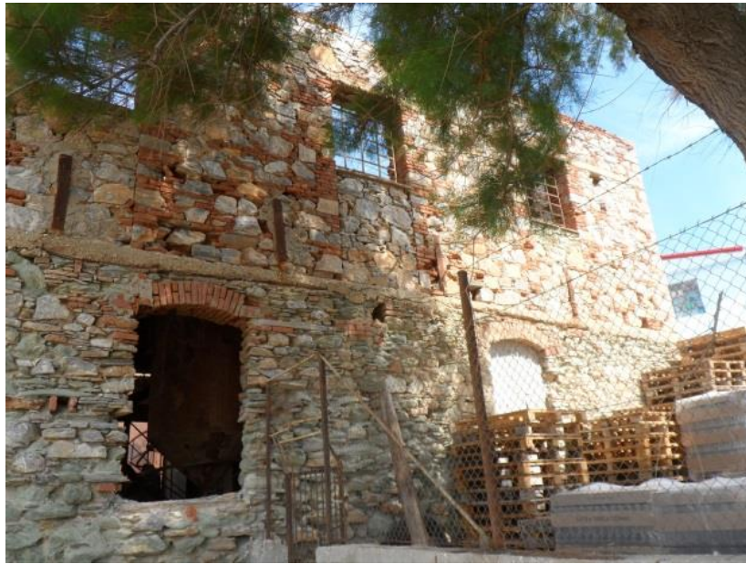
Εικόνα 156: Συμπαγείς πλίνθοι από τον όροφο της ραφινερίας και στην διαμόρφωση τοξωτών ανοιγμάτων (πηγή: προσωπικό αρχείο)
