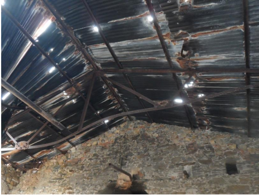
Εικόνα 169: Το καμπυλωμένο δικτύωμα στον χώρο του παλιού λεβητοστασίου (πηγή: προσωπικό αρχείο)
