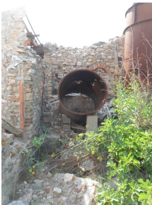
Εικόνα 23: Δευτερεύων σαπωνολέβητας (πηγή: προσωπικό αρχείο)
