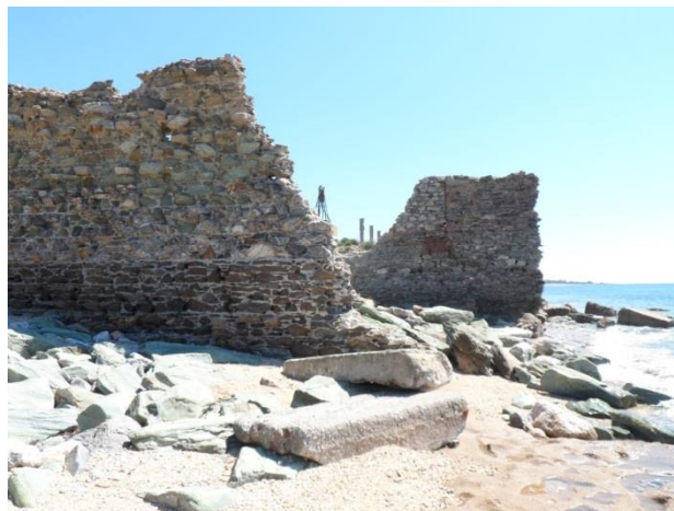
Εικόνα 61: Τα νότια ερείπια της μεγάλης αποθήκης (κτίριο E) από τα δυτικά (πηγή: προσωπικό αρχείο)
