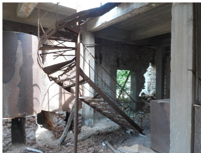
Εικόνα 203: Η διαβρωμένη σκάλα της ραφινερίας (πηγή: προσωπικό αρχείο)
