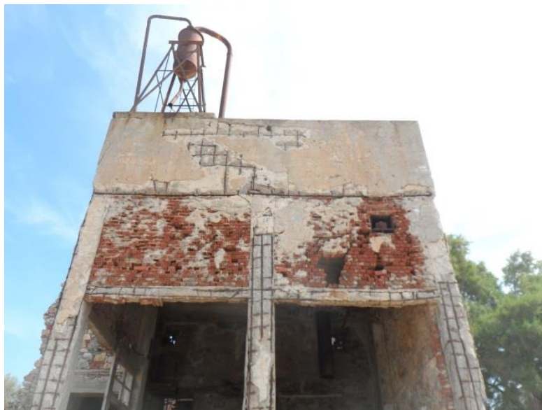
Εικόνα 157: Τρυπητά τούβλα ως στοιχεία πλήρωσης στην μπετονένια δεξαμενή της ραφινερίας (πηγή: προσωπικό αρχείο)
