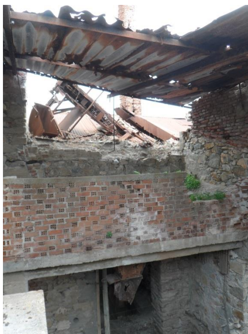
Εικόνα 113: Το κενό που αφέθηκε για την είσοδο της πυρήνας από το ανυψωτικό μηχάνημα, η συμπλήρωση του δυτικού τοίχου του νέου λεβητοστασίου με πλίνθους και το σιλό (πηγή: προσωπικό αρχείο)
