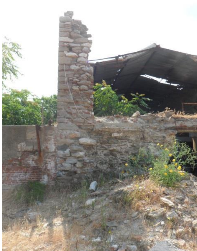
Εικόνα 158: Ψαμμικοί λίθοι στην βορειοδυτική γωνία του εκχυλιστηρίου (πηγή: προσωπικό αρχείο)
