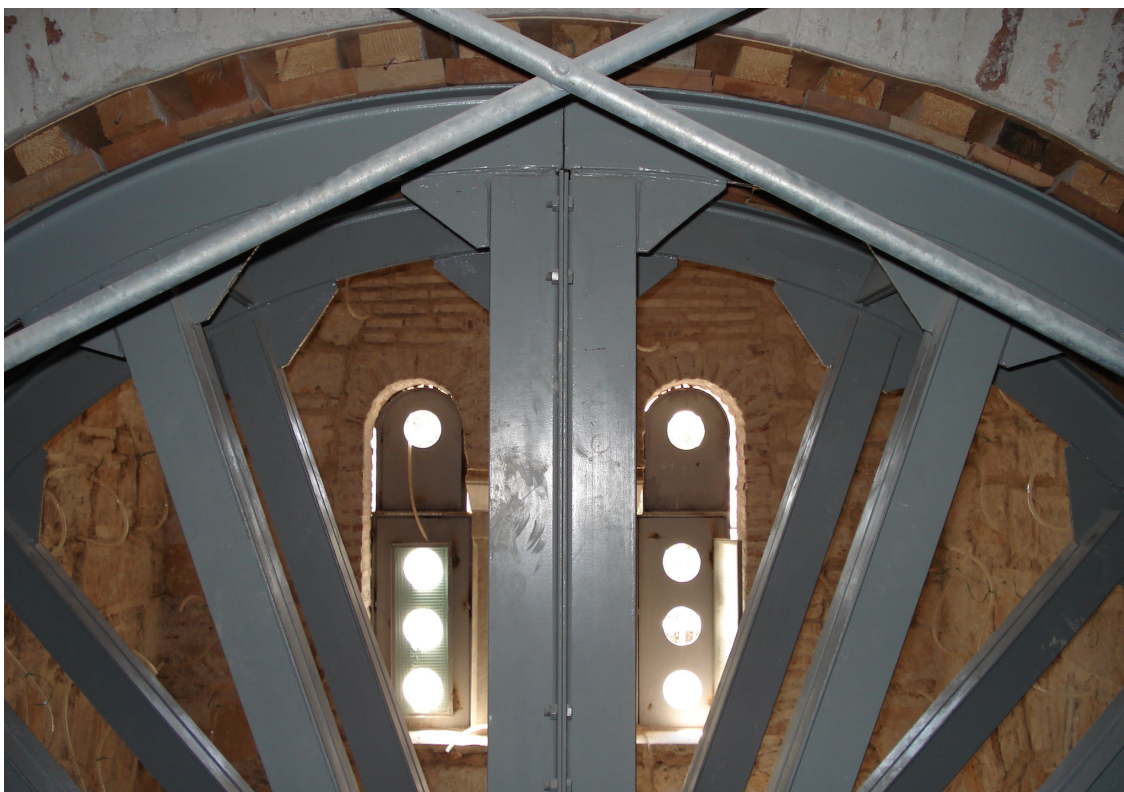
Εικ.β.3 Παράδειγμα υποστήριξης της θολοδομίας κατά την διάρκεια των εργασιών αποκατάστασης στο Καθολικό της Μονής Δαφνίου. Τα πλαίσια εδώ βέβαια είναι ισχυροί μεταλλικοί φορείς, η φωτογραφία όμως είναι ενδεικτική για το πως προσαρμόζεται ένα τέτοιο πλαίσιο στο εξωράχιο. Πηγή: προσ. αρχείο. Μάιος 2006
