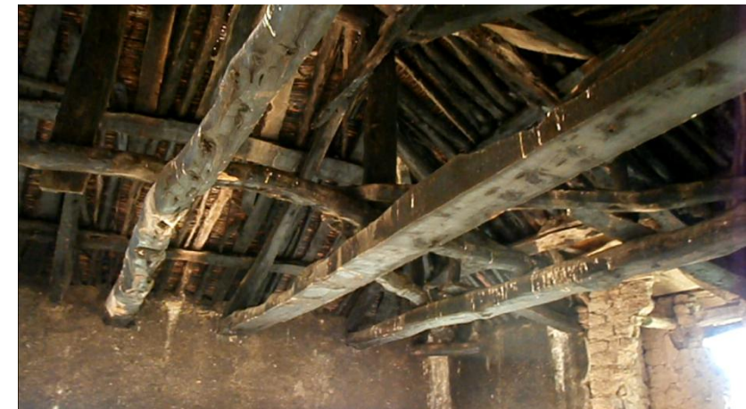
Φωτογραφία 4.17. Το εσωτερικό της στέγης του κτ. Β
