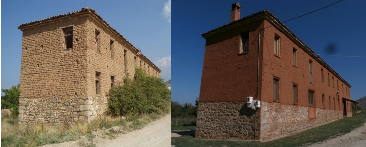
Φωτογραφία 5.18. Αποκατάσταση κτιρίου στον Μηλιώνα. Έγινε εφαρμογή χωμάτινου επιχρίσματος, ωστόσο το έντονα κόκκινο/κεραμιδί χρώμα του μαρτυρά την προέλευση της πρώτης ύλης από άλλη περιοχή. (πηγή φωτ. αριστερά: http://www.prespes.gr )
