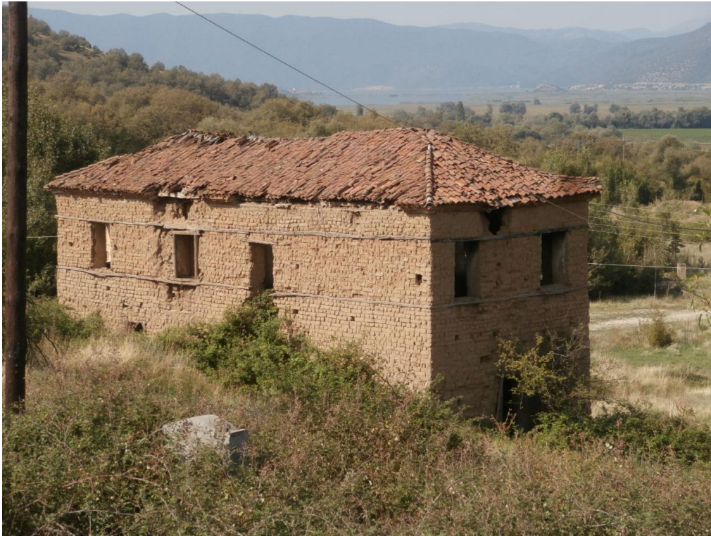
Βόρεια και ανατολική όψη
