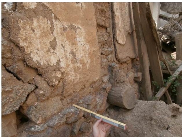
Φωτογραφία 4.6. Στο ύψος του δαπέδου του πρώτου ορόφου (κτ. Α) το πάχος της τοιχοποιίας μικραίνει κατά περ. 5-7 cm.
