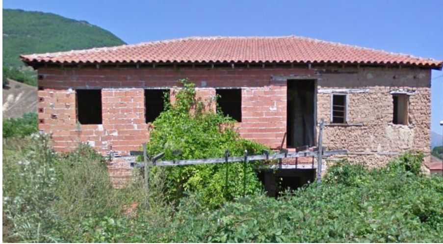
Φωτογραφία 5.20. Κατασκευή νέας στέγης με ξύλινο φορέα και διαζώματα, αντικατάσταση κεραμιδιών και αντικατάσταση ωμόπλινθων με τούβλα με οπές. Κτίριο στον Κώτα.
