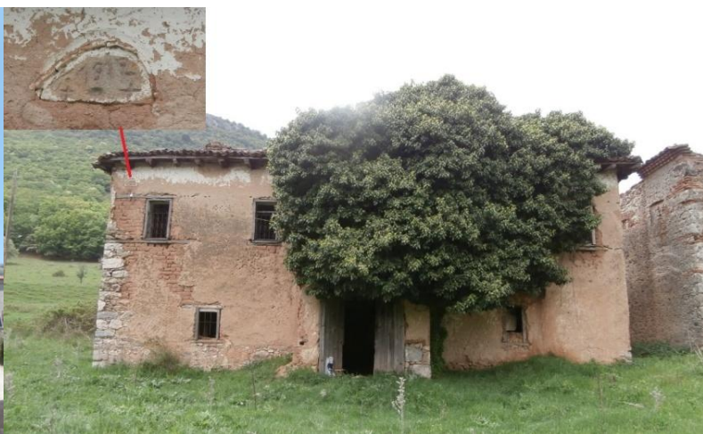
Φωτογραφία 4.2. Κτίριο από ωμόπλινθους στην Οξυά, κτισμένο το έτος 1912
