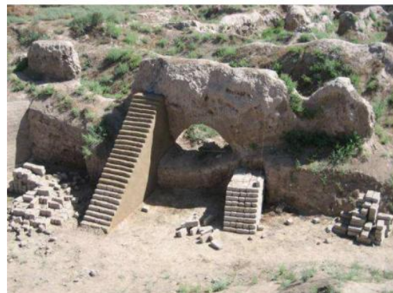
Εικόνα 3.7. Χρήση αντηρίδων ως σωστικών μέτρων, διακριτών από την αυθεντική κατασκευή (Τατζικιστάν) [84]
