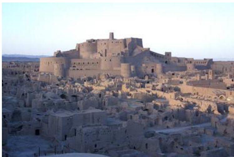
Εικόνα 2.2. Το Arg-e Bam στο ΝΑ Ιράν θεωρείται αντιπροσωπευτικό δείγμα μεσαιωνικής οχυρωματικής αρχιτεκτονικής από ωμόπλινθους και καλουπωτή γη. Το 2003 υπέστη τεράστιες ζημιές από σεισμό. (Πηγή φωτογραφίας http://whc.unesco.org/en/list/1208/gallery/ ).
