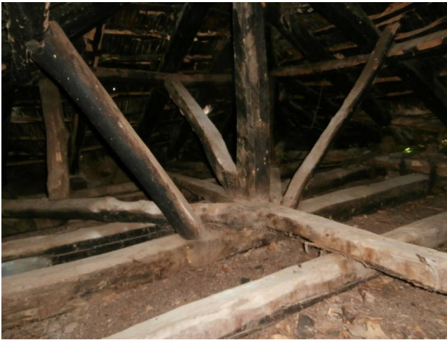
Φωτογραφία 4.13. Εσωτερικό στέγης με αντηρίδες στην Οξυά
