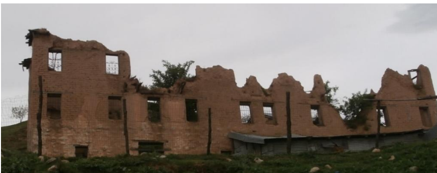
Φωτογραφία 5.5. Σχηματισμός οδόντωσης στην τοιχοποιία. Με την πάροδο του χρόνου οι αυλακώσεις προεκτείνονται καθοδικά. Τρίγωνο Πρεσπών.
