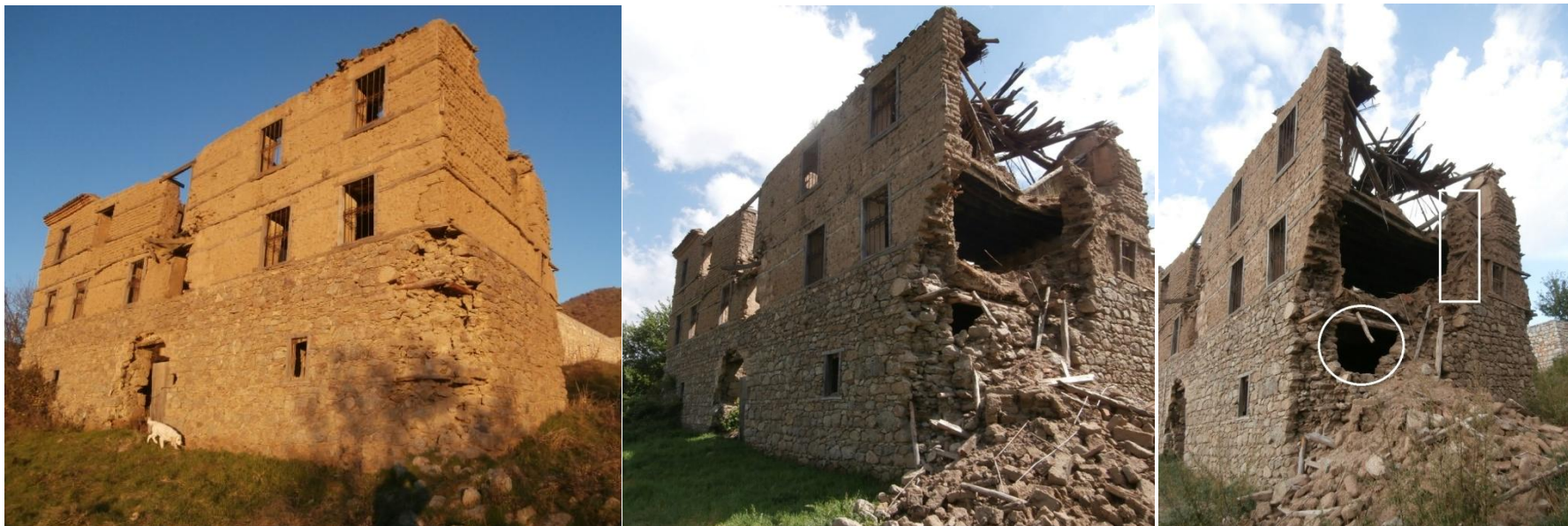
Φωτογραφία 5.12. Κτίριο Α. Παρά την ασθενή σύνδεση των εξωτερικών λιθοδομών, η νότια τοιχοποιία διατηρείται σε καλή κατάσταση (αριστερά, Δεκέμβριος 2014). Τον Μάιο του 2015 η ωμοπλινθοδομή και η λιθοδομή έχουν υποστεί σημαντικές βλάβες, ενώ τον Αύγουστο του 2015 η κατάρρευση της νότιας τοιχοποιίας συνεχίζεται και το εναπομείναν κομμάτι της παρουσιάζει σημαντική κλίση.
