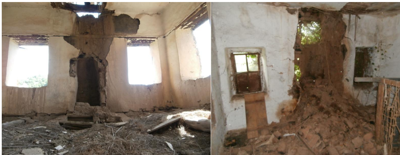
Φωτογραφία 5.15. Συνήθη σημεία εκκίνησης των καταρρεύσεων είναι οι περιοχές εξασθένησης της τοιχοποιίας (τζάκια, καμινάδες)
