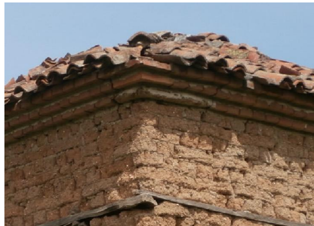
Φωτογραφία 4.16. Το γείσο των κτιρίων της περιοχής είναι σχετικά μικρό. Αριστερά προεξοχή στέγης κτιρίου στον Κρασιώνα, δεξιά το γείσο του κτ. Β.
