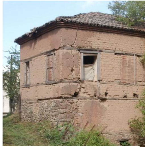
Φωτογραφία 5.3. Εμφάνιση κατακόρυφων ρωγμών στις γωνίες της τοιχοποιίας. Κτίριο στον Κρασιώνα (αριστερά, πηγή: [88]) και στον Άγιο Γερμανό (δεξιά).
