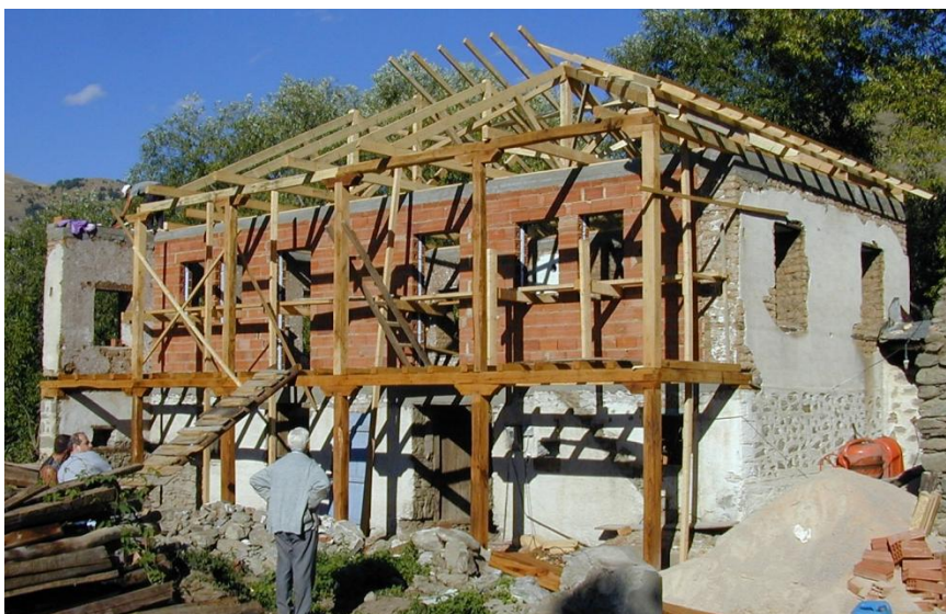
Φωτογραφία 5.17. Ανακατασκευή τοίχων με διάτρητους οπτόπλινθους και κατασκευή σενάζ από μπετόν. Κτίριο στον Άγιο Γερμανό. (πηγή: προσωπικό αρχείο κ. Θάνου Τριανταφυλλίδη)
