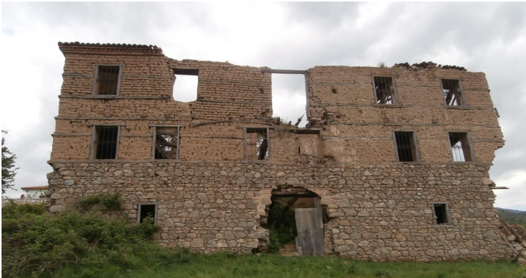
Φωτογραφία 4.10. Η τοποθέτηση της θύρας του κεντρικού εξώστη δεν είναι συμμετρική ως προς την όψη του κτιρίου Α. Τα λοιπά ανοίγματα τοποθετούνται συμμετρικά ως προς τις γενικές διαστάσεις του κτιρίου, ωστόσο παρατηρείται ασυνέχεια στην καθ' ύψος τοποθέτησή τους.
