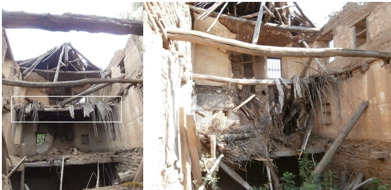
Φωτογραφία 5.12. Κτίριο Α. Παρά την ασθενή σύνδεση των εξωτερικών λιθοδομών, η νότια τοιχοποιία διατηρείται σε καλή κατάσταση (αριστερά, Δεκέμβριος 2014). Τον Μάιο του 2015 η ωμοπλινθοδομή και η λιθοδομή έχουν υποστεί σημαντικές βλάβες, ενώ τον Αύγουστο του 2015 η κατάρρευση της νότιας τοιχοποιίας συνεχίζεται και το εναπομείναν κομμάτι της παρουσιάζει σημαντική κλίση.
