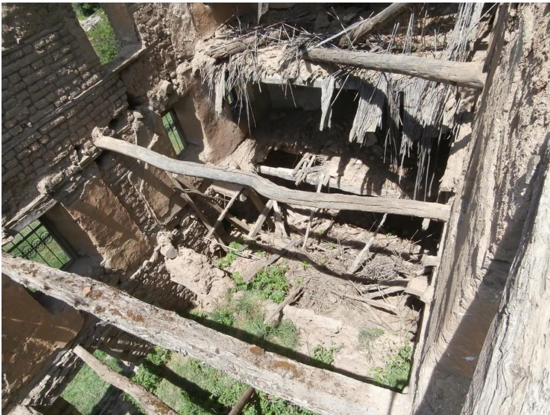
Το εσωτερικό του κτιρίου
