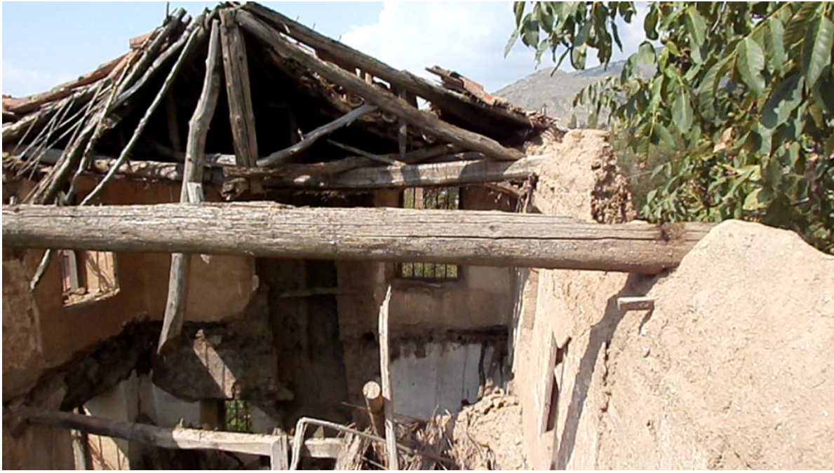
Διακρίνεται ο φορέας της στέγης και η καμινάδα στη στενή πλευρά του κτιρίου
