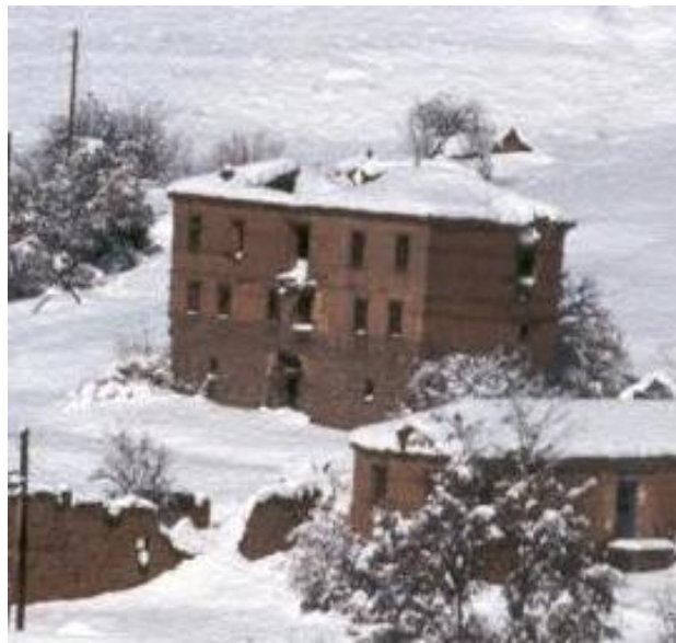
Φωτογραφία 5.10. Έτος 2003. Είναι εμφανής η απώλεια λίθων στις γωνίες του κτ. Α αλλά και περιμετρικά του ανοίγματος της κύριας εισόδου. Η κατάσταση διατήρησης της τοιχοποιίας και της στέγης παραμένει ακόμα σταθερή. (Αρχείο κ. Ελ. Γραμματικού).
