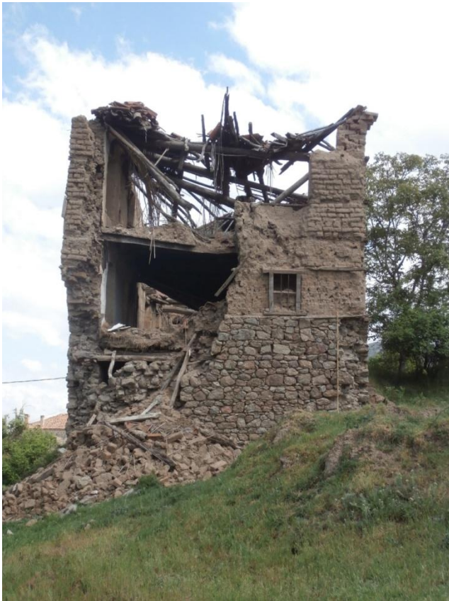
Η βόρεια και νότια όψη του κτιρίου (πάνω και κάτω, αντίστοιχα)
