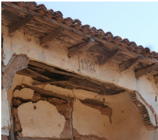
Φωτογραφία 4.16. Το γείσο των κτιρίων της περιοχής είναι σχετικά μικρό. Αριστερά προεξοχή στέγης κτιρίου στον Κρασιώνα, δεξιά το γείσο του κτ. Β.
