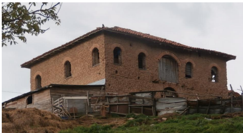
Φωτογραφία 4.3. Στα κτίρια του οικισμού Τρίγωνο παρατηρήθηκε η συχνή κατασκευή τοξωτών υπέρθυρων με χρήση οπτόπλινθων.
