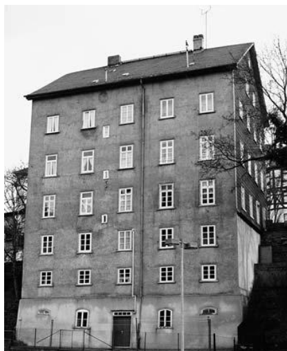
Εικόνα 2.1. Κτίριο από καλουπωτό πηλό στο Βάιλμπουργκ της Γερμανίας. Θεωρείται το υψηλότερο στην Ευρώπη που έχει φτιαχτεί από ωμή γη (1828) [28]
