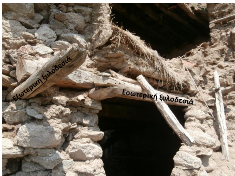
Φωτογραφία 4.18. Η πορεία της εσωτερικής ξυλοδεσιάς διακόπτεται προτού συναντήσει την εγκάρσια διασταυρούμενη εξωτερική ξυλοδεσιά.
