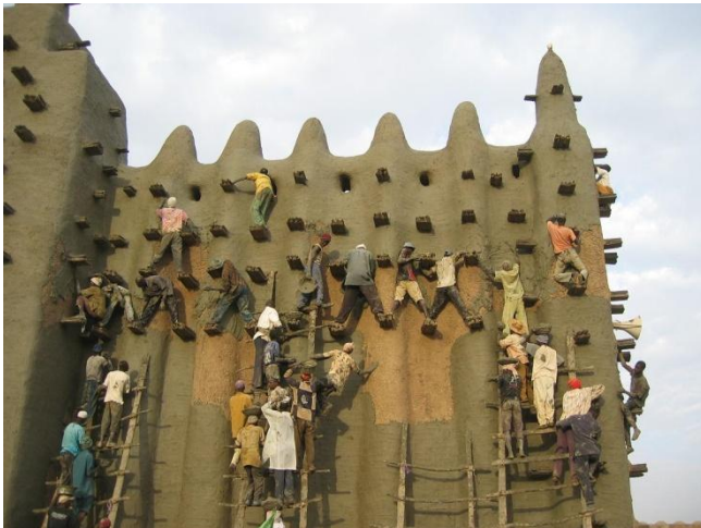
Εικόνα 3.4. Η επανεπίχριση των επιφανειών στο Μεγάλο Τζαμί της Djenne, Μάλι, δεν είναι απλά ένα μέτρο προστασίας από τη βροχή. Κάθε χρόνο όλοι οι κάτοικοι μετέχουν στο φεστιβάλ Crepissage de la Grand Mosquée , μεταφέροντας λάσπη από τις αλλούβιες αποθέσεις του ποταμού Νίγηρα. (Πηγή: http://www.naturalhomes.org/great-mosque-djenne.htm )
