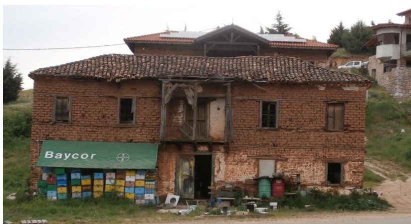
Φωτογραφία 5.16. Μετατροπή κατοικίας σε χώρο αποθήκευσης. Πίσω διακρίνεται η εγκατάσταση φωτοβολταϊκών πάνελ στη στέγη κτιρίου από ωμόπλινθους. Καρυές Πρεσπών.
