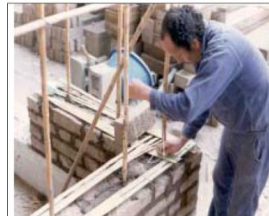
Εικόνα 3.10. Διάτρηση των ωμόπλινθων για την τοποθέτηση χαλύβδινων ράβδων σε πειραματικό μοντέλο (αριστερά) και παραλλαγή της μεθόδου με χρήση καλαμιών στο Περού (δεξιά).
