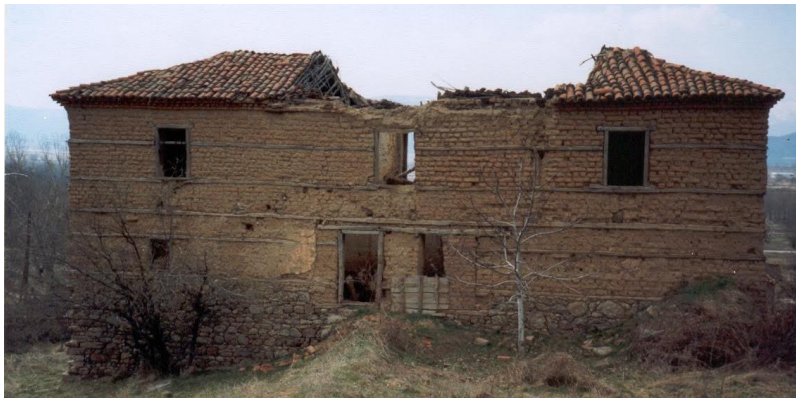
Φωτογραφία 5.11. Η κατάσταση διατήρησης της στέγης του κτ. Α, σταθερή τα προηγούμενα χρόνια, αλλάζει εντυπωσιακά στο διάστημα 2005-2015 (αριστερά και δεξιά, αντίστοιχα). (Πηγή φωτ. αριστερά: αρχείο της κ. Ελ. Γραμματικού).
