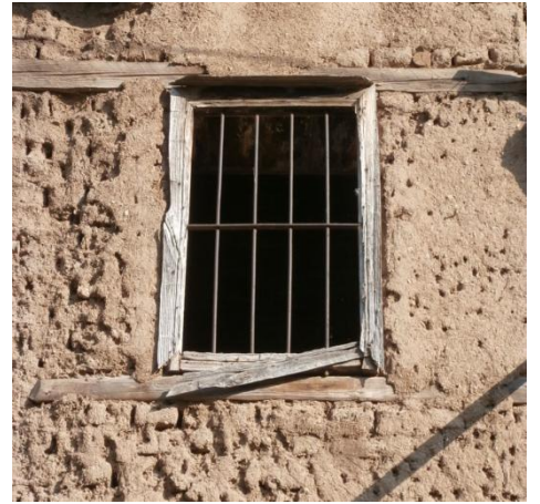
Φωτογραφία 4.9. Καρφωτό αρμοκάλυπτρο εξωτερικά του τετράξυλου, στην περασιά του επιχρίσματος.
