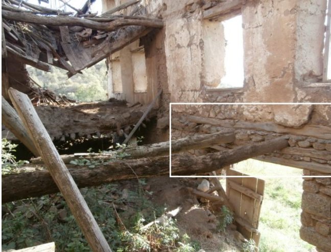
Φωτογραφία 4.19. Το άνοιγμα της κύριας εισόδου του κτ. Α ενισχύεται, εκτός από το ισχυρό ξύλινο ανώφλι και από πρόσθετες ξύλινες δοκούς.
