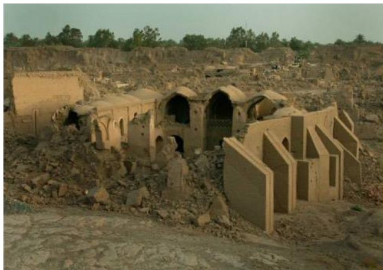
Εικόνα 3.6. Τα ερείπια του καραβανσεράι στο Μπαμ του Ιράν φανερώνουν πως οι τρούλοι που στηρίζονταν σε αντηρίδες κατέρρευσαν, σε αντίθεση με τους υπόλοιπους που έμειναν στη θέση τους [83].
