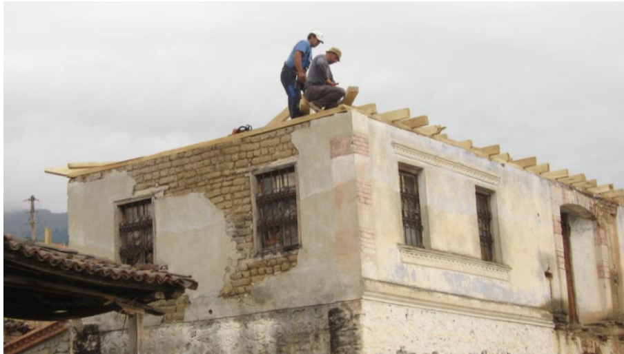
Φωτογραφία 5.21. Κατασκευή νέας στέγης με ξύλινα διαζώματα σε κτίριο στον Μηλεώνα. Η τοιχοποιία, προστατευμένη από το επίχρισμα, διατηρείται σε πολύ καλή κατάσταση. (πηγή: αρχείο κ. Αγγέλας Γεωργαντά)
