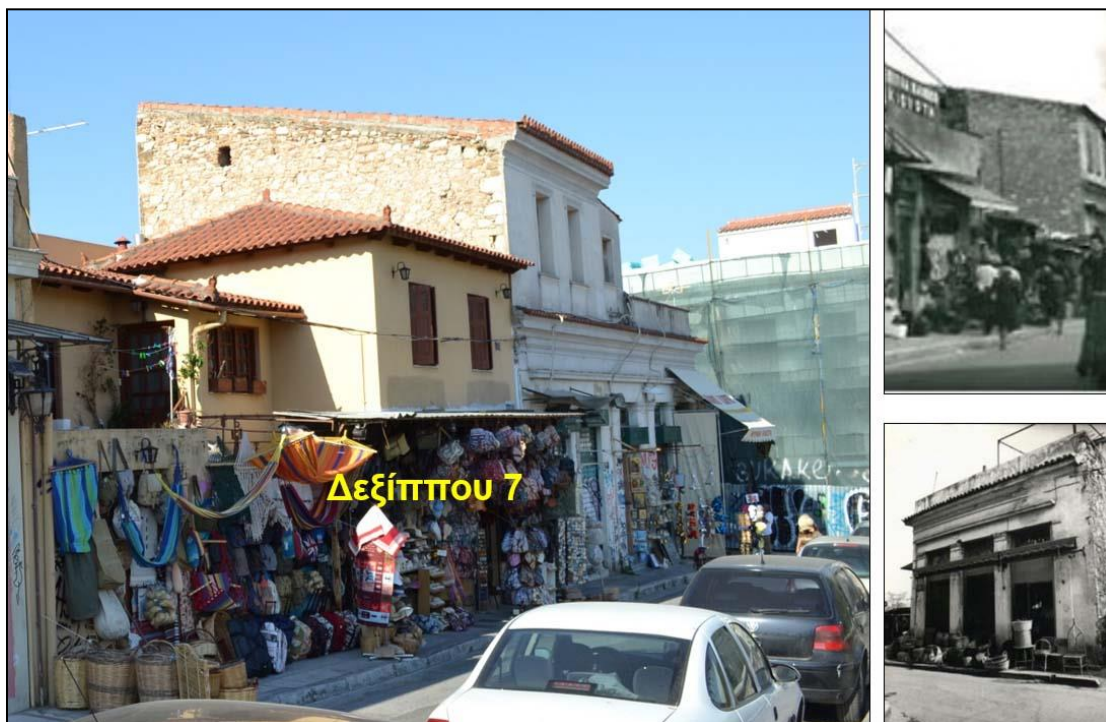
Εικόνα 54: Το σύγχρονο κτίριο επί της Δεξίππου 7, η κατεδάφιση του θα κάνει δυνατή τη σύνδεση των δύο πρόπυλων: βιβλιοθήκης Αδριανού και πύλης Αρχηγέτιδος Αθηνάς της Ρωμαϊκής αγοράς
