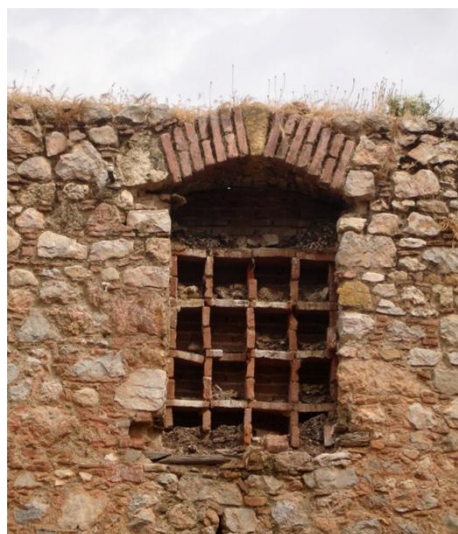
εικ. 75: ανοίγματα φραγμένο με οπτοπλίνθους
