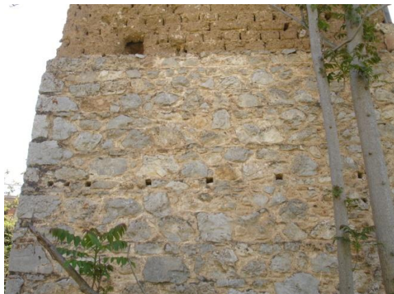
εικ. 84: ίχνη από ξυλοδεσιές στη βορειοδυτική γωνιά του κτιρίου στη στάθμη +1.86 από το επίπεδο του εσωτερικού δαπέδου
