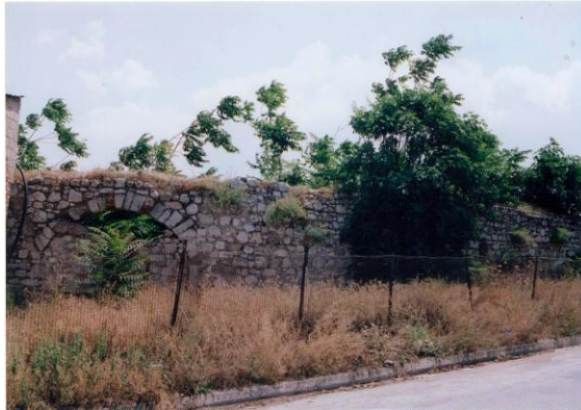
εικ. 14: Φωτογραφία του Στέφανου Νομικού (5 Ιουνίου 1993) από τον μύλο του Δελβενακιώτη. Φαίνεται τμήμα του πέτρινου τοίχου που στην άνω του πλευρά υπήρχε αυλάκι που έρεε νερό για την κίνηση του νερόμυλου.
