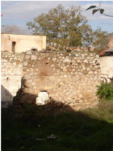
εικ. 67: η επέμβαση στον ανατολικό τοίχο για την διάνοιξη του νέου τζακιού
