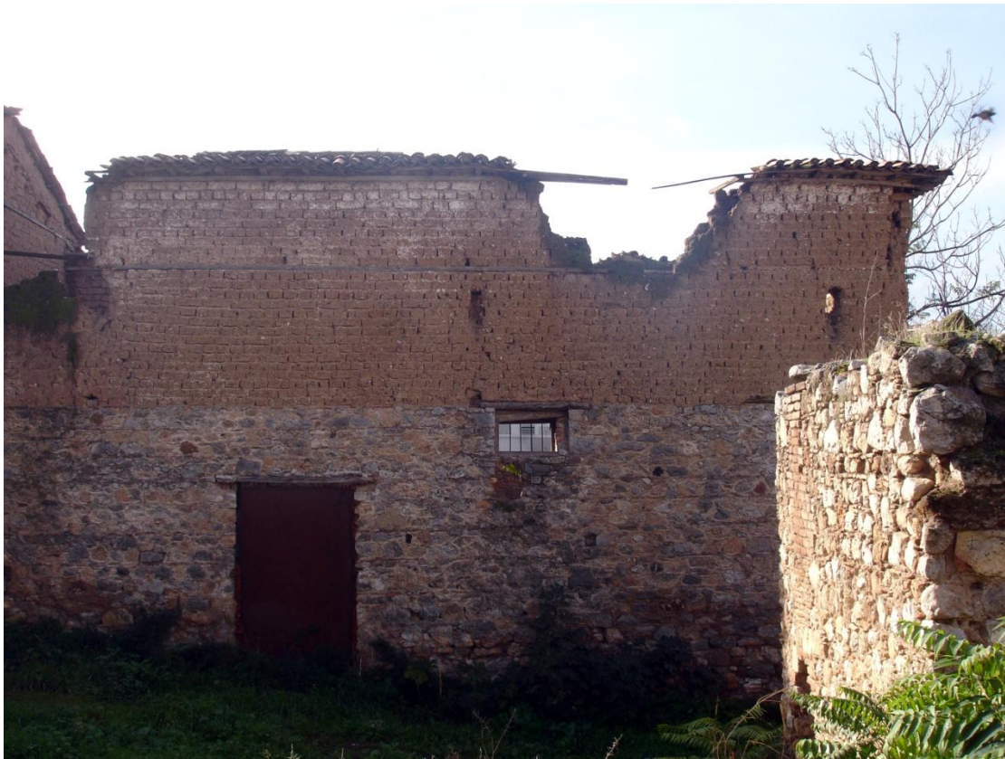
εικ. 81: βόρεια όψη
