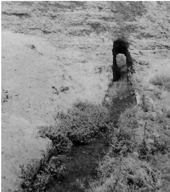
εικ. 15: Χάριν του αυλακιού εκτροπής των νερών είχε τρυπηθεί το ύψωμα της αριστερής όχθης που φαίνεται στην εικόνα. Η ακριβής θέση σήμερα δεν έχει εντοπιστεί.
