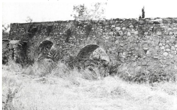
εικ. 12: Τμήμα του τοξωτού τοίχου που στο άνω μέρος του κυλούσε το νερό που κινούσε μια σειρά από υδρόμυλους νότια του νεκροταφείου του Αγίου Λουκά. Σήμερα δεν σώζεται.
