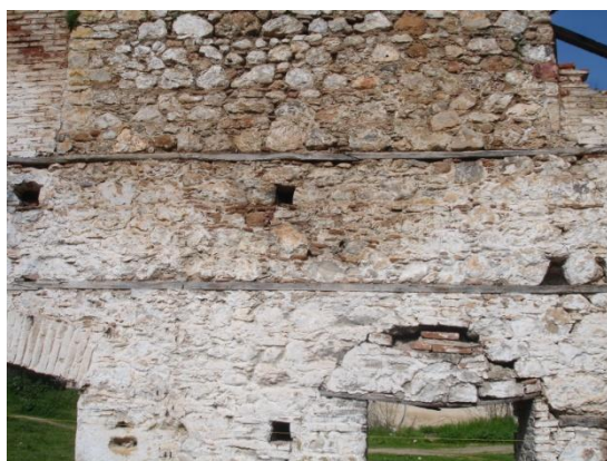
εικ. 72: οι ξυλοδεσιές στον εσωτερικό δυτικό τοίχο
