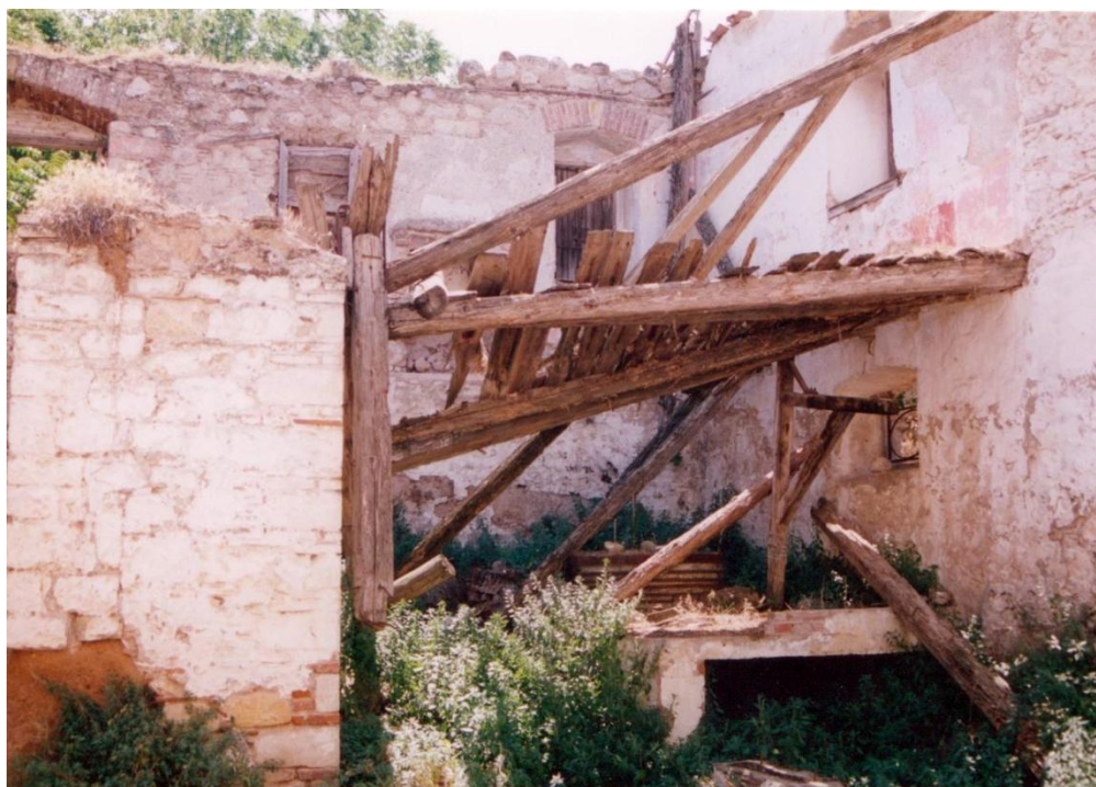
εικ. 76: στη φωτογραφία διακρίνονται τα ανοίγματα του ανατολικού τοίχου, το ξύλινο πατάρι και δύο ζευκτά της στέγης
