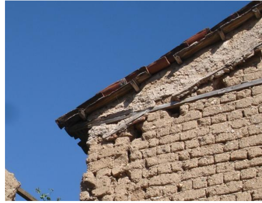
εικ. 90, 91: φωτογραφίες της στέγης της αποθήκης. Δεξιά φαίνονται και υπολείμματα του κονιάματος αργίλου.
