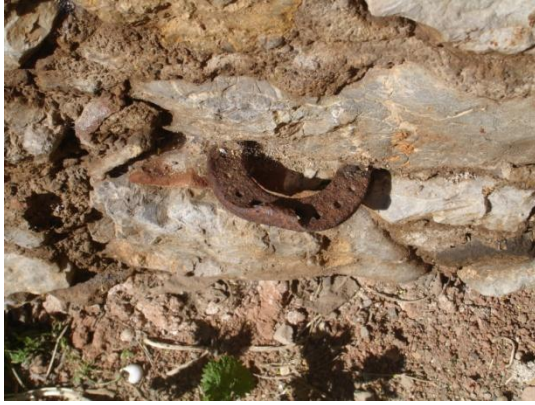
εικ. 83: πέταλο ενσωματωμένο στην εσωτερική βόρεια τοιχοποιία του ανατολικού χώρου για το δέσιμο των ζώνων.
