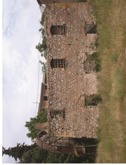
απουσία γωνιών στο κάτω τμήμα της βόρειας αρσιτερής παρειάς που υποδεικνύει τη θέση του τοξωτού ανοίγματος και το ύψος του μικρού χώρου
