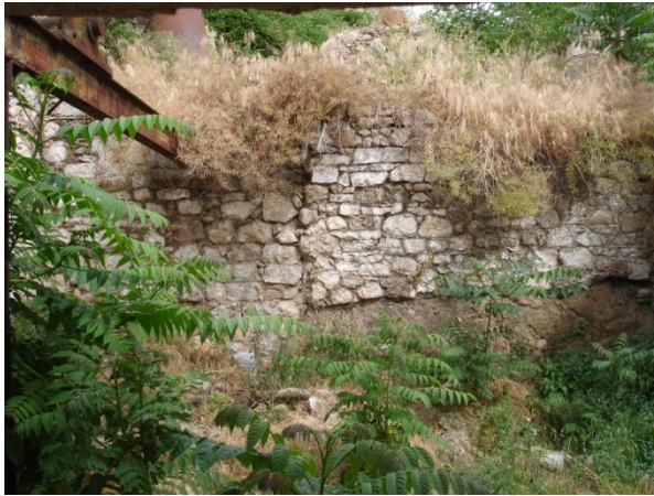
εικ. 64: Ο βράχος θεμελίωσης στη βορειοανατολική γωνιά του κτιρίου.
