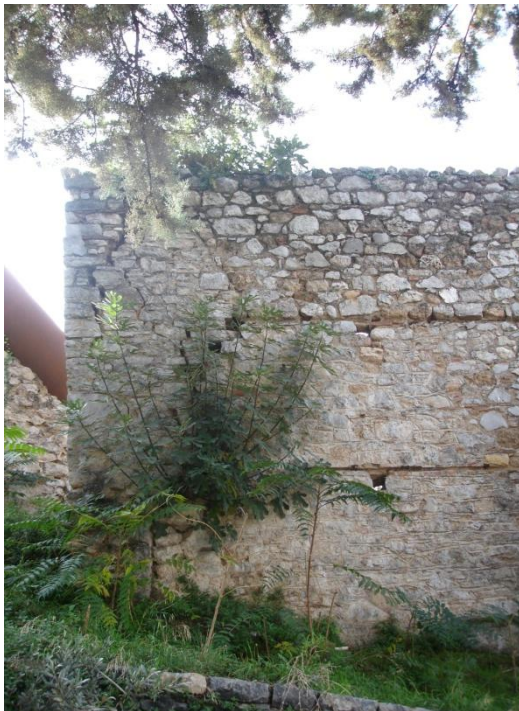
εικ. 65: οι ψευδοπολυγωνικοί αρμοί του τοίχου που περιβάλλει τη φτερωτή
