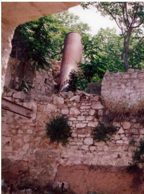
εικ. 69: επεμβάσεις στην βορειοανατολική τοιχοποιία για την εισαγωγή του μεταλλικού βαγενιού.
