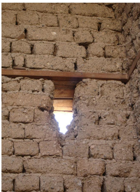
εικ. 85: ξυλοδεσιές όπως φαίνονται από τις σκαλότρυπες του μεσότοιχου
