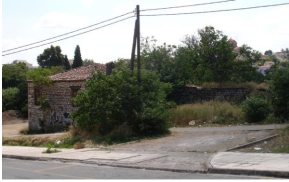
εικ. 13: Φωτογραφία (2015) από τον μύλο του Καραμαγκιώλη. Δεξιά φαίνεται τμήμα του πέτρινου τοίχου που στην άνω του πλευρά υπήρχε αυλάκι που έρεε νερό για την κίνηση του νερόμυλου.
