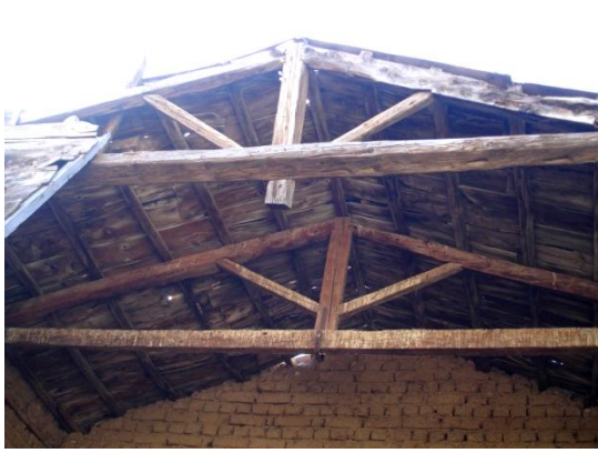
εικ. 90, 91: φωτογραφίες της στέγης της αποθήκης. Δεξιά φαίνονται και υπολείμματα του κονιάματος αργίλου.
