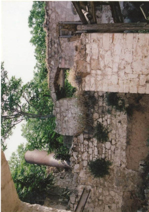
φωτογραφία 5 Ιουνίου 1993, αρχείο Στέφανου Νομικού είναι εμφανής η ανακατασκευή της τοιχοποιίας για την εισαγωγή του βαγονιού
