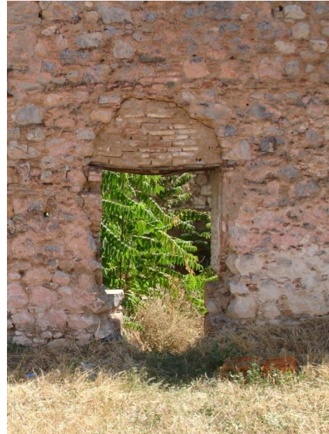
εικ. 68: διαμόρφωση ανοίγματος με ξύλινο οριζόντιο πρέκι στη θέση παλιότερου τζακιού
