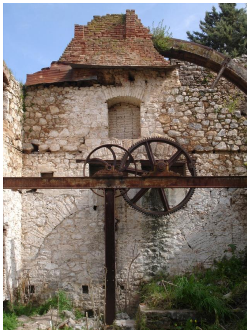
εικ. 70: ο εσωτερικός βόρειος τοίχος
