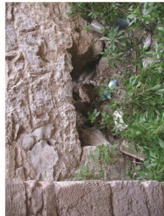
η τρύπα στο βόρειο τοίχο για την εξομάλυνση του νερού
