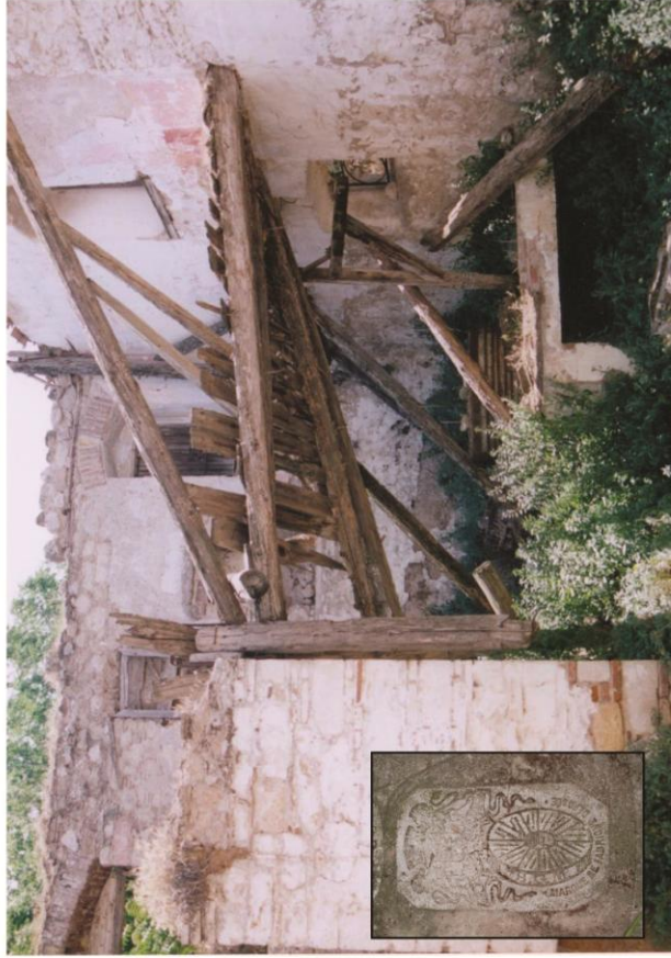
φωτογραφία 5 Ιουνίου 1993, αρχείο Στέφανου Νομικού είναι εμφανής η μύλoπετρα και το ξύλινο πατάρι εντοπίζεται αριστερά και τμήμα ζευκτού της οροφής. Σε λεπτομέρεια κάτω αριστερά, το λογότυπο της πέτρας της γαλλικής βιομηχανίας μύλοπετρών Soci te Generale Meuliere (1884-1951).
