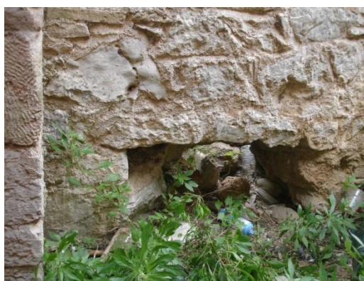
εικ. 71: διάνοιξη τρύπας για την έξοδο των νερών
