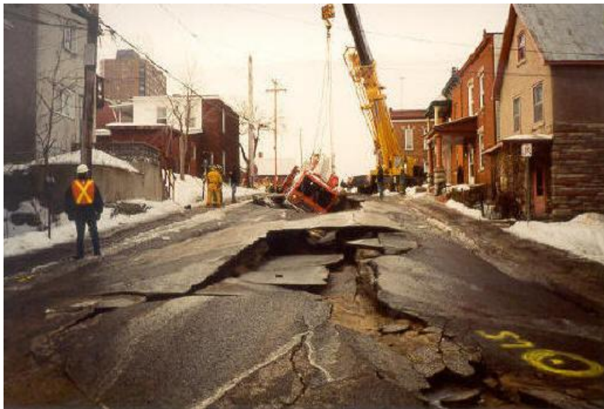
Εικόνα 1.10: Διάβρωση Εδάφους λόγω Έντονων Θερμοκρασιακών Αλλαγών
