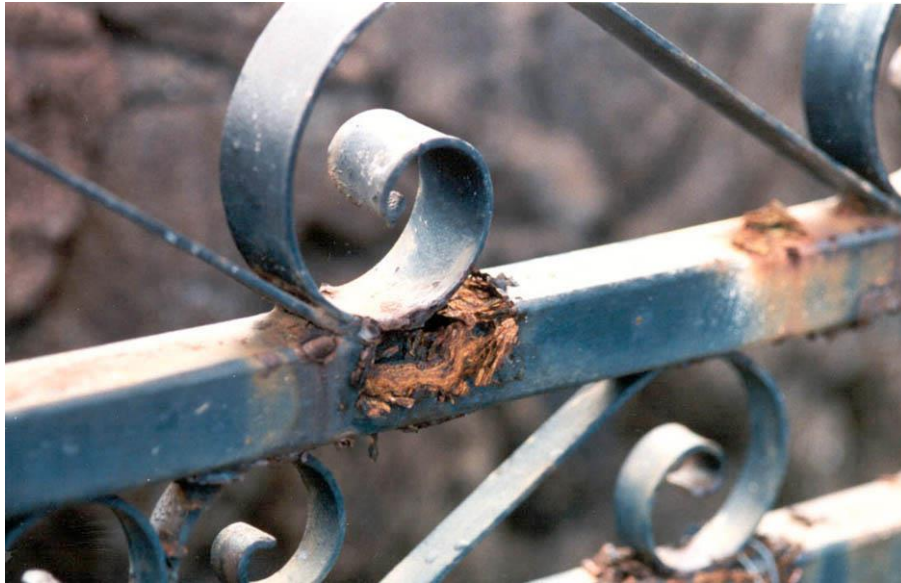
Εικόνα 1.9: Διάβρωση λόγω ύπαρξης διεπιφάνειας
