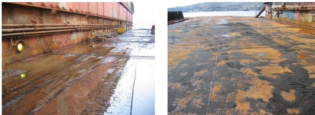
Εικόνα 6.3: Επιφάνεια Πλωτής Δεξαμενής γεμάτη αποξηστικό που συνεισφέρει στην διάβρωση.
