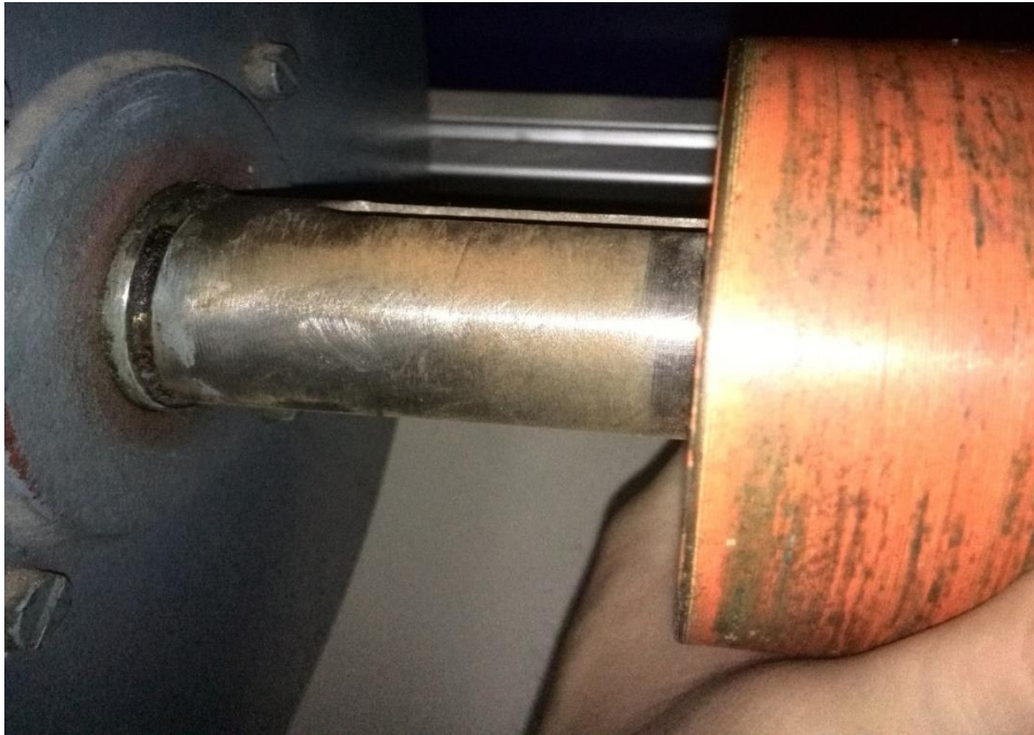
Εικόνα 6.2- Παράδειγμα Σφηναύλακα επί άξονα
