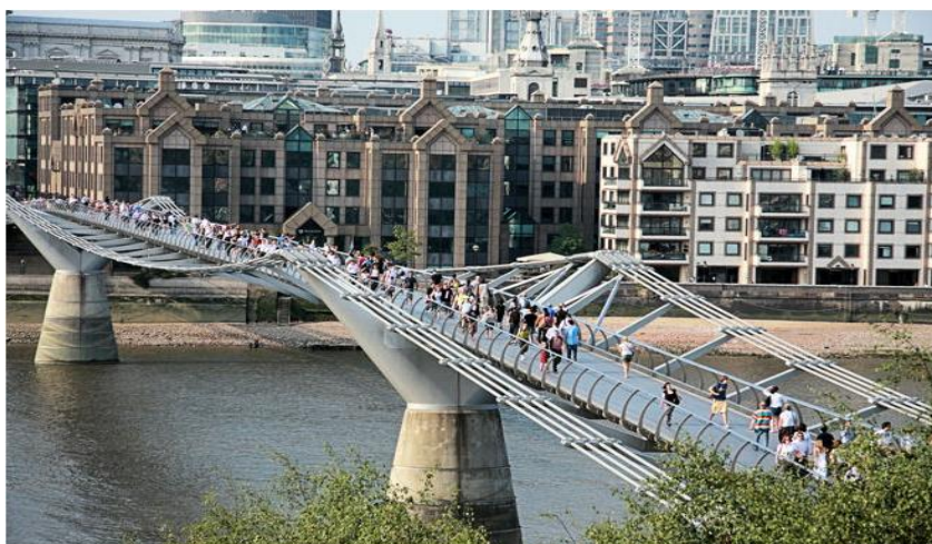
Σχήμα 8.1: Άποψη της πεζογέφυρας Millenium Bridge στο Λονδίνο, στην οποία εμφανίστηκαν έντονα δυναμικά φαινόμενα λόγω της κίνησης των πεζών.
