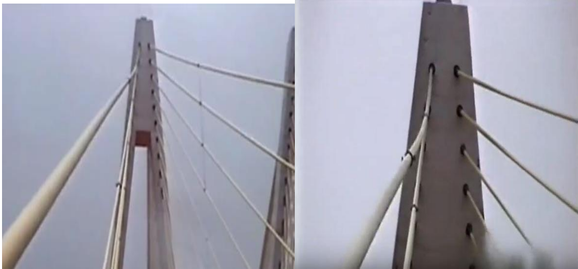
Σχήμα 10.4: Μεγάλοι πλάτους ταλαντώσεις καλωδίων στην γέφυρα Fred Hartmann λόγω του συνδυασμού ανέμου/βροχής.
