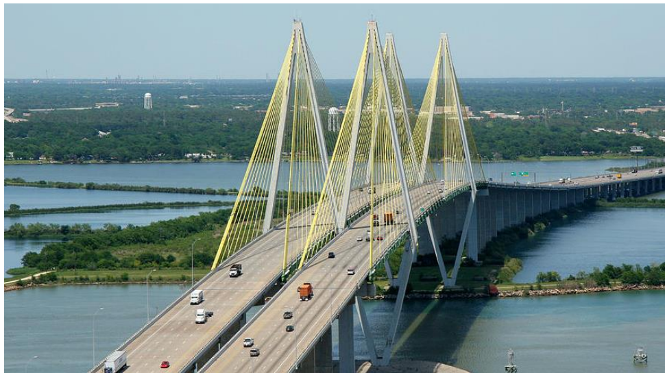
Σχήμα 10.3: Η καλωδιωτή γέφυρα Fred Hartmann στο Τέξας των Η.Π.Α, όπου παρατηρήθηκαν τέτοιας μορφής ταλαντώσεις.
