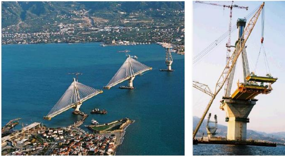
Σχήμα 5.1: Προβολοδόμηση στην Γέφυρα Ρίου-Αντιρρίου «Χαρίλαος Τρικούπης».
