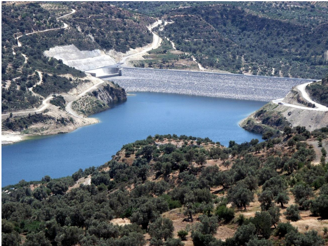
Εικόνα 2.1: Φράγμα Φανερωμένης Πηγή: www.elter.gr , Ιούνιος 2015
