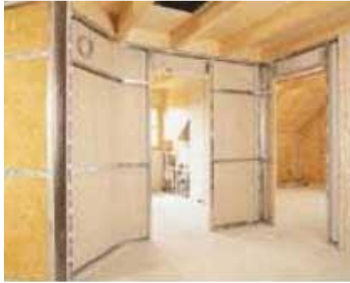
Σχήμα 1.9: Συστήματα εσωτερικής τοιχοποιίας από γυψοσανίδες
