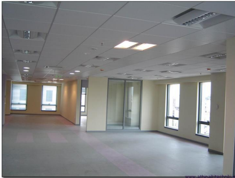
Σχήμα 1.11: Ψευδοροφή σε κτίριο γραφείων
