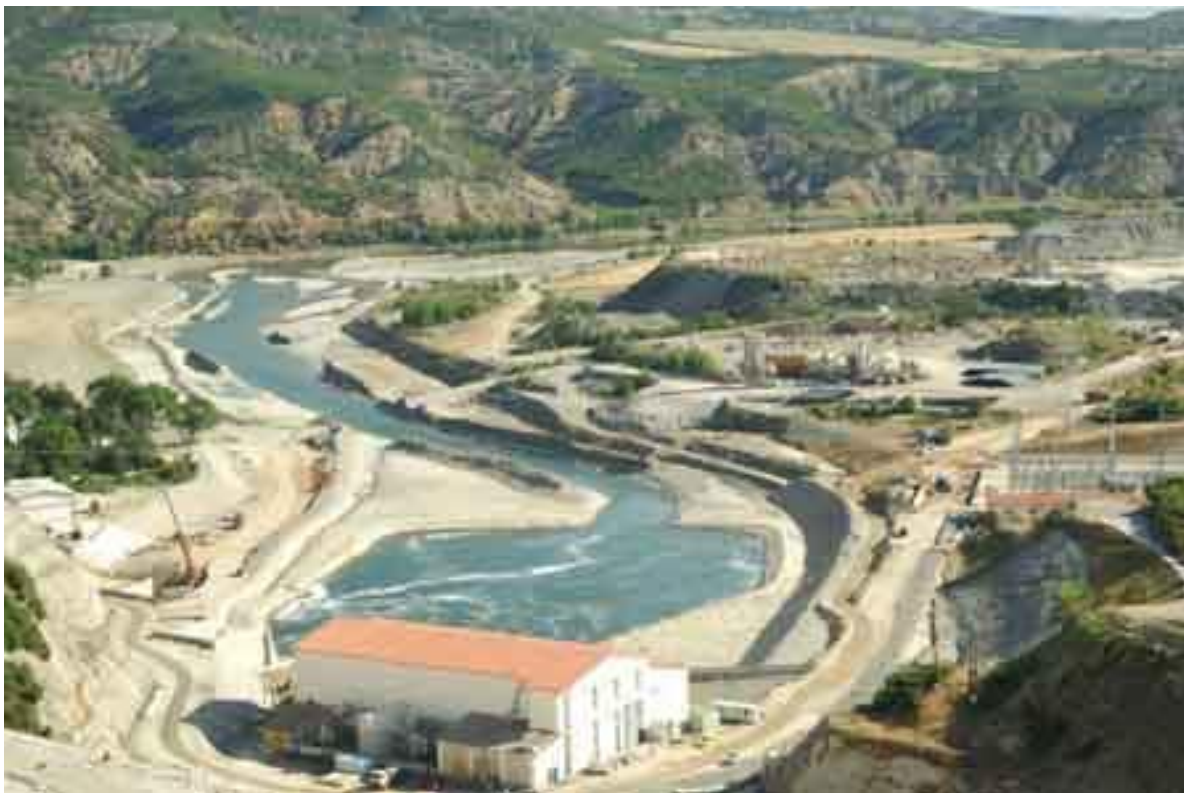
Σχήμα 16: Φωτογραφία από το υπο κατασκευή έργο του Ιλαρίωνα
