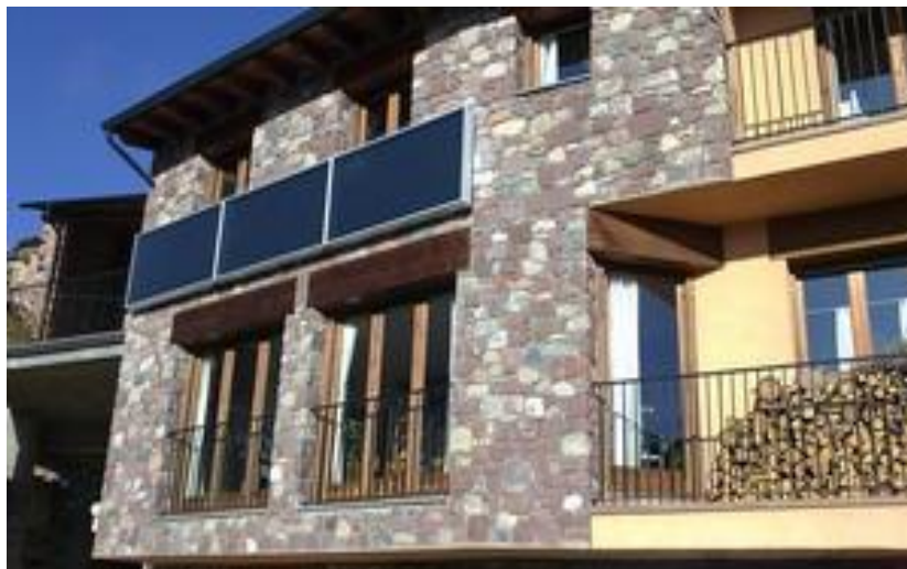
Σχήμα 52: Υβριδικό φωτοβολταϊκό – θερμικό σύστημα με μέσο ψύξης τον αέρα
