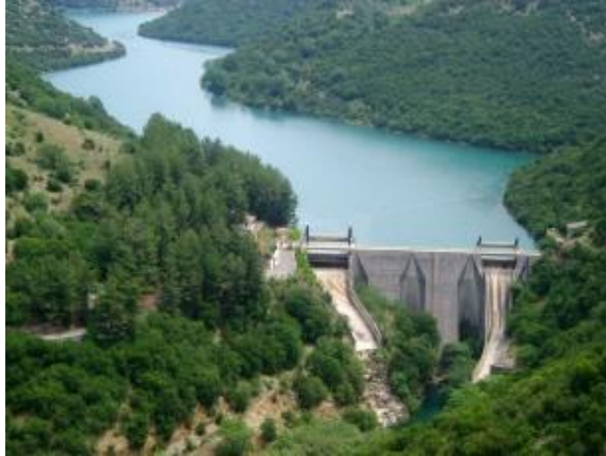
Σχήμα 13: Υδροηλεκτρικό φράγμα περιοχής Λάδωνα
