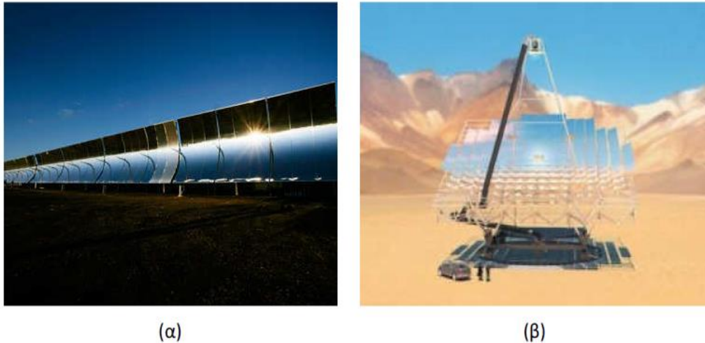
Σχήμα 20: Συγκεντρωτικοί ηλιακοί συλλέκτες γραμμικής εστίασης (α) και σημειακής εστίασης (β)
