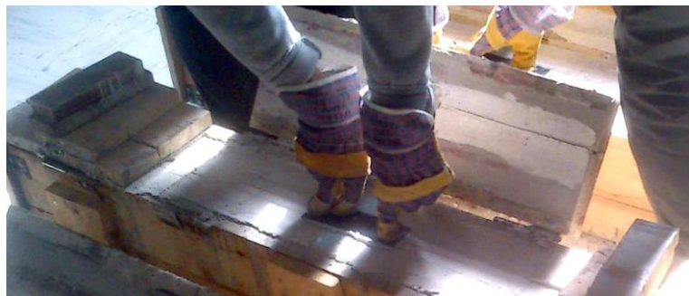
Σχήμα 3.6 Επικόλληση ελασμάτων με χρήση εποξειδικής ρητίνης
