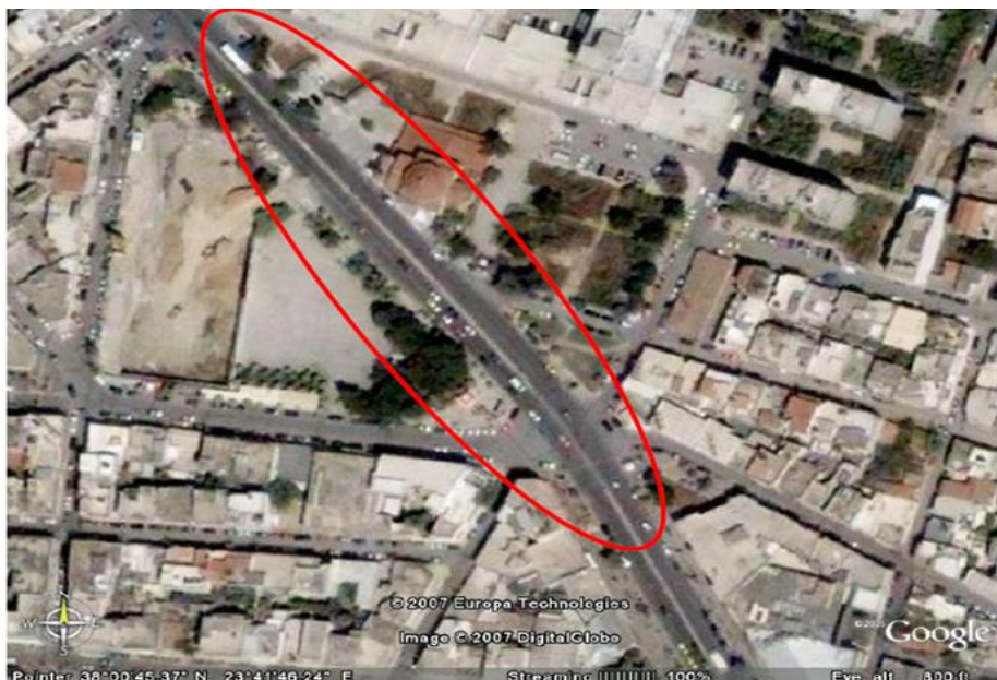
Εικόνα 2. 5. Αεροφωτογραφία της στενής περιοχής κατασκευής Σταθμού «Περιστέρι»
