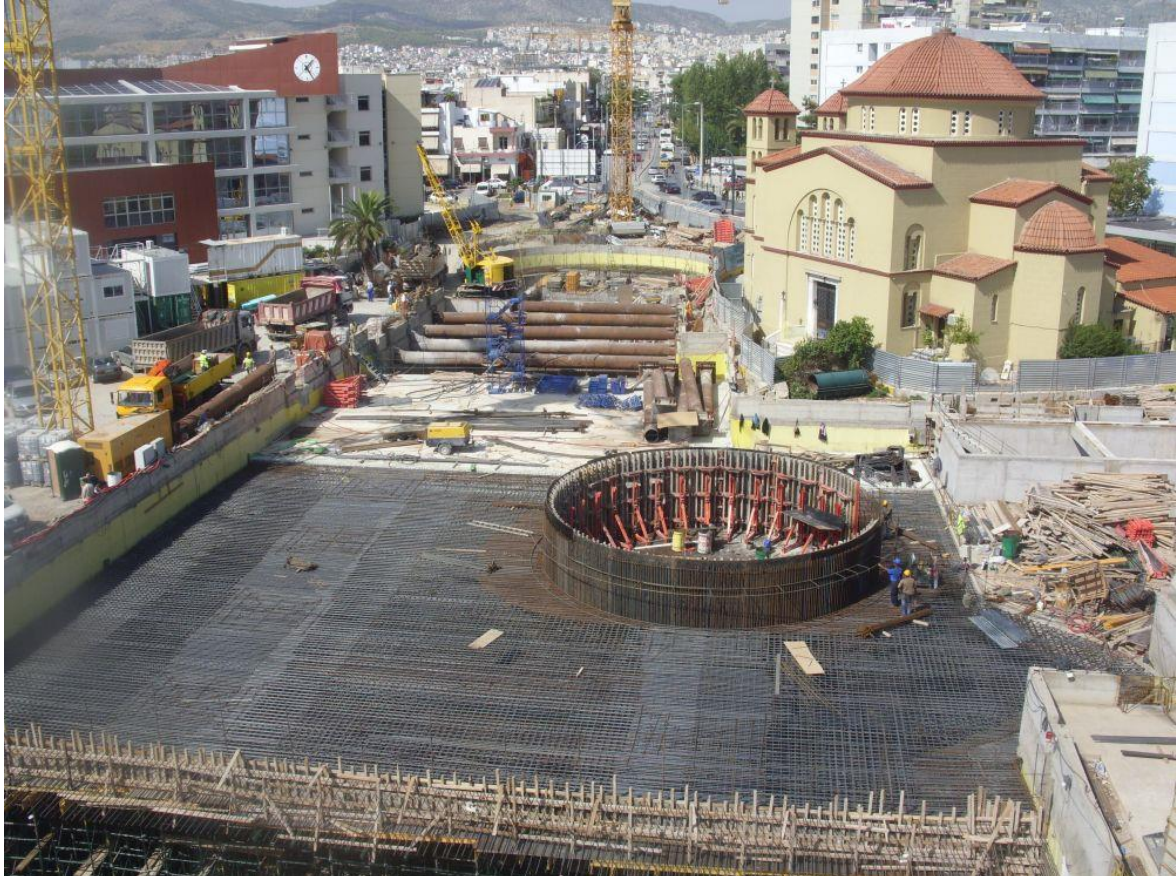
Εικόνα 4.1 .Σύστημα αντιστήριξης με αντηρίδες στην περιοχή του Ι.Ν. Ευαγγελιστρίας ( www.ametro.gr )
