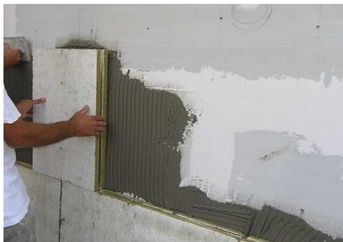
Εικόνα 5.6 - Άποψη από την τοποθέτηση των VIPs στην τοιχοποιία
