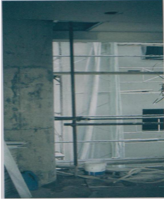
Φωτ #5.11.2# Σωστή σύνδεση σκαλωσιάς με οικοδομή, ([3])
