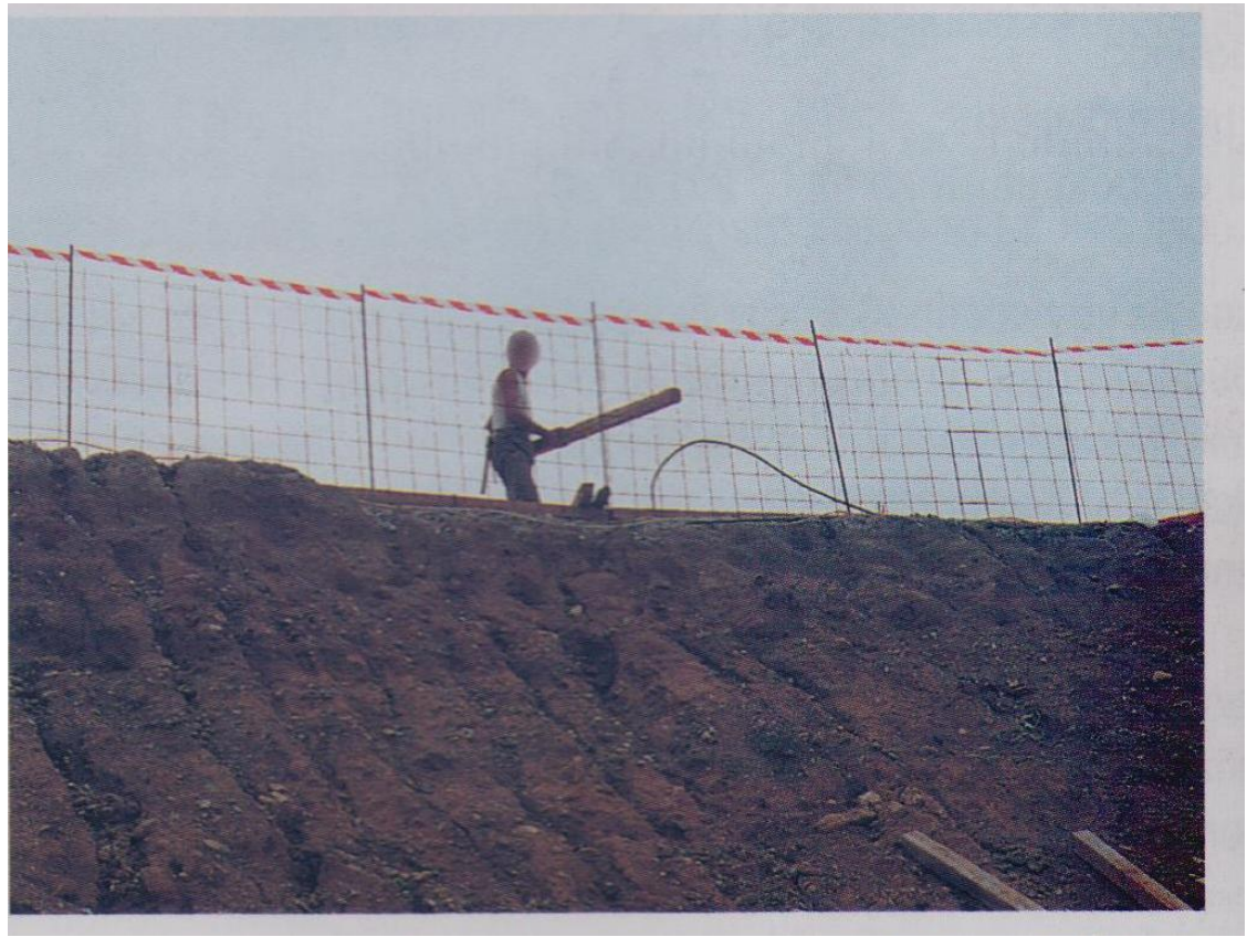
Φωτ. #5.2.3#: Κατάλληλη περίφραξη εκσκαφής, ([3])
