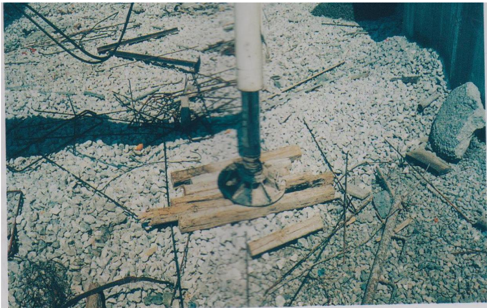
Φωτ #5.8.1.# Λανθασμένη έδραση ποδαρικών αντλίας (απαιτείται έδαφος χωρίς χαλίκια και έδραση σε τάκους), ([3])
