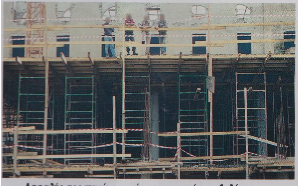
Φωτ#5.7.1# Καλή προστασία πέρατος ξυλότυπου, ([3])
