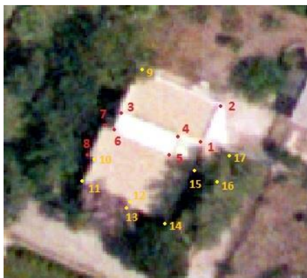
Εικόνα 6.14: Χαρακτηριστικά σημεία κτίσματος 2 και δώματος επί αυτού.
