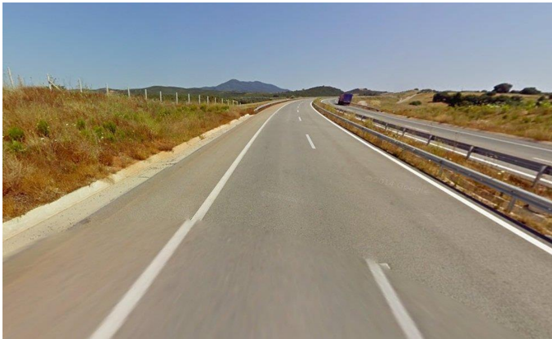
Εικόνα 25. Άποψη του οδικού τμήματος 4 στη Χ.Θ. = 9 + 470
