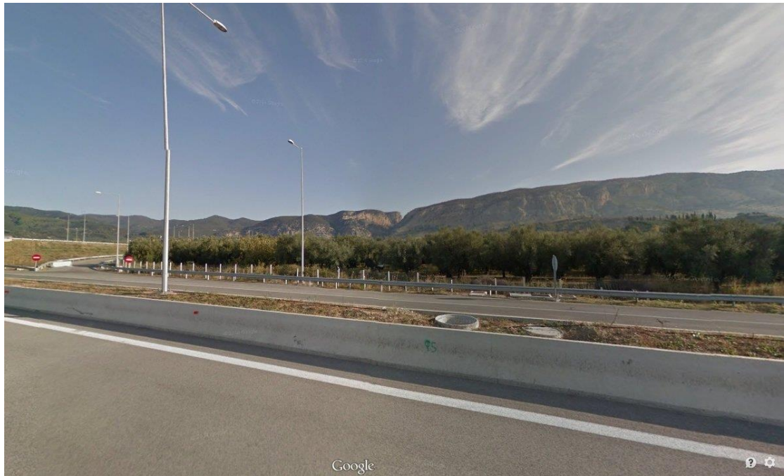
Εικόνα 21. Άποψη του τρίτου οδικού τμήματος μελέτης στη Χ.Θ. = 3 + 400 (στην πλευρά του οδηγού)
