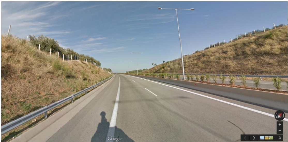
Εικόνα 33. Όψη του υπό εξέταση οδικού τμήματος
