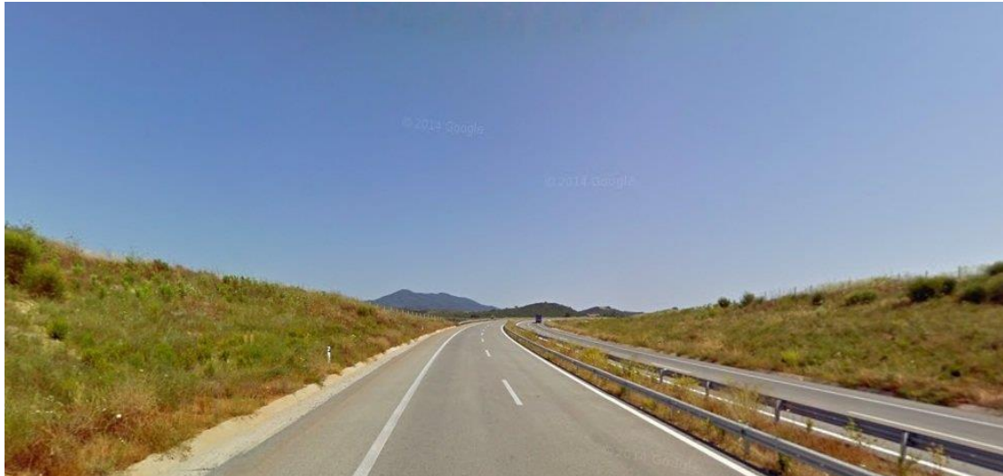
Εικόνα 24. Άποψη του οδικού τμήματος 4 στη Χ.Θ. = 9 + 420
