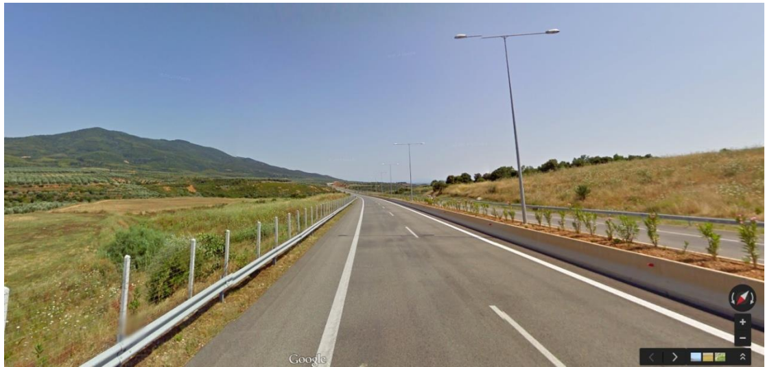
Εικόνα 36. Όψη του υπό εξέταση οδικού τμήματος
