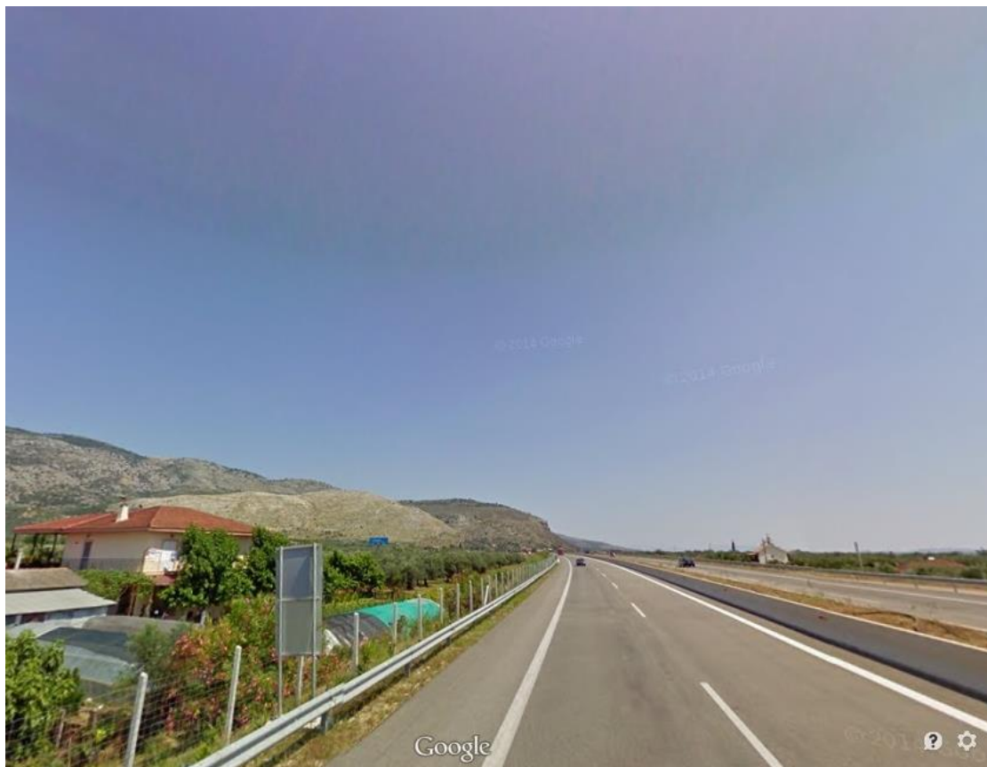
Εικόνα 10. Άποψη του οδικού τμήματος 1 στη Χ.Θ. = 2 + 320
