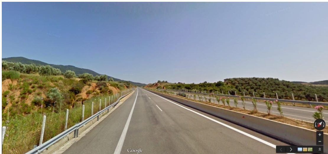
Εικόνα 35. Όψη του υπό εξέταση οδικού τμήματος
