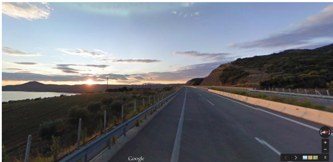
Εικόνα 31. Όψη του υπό εξέταση οδικού τμήματος
