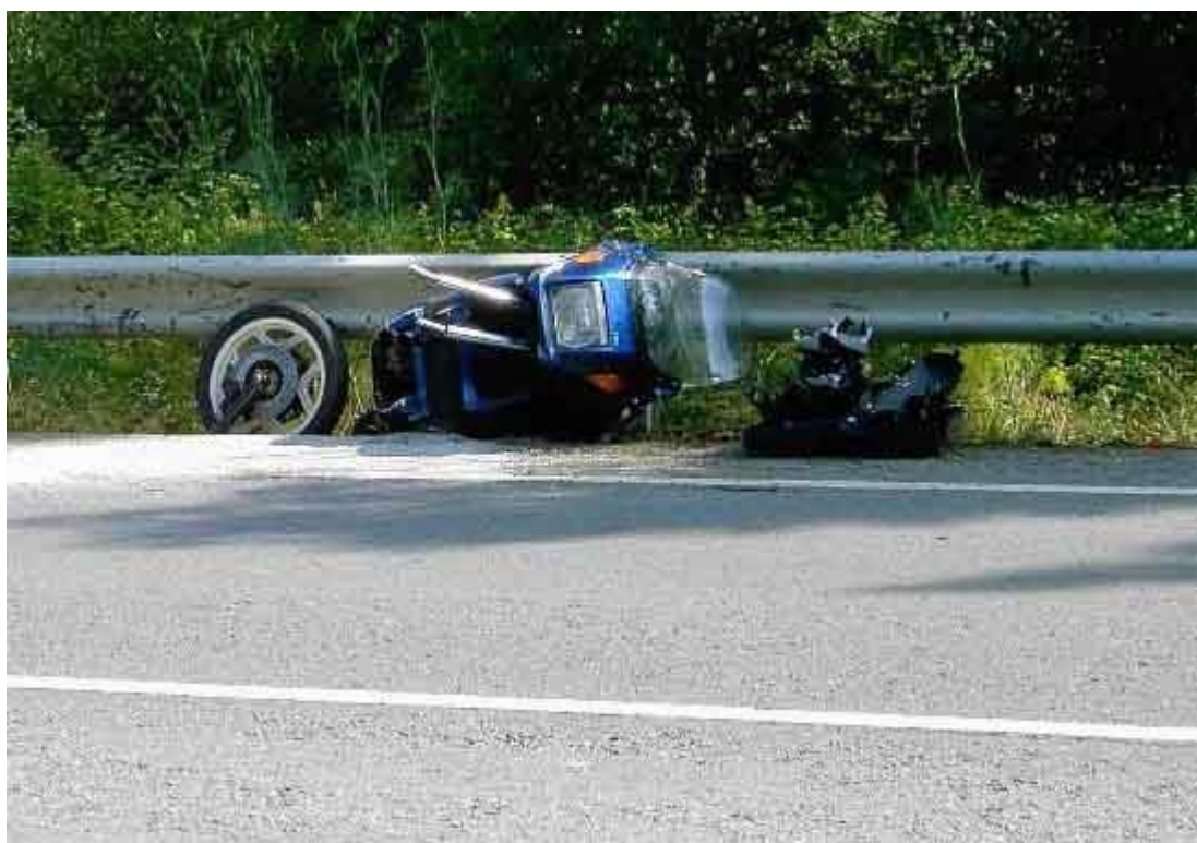
Εικόνα 37. Μεταλλικό στηθαίο ασφαλείας χωρίς οριζόντιο έλασμα
