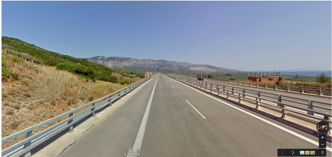
Εικόνα 32. Όψη του υπό εξέταση οδικού τμήματος
