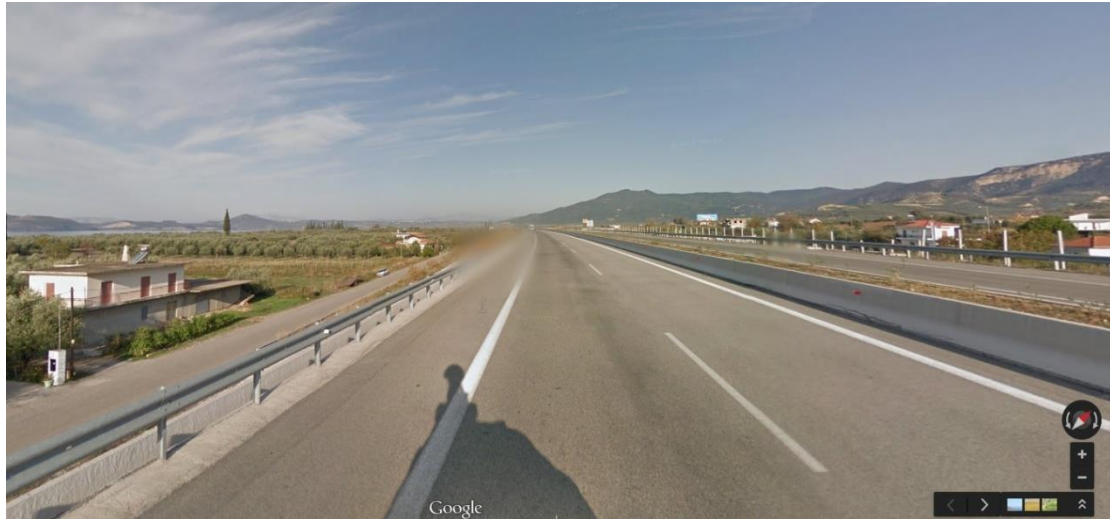
Εικόνα 28. Όψη του υπό εξέταση οδικού τμήματος
