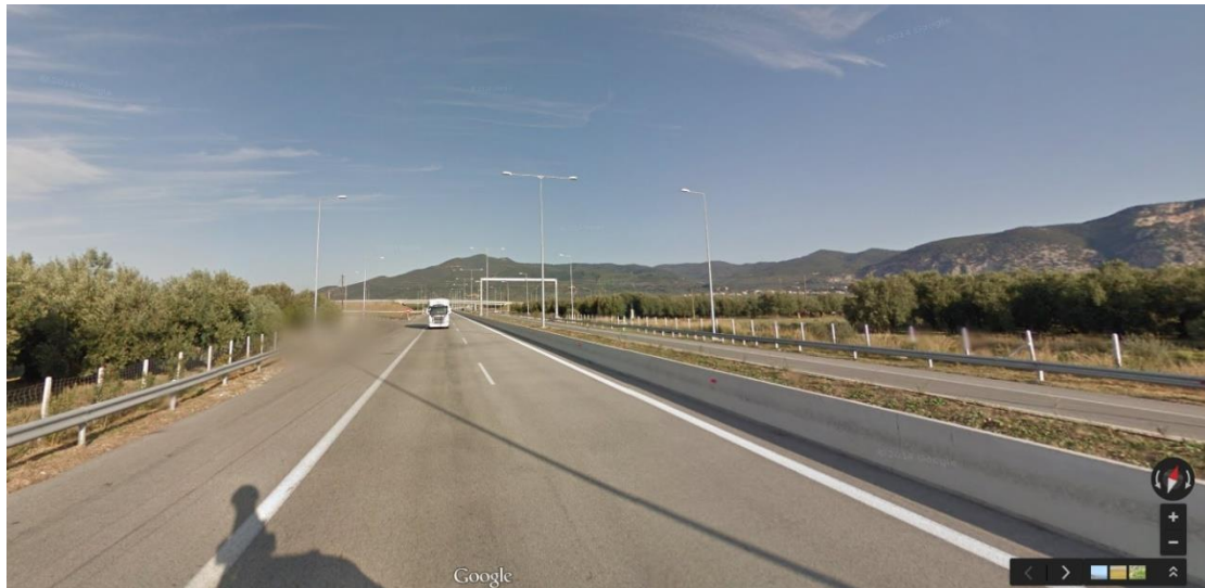
Εικόνα 30. Όψη του υπό εξέταση οδικού τμήματος
