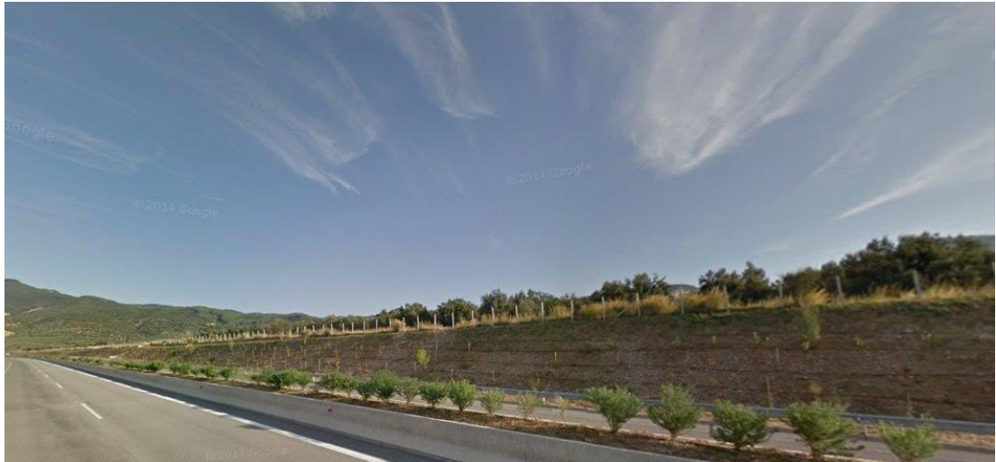
Εικόνα 16. Άποψη του οδικού τμήματος 2 στη Χ.Θ. = 4 + 770 (στην πλευρά του οδηγού)
