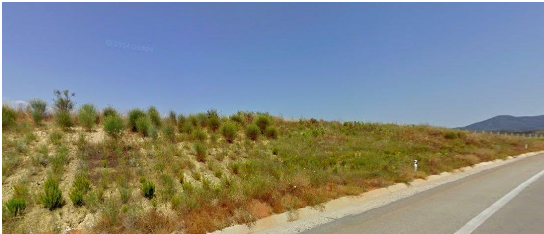
Εικόνα 27. Άποψη του οδικού τμήματος 4 στη Χ.Θ. = 9 + 420 (στην πλευρά του συνοδηγού)
