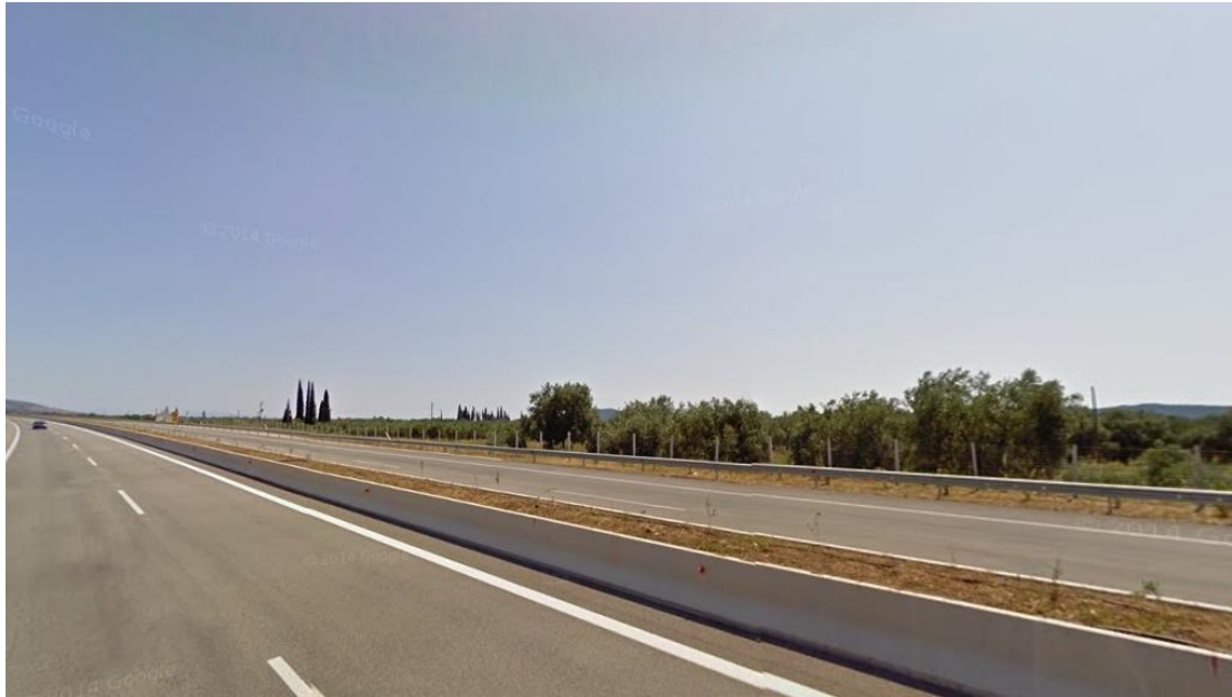
Εικόνα 11. Άποψη του οδικού τμήματος 1 στη Χ.Θ. = 2 + 270 (πλευρά του οδηγού)
