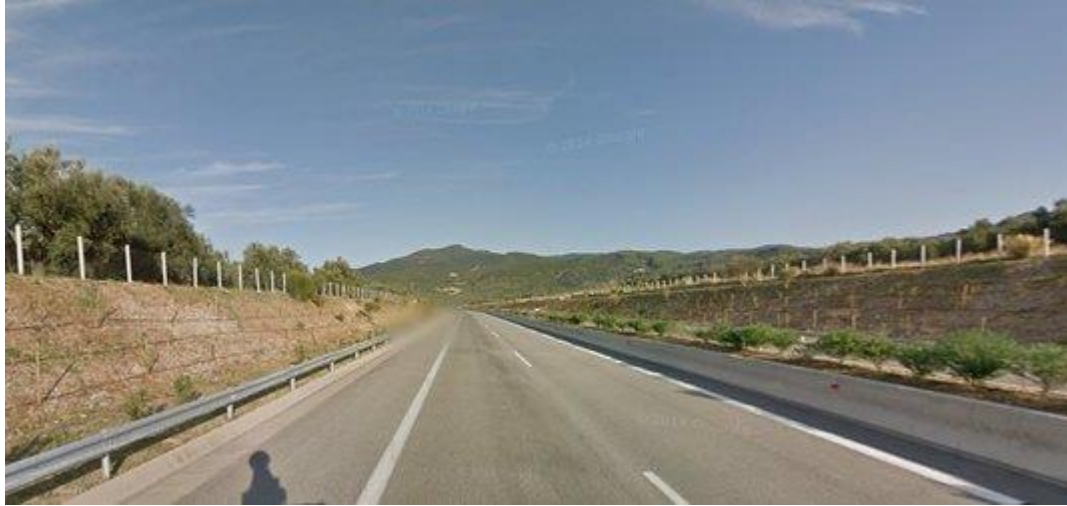
Εικόνα 14. Άποψη του οδικού τμήματος 2 στη Χ.Θ. = 4 + 770
