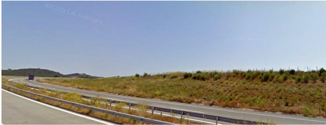
Εικόνα 26. Άποψη του οδικού τμήματος 4 στη Χ.Θ. = 9 + 420 ( στην πλευρά του οδηγού)
