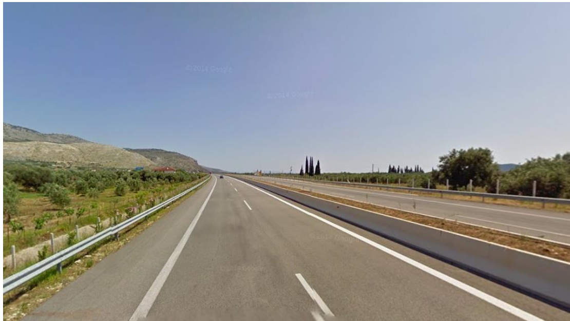
Εικόνα 9. Άποψη του οδικού τμήματος 1 στη Χ.Θ. = 2 + 270
