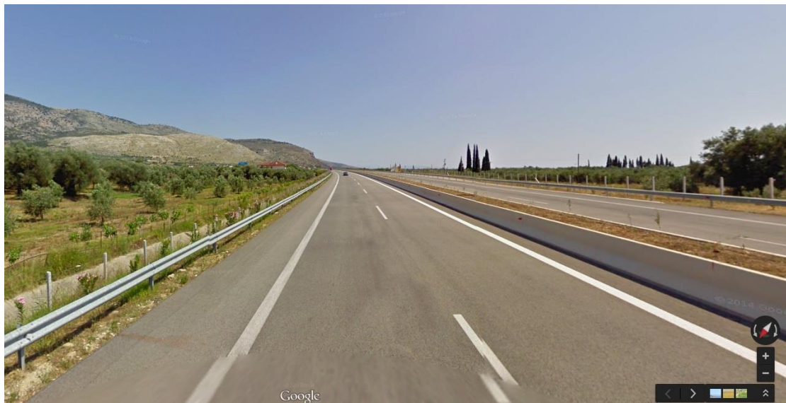
Εικόνα 29. Όψη του υπό εξέταση οδικού τμήματος
