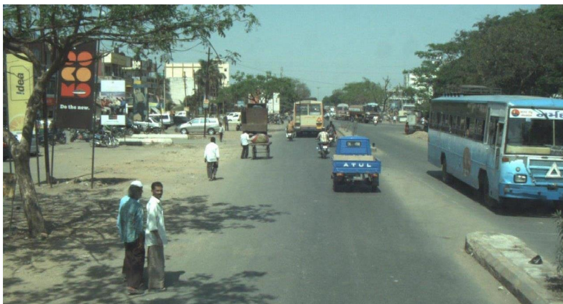
Εικόνα 1. Αποψη του υπό εξέταση δρόμου του παραδείγματος
