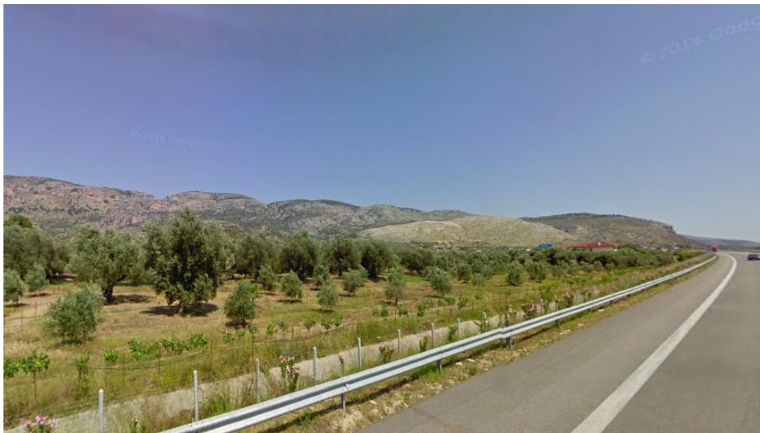
Εικόνα 12. Άποψη του οδικού τμήματος 1 στη Χ.Θ. = 2 + 270 (πλευρά του συνοδηγού)
