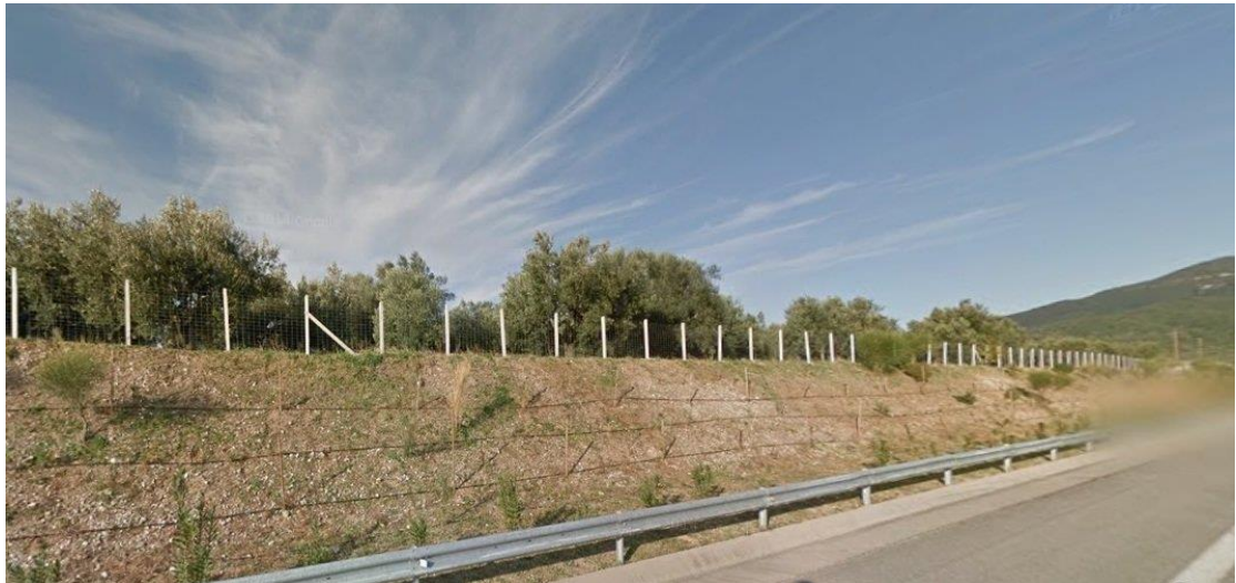
Εικόνα 17. Άποψη του οδικού τμήματος 2 στη Χ.Θ. = 4 + 770 (στην πλευρά του συνοδηγού)
