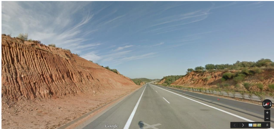
Εικόνα 34. Όψη του υπό εξέταση οδικού τμήματος
