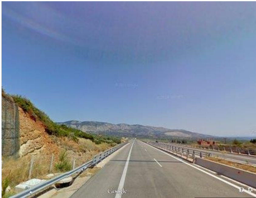
Εικόνα 15. Άποψη του οδικού τμήματος 2 στη Χ.Θ. = 4 + 820
