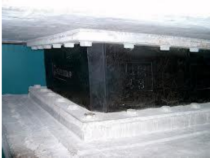
Σχήμα 1.2.2 Ελαστικά εφεδρανα στη βάση ενός υπό ανέγερση κτηρίου
