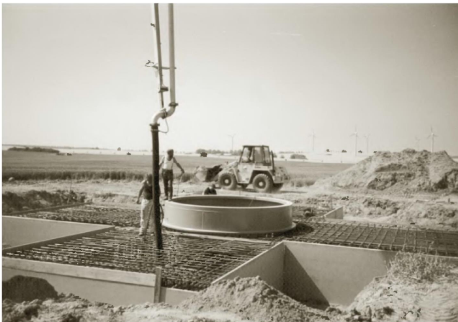
Σχήμα 1-18: θεμελίωση μεγάλης εμπορικής ανεμογεννήτριας [1]
