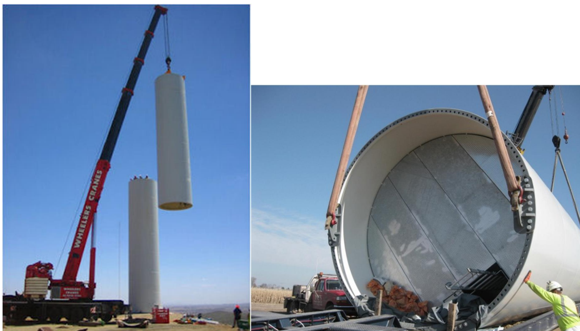
Σχήμα 1-14: ανέγερση τμήματος πυλώνα (πηγή: www.windlab.com & diamondtowerservice.com )
