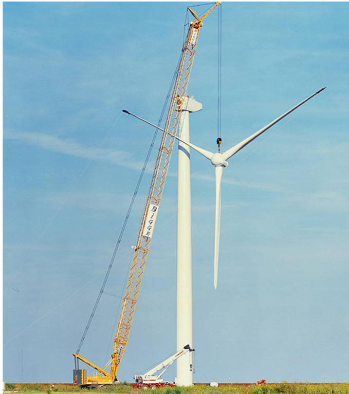
Σχήμα 1-15: ανέγερση πτερυγίων (πηγή: www.bigge.com )
