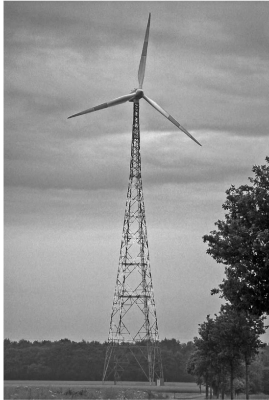
Σχήμα 1-7: δικτυωτός πυλώνας ανεμογεννήτριας Vestas V80 [1]
