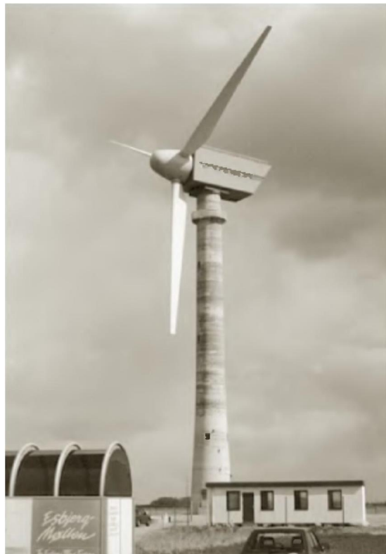
Σχήμα 1-8: πυλώνας από οπλισμένο σκυρόδεμα πειραματικής ανεμογεννήτριας [1]
