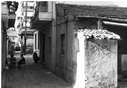
94 | άποψη πρόσβασης σε εσωτερικό Ο.Τ.
