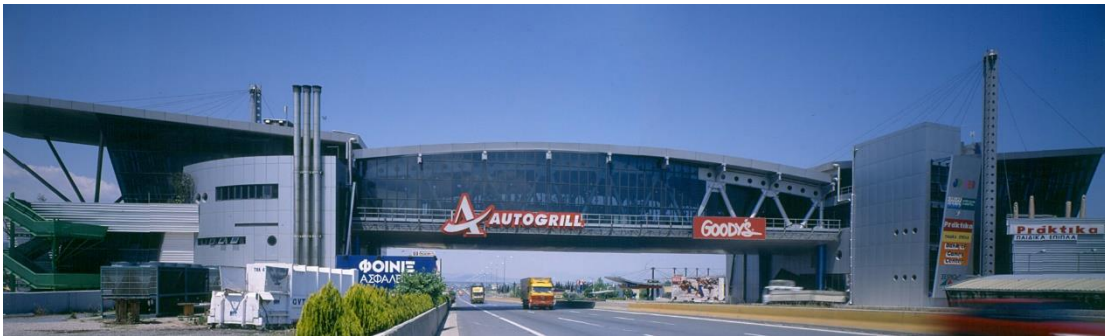
Εικόνα 2-1 Στεγασμένη γέφυρα - Breezeway
