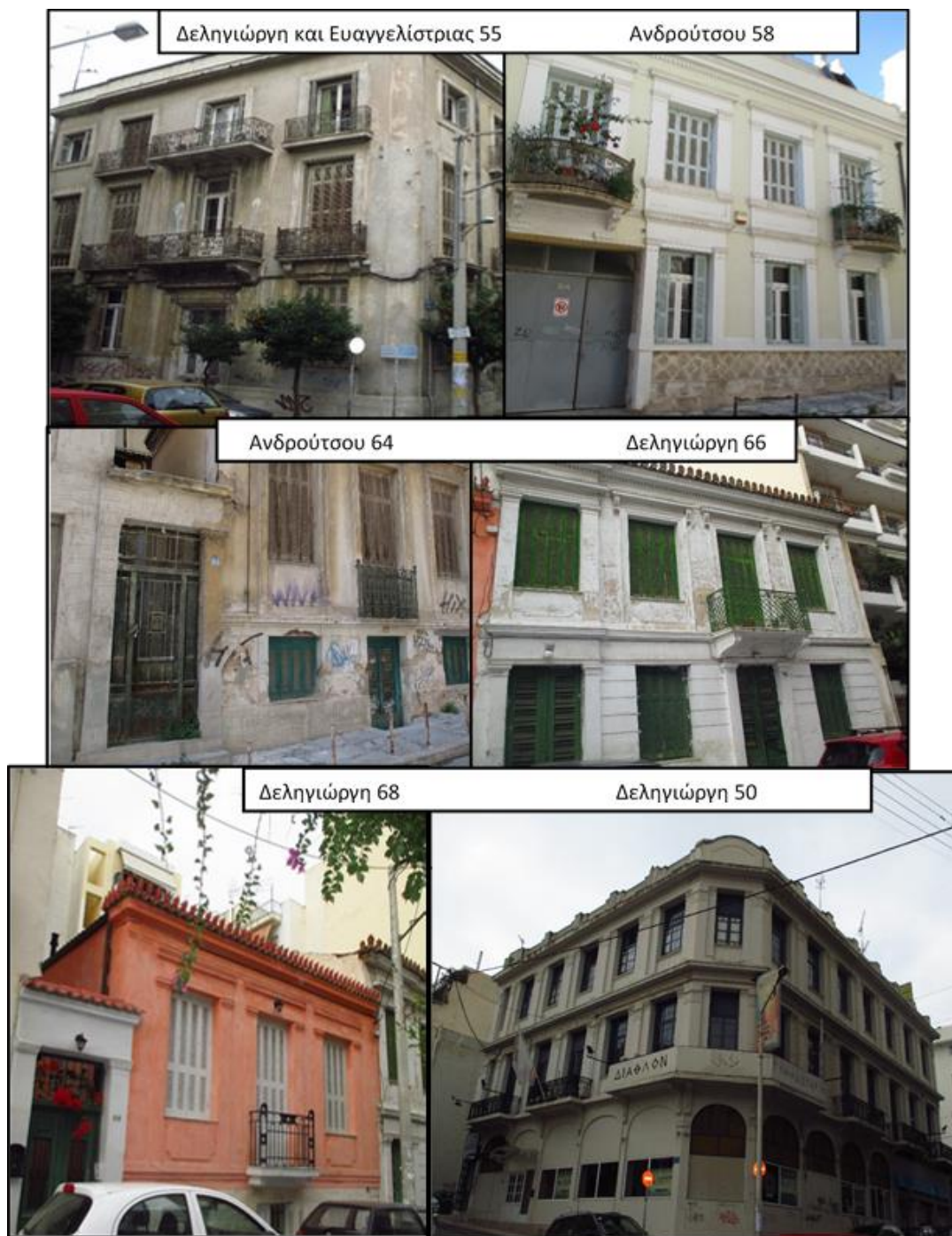
Εικόνα 1.7: Διατηρητέα κτίρια στην Συνοικία της Ευαγγελίστριας
