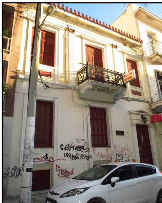
Εικόνα 3.4: Διατηρητέο κτίριο καλής δομικής κατάστασης στην οδό Λουκά Ράλλη 113
