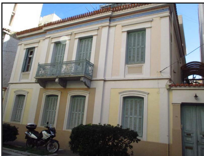
Εικόνα 3.7: Διατηρητέο κτίριο αποκατεστημένο στην οδό Αριστοτέλους 7, 7Α
