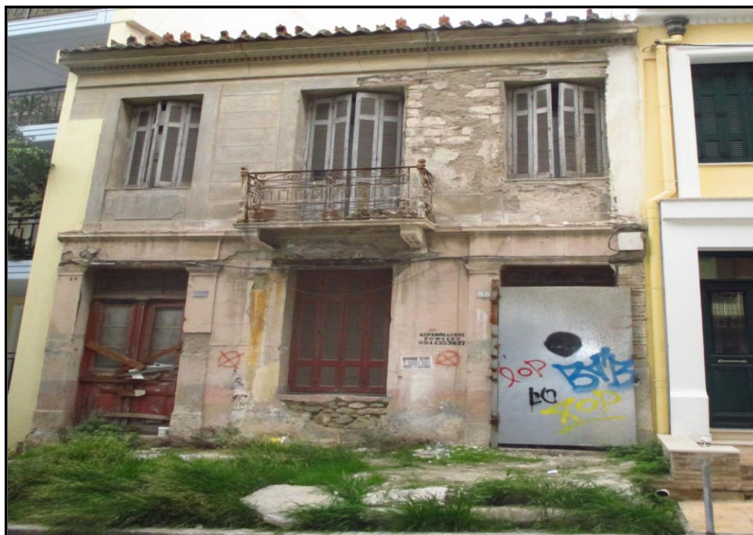
Εικόνα 3.14: Εγκαταλελειμμένο Διατηρητέο κτίριο επί της οδού Διστόμου 59
