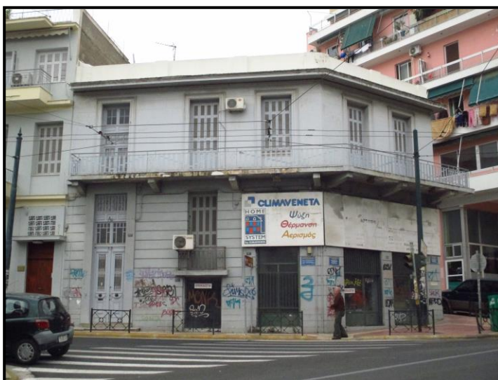
Εικόνα 3.12: Κενό Διατηρητέο κτίριο καλής δομικής κατάστασης επί της Λεωφόρου Βασιλέως Παύλου 157
