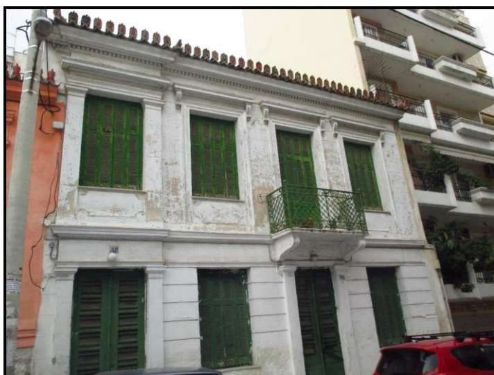
Εικόνα 3.5: Διατηρητέο κτίριο μέτριας δομικής κατάστασης στην οδό Δεληγιώργη 66
