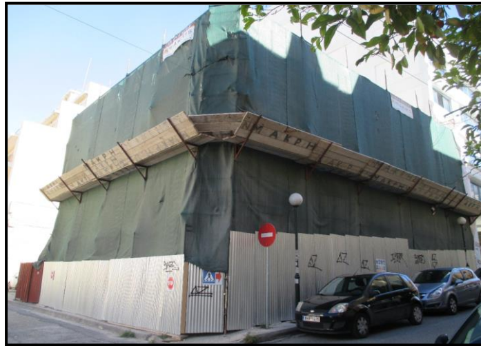
Εικόνα 3.8: Διατηρητέο κτίριο υπό αποκατάσταση στην οδό Ελευθερίου Βενιζέλου 9
