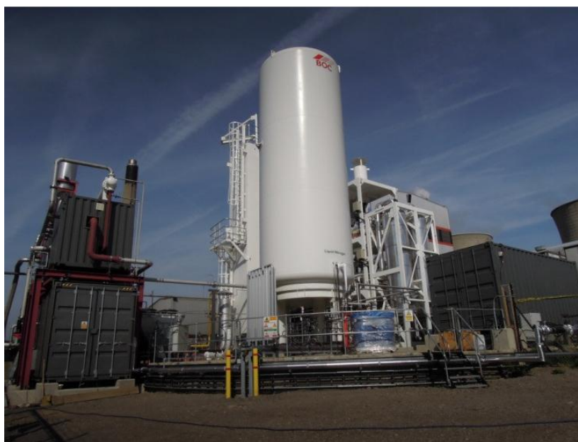
Εικόνα 2.1 Πιλοτική μονάδα LAES της εταιρίας Highview Power Storage (Liquid Air Technologies - a guide to the potential, 2013)
