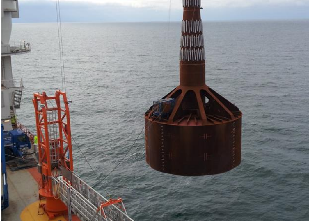
Εικόνα 3.8: Πόντιση κατασκευής με έδραση κενού/ αναρροφήσεως
