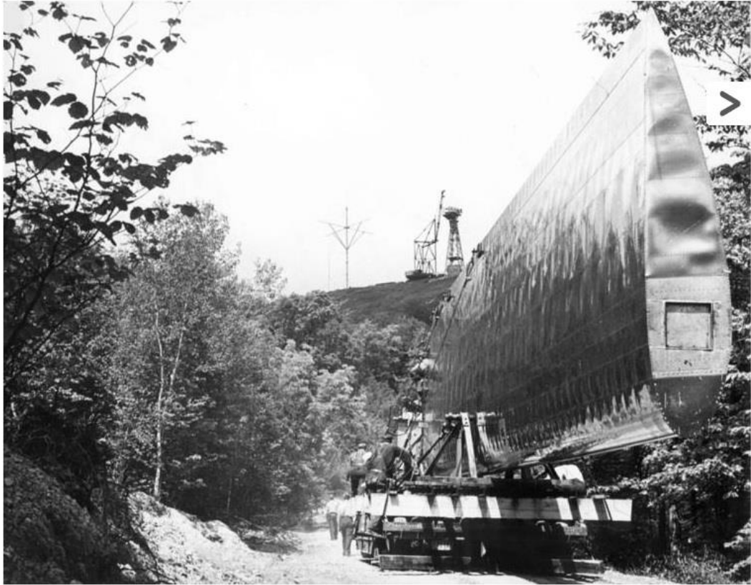
Εικόνα 2.6: Ανεμογεννήτρια οριζόντιου άξονα των Smith-Putman. Η μεταφορά της μιας λεπίδας ενώ στο βάθος φαίνεται ο πύργος. ( http://www.situstudio.com/blog/2010/09/01/smith-putnam )
