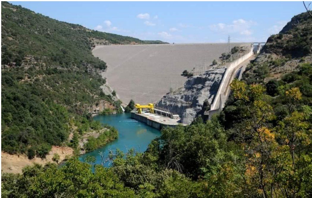
Εικόνα 1.7: Φράγμα και υδροηλεκτρικός σταθμός Κρεμαστών.
