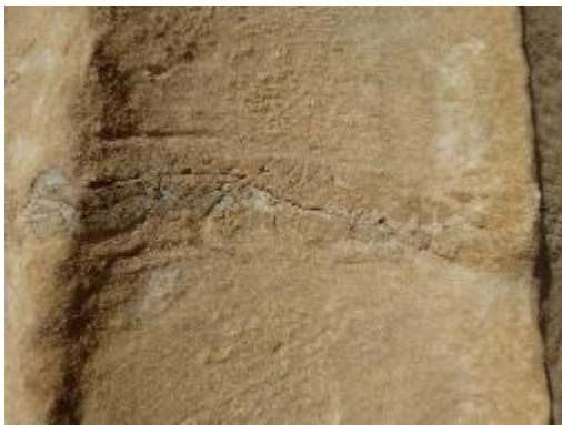
Εικόνα 3.1.4-10: Απώλεια προσμίξεων και ρηγματώσεις
