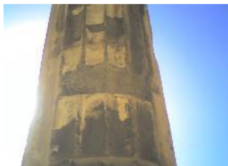
Εικόνα 3.1.4-9: Απώλεια υλικού στο 10ο κίονα
