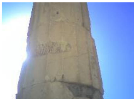
Εικόνα 3.1.4-8: Απώλεια υλικού στον 9ο κίονα
