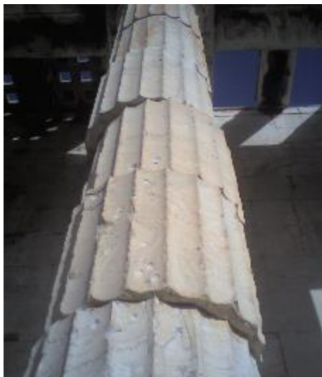
Εικόνα 3.1.4-6: Μετατόπιση σπονδύλων και σημάδια από σφαίρες στον 4ο κίονα
