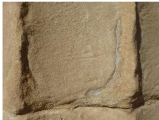
Εικόνα 3.1.4-11: Συμπλήρωση με κονίαμα στα σημεία που έχουν εκπλυθεί οι προσμίξεις
