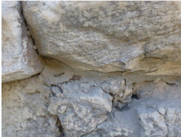
Εικόνα 3.1.4-23: Αρμολόγημα με κονίαμα τσιμέντου
