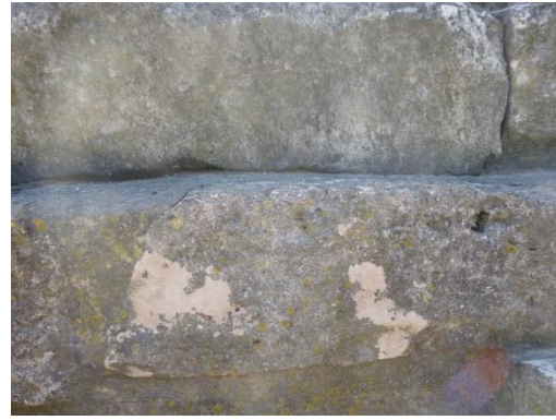
Εικόνα 3.1.4-27: Βιοδιάβρωση - Περιοχή που φαίνεται ο συμπαγής λίθος
