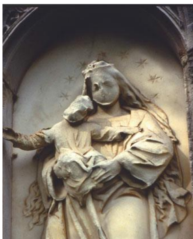
Εικόνα 1.2.4-2: Απομείωση λεπτομερειών στο γλυπτό εξαιτίας της απόπλυσης (36)
