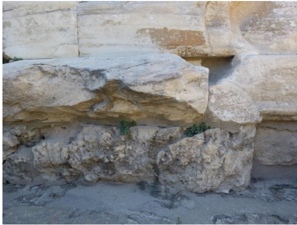
Εικόνα 3.1.4-22: Πορτοκαλοκάστανη κρούστα (μάλλον βιοδιάβρωση)
