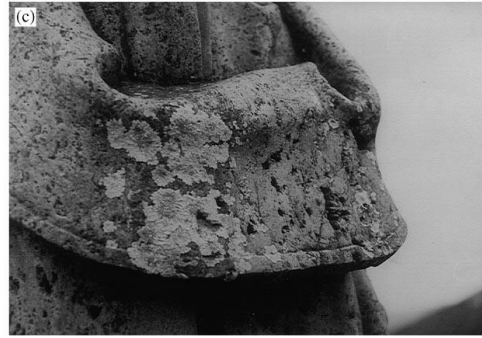
Εικόνα 1.2.6-4: Βελονοειδής διάβρωση εξαιτίας της ανάπτυξης λειχήνων σε δολομιτικά εγκλείσματα λίθου (51)
