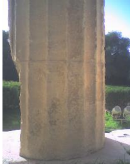
Εικόνα 3.1.4-4: Επιδερμίδα στη βόρεια όψη του 2ου κίονα
