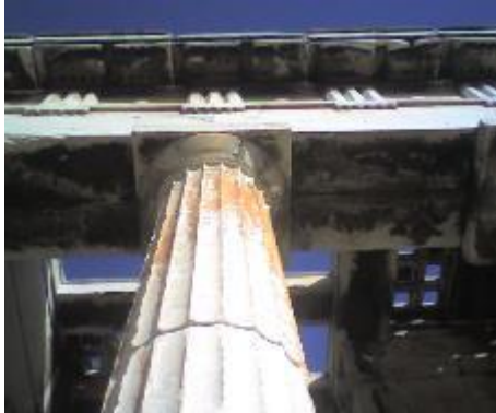
Εικόνα 3.1.4-3: Επιδερμίδα στη νότια όψη του 2ου κίονα
