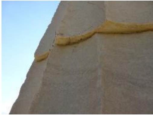
Εικόνα 3.1.4-15: Μικρή μετατόπιση σπονδύλων λόγω προσμίξεων
