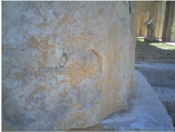
Εικόνα 3.1.4-20: Αποκόλληση επί των ραβδώσεων
