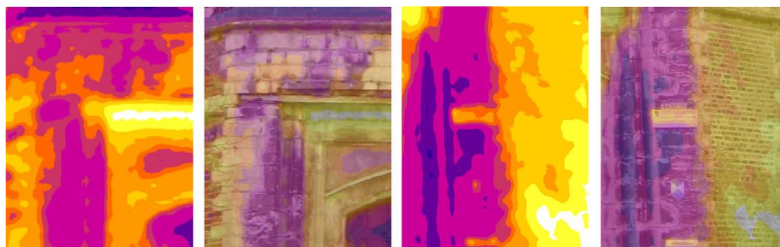
Εικόνα 2.1.8-2: Ανίχνευση υγρασίας στην τοιχοποιία (73)
