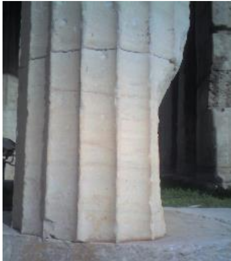
Εικόνα 3.1.4-5: Ρηγματώσεις στον 2ο κίονα
