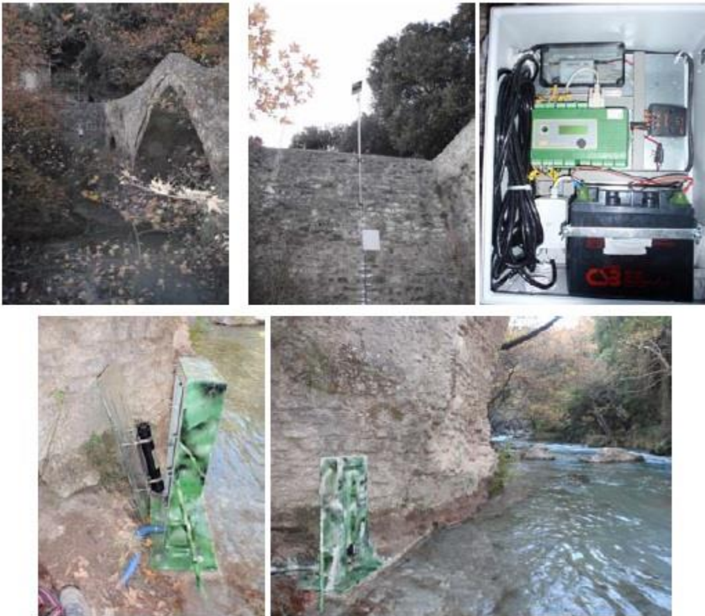
Εικόνα 2.17: Ροομετρικός σταθμός στη Γέφυρα Ατσίχολου (Κόυσης, 2012)
