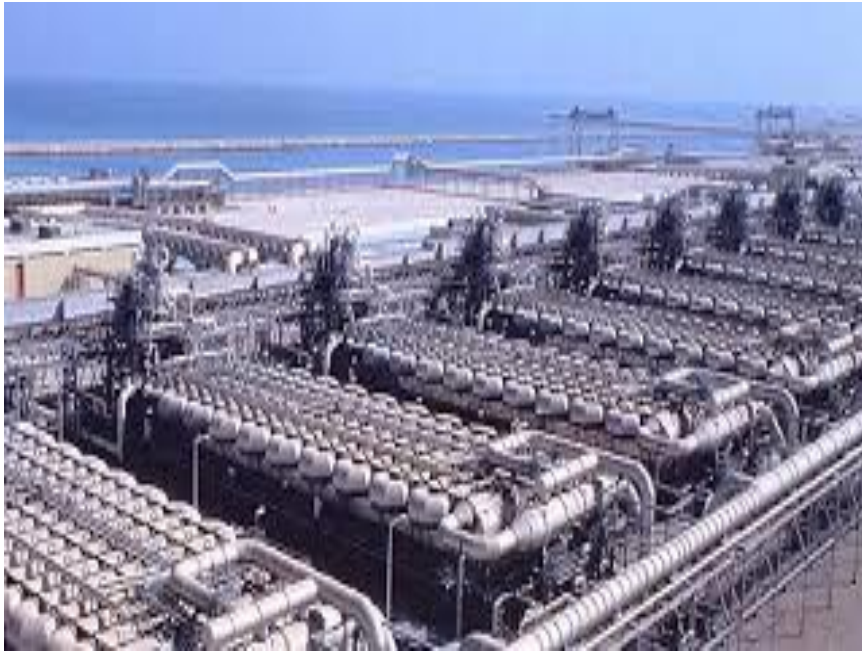
ΦΩΤ 2.3.1: ΕΓΚΑΤΑΣΤΑΣΗ ΠΟΛΥΒΑΘΜΙΑΣ ΑΚΑΡΙΑΙΑΣ ΕΞΑΤΜΙΣΗΣ
