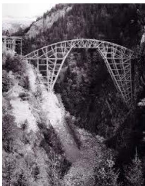
Εικ. 1.54 : Το ικριώμα της γέφυρας Salginatobel (1930)
