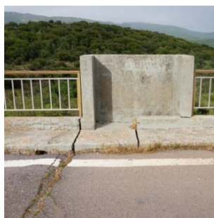
Εικ. 2.29 : Αρμόι καταστρώματος στην περιοχή του βορείου μεσοβάθρου
