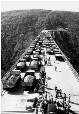
Εικ. 1.36 : Δοκιμαστική φόρτιση γέφυρας
