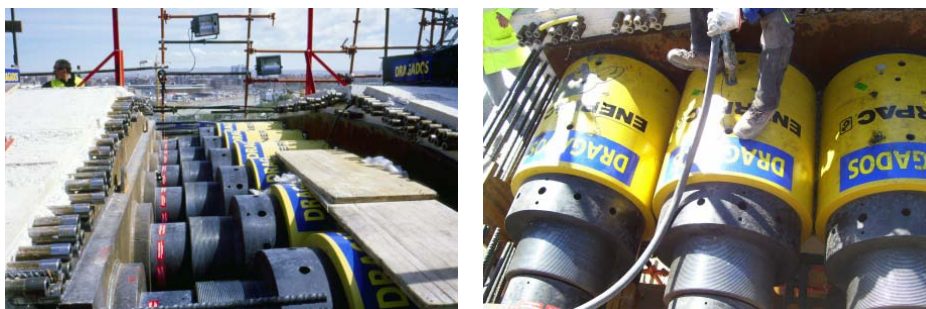
Εικ. 1.32,33 : Έμβολα στην κλείδα της γέφυρας Third Millenium bridge στη Zaragoza (2008)
