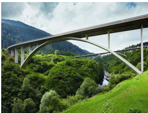
Εικ. 1.50 : Γέφυρες Cascella και Nanin (1968)
