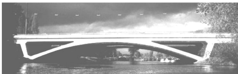
Εικ. 2.52 : Γέφυρα M25 Runnymede (1961)
