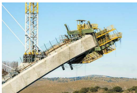
Εικ. 1.28 : Φορείο προβολοδόμησης κιβωτιοειδούς τόξου
