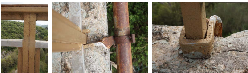
Εικ. 2.25-27 : Λεπτομέρειες κγκλιδώματος και ανάρτησης αγωγού ύδρευσης
