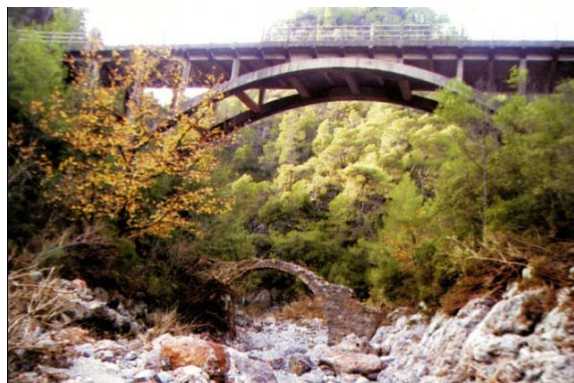
Εικ. 1.57 : Γέφυρα Κοσκάρρακα
