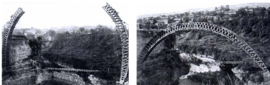
Εικ. 1.22,23 : Γέφυρα Saboya
