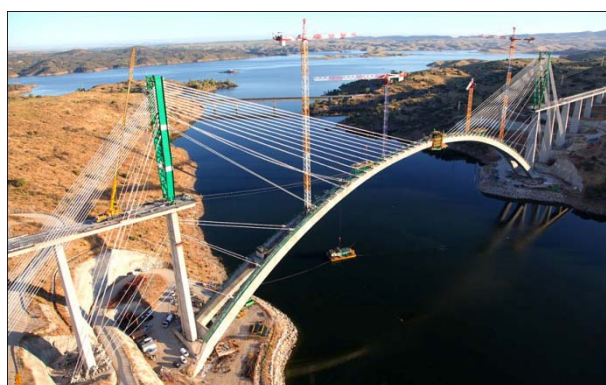
Εικ. 1.29 : Φορείο προβολοδόμησης κιβωτιοειδούς τόξου
