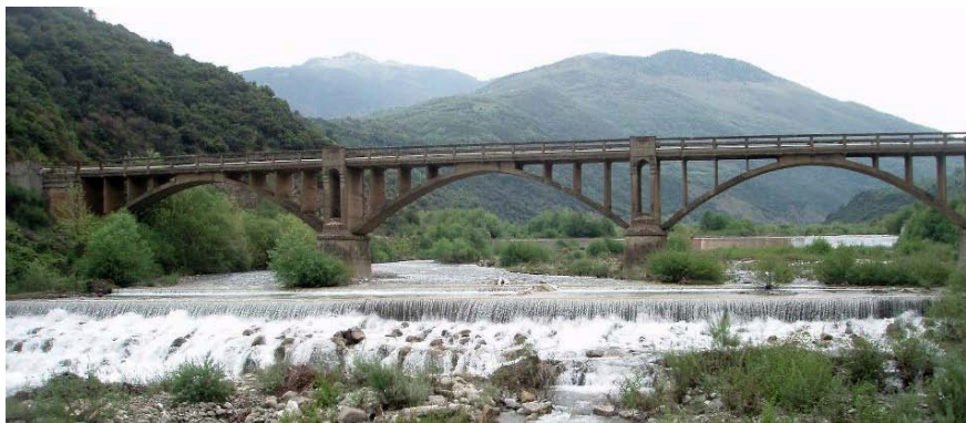
Εικ. 1.56 : Γέφυρα ποταμού Ινάχου (1930)
