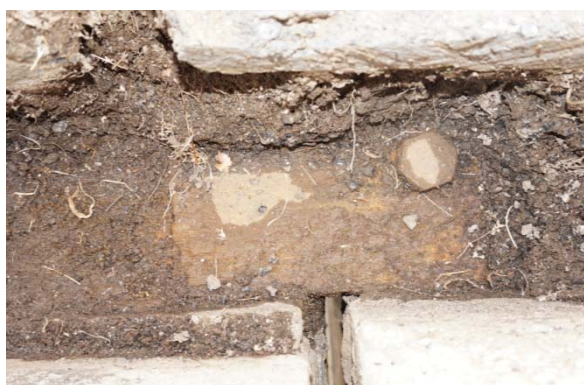
Εικ. 2.24 : Αρμοκάλυπτρο νοτίου μεσοβάθρου - τόξου
