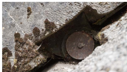
Εικ. 2.21-23 : Αρθώσεις εδράσεων και κορυφής
