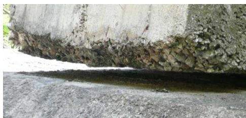
Εικ. 2.35 : Απόμιξη σκυροδέματος στην έδραση του τόξου
