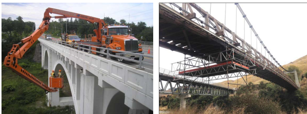
Εικ. 4.1,2 : Οχημα επιθεώρησης και αναρτημένο δάπεδο εργασίας
