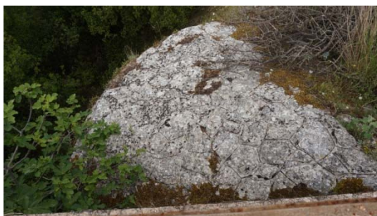
Εικ. 2.19 : Λίθινος αναλημματικός τοίχος
