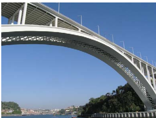
Εικ. 1.37 : Γέφυρα Arrabida (1963)
