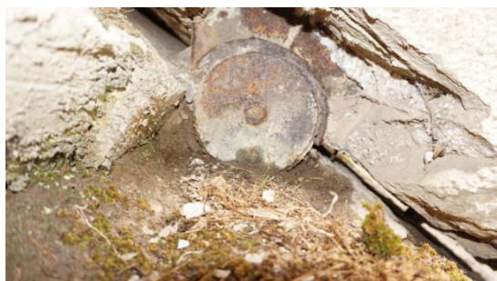
Εικ. 2.21-23 : Αρθώσεις εδράσεων και κορυφής
