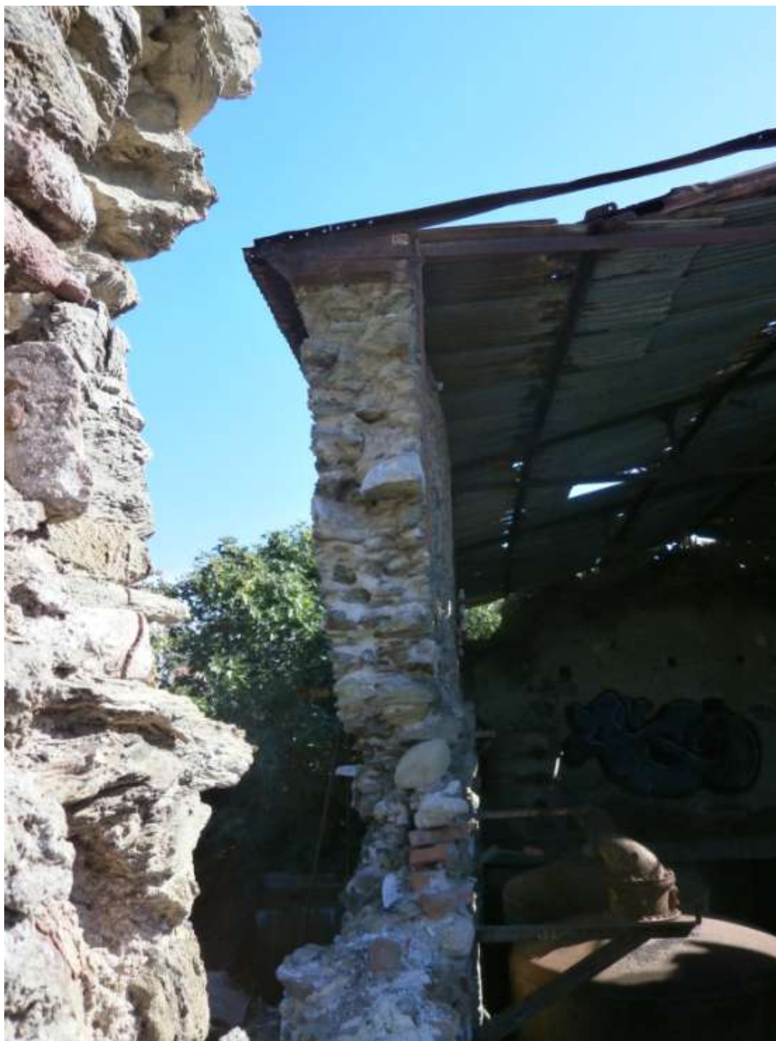
Εικόνα 13 : Καμπύλωση μέσα, απόκλιση από την κατακόρυφο, απομειωμένη διατομή του βόρειου τοίχου του εκυλιστηρίου
