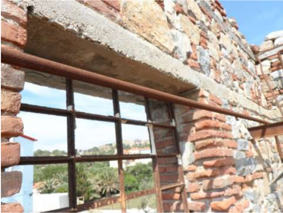
Εικόνα 24 : Σενάζ στη στάθμη των πρεκιών του ορόφου της ραφινερίας
