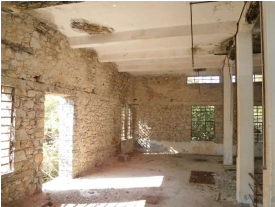
Εικόνα 27 : Βιομηχανική εγκατάσταση στον Αγ. Ισίδωρο –Αντιστοιχία περίδεσης στην στάθμη των πρεκιών του ορόφου από Ο/Σ
