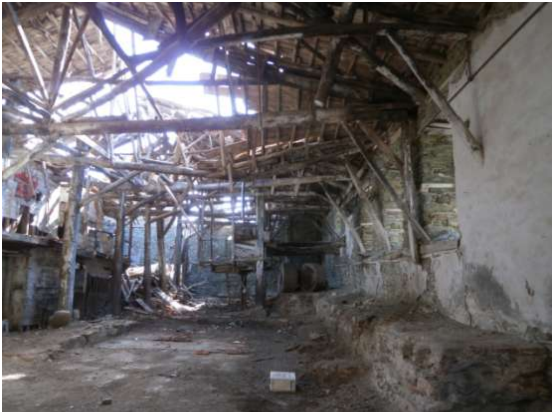
Εικόνα 34 : Ελαιοτριβείο Γεωργαντέλη στο Πλωμάρι, φορέας ξύλινης στέγης.
