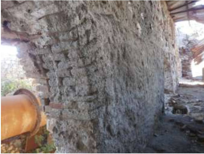
Εικόνα 14 : Επιχρίσματα στη διαμόρφωση τοξωτού ανοίγματος
