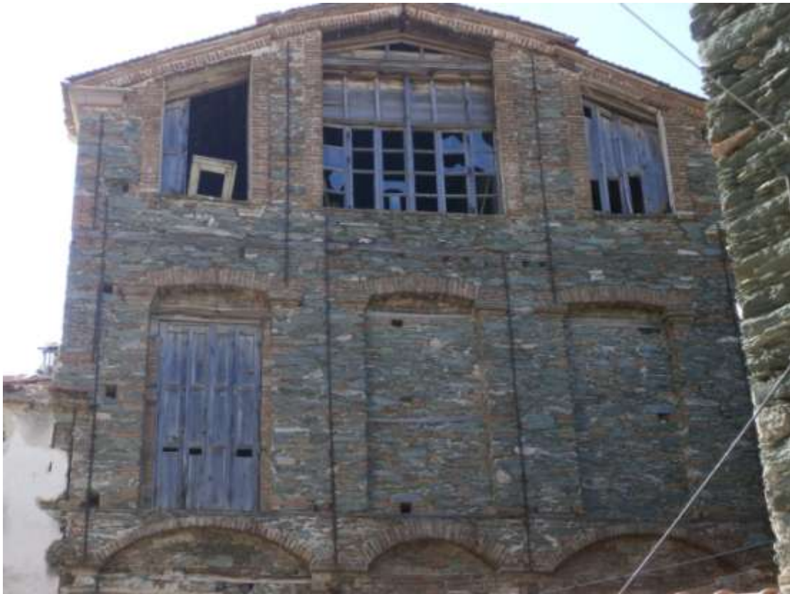
Εικόνα 29 : Σαπωνοποιείο Σίμου στο Πλωμάρι , διακρίνονται τα κλεισμένα ανοίγματα
