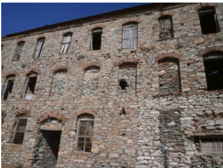
Εικόνα 32 : Σαπυνοποιείο Ξεπτερά στο Πλωμάρι – κλεισμένα ανοίγματα
