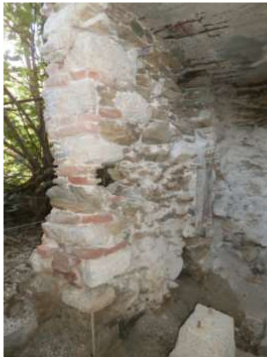
Εικόνα 7 : Απομειωμένο πάχος τοιχοποιίας με οπές κατά μήκος στη βόρεια πλευρά
