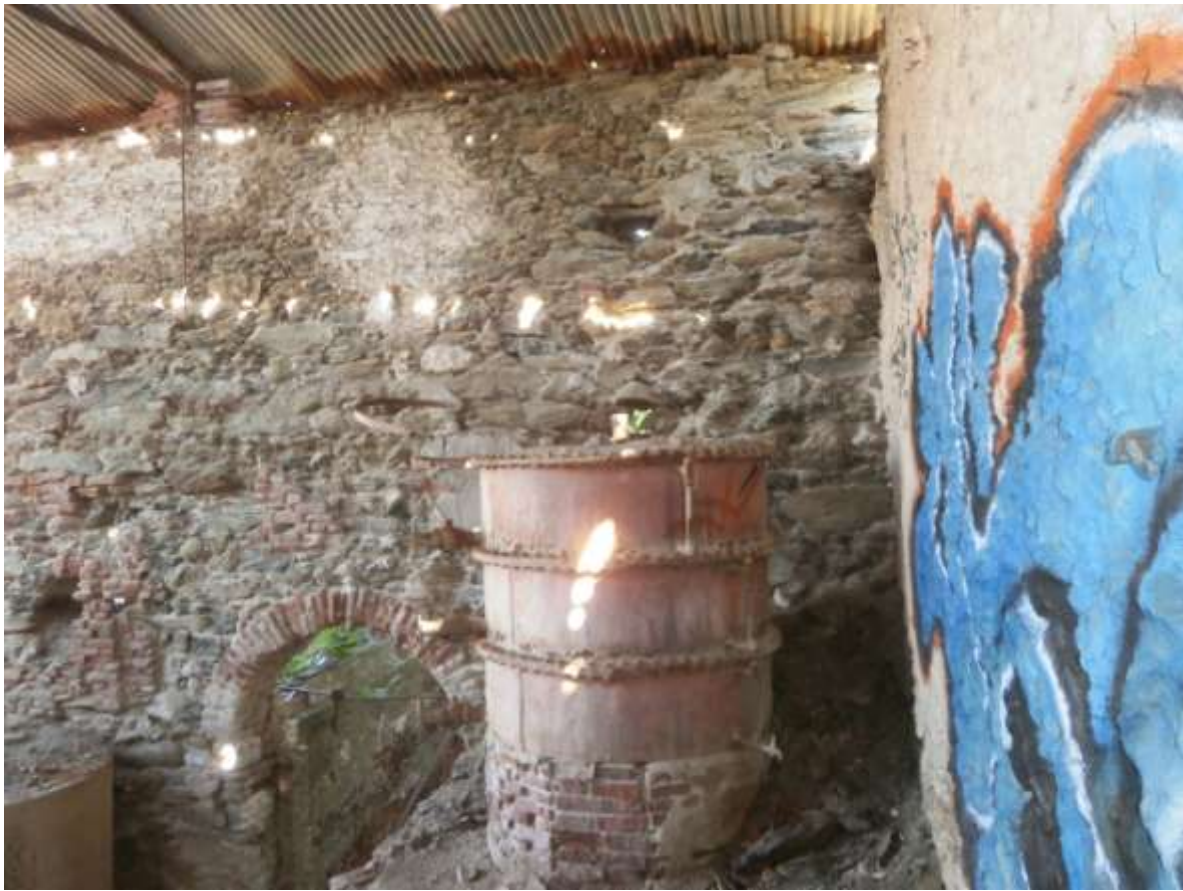
Εικόνα 8 : Βόρεια πλευρά, διακρίνονται κατά τόπους επιχρισμένες επιφάνειες
