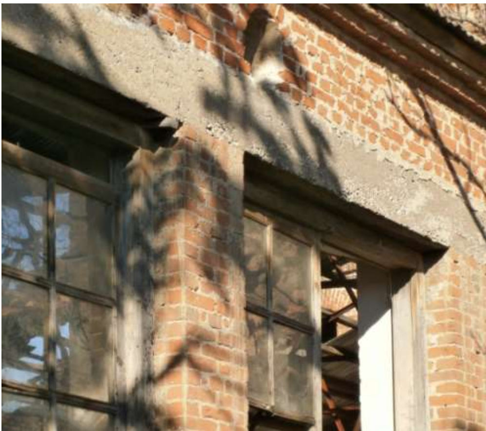
Εικόνα 31 : Βιομηχανικό συγκρότημα Καλαμάρη στη Μυτιλήνη, σενάζ στα πρέκια των παραθύρων
