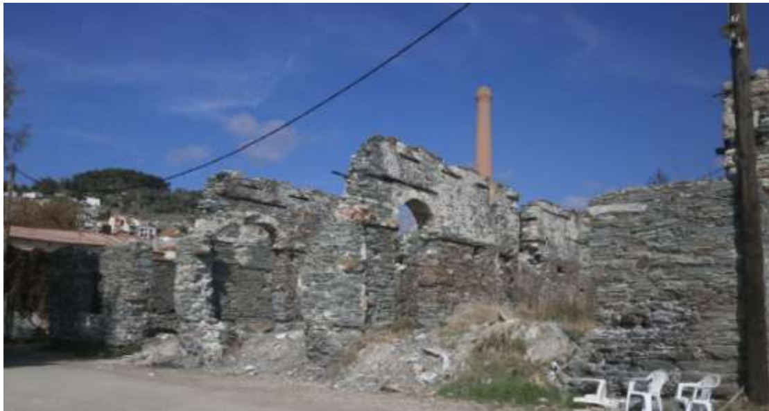
Εικόνα 28 : Σαπωνοποιείο στον Ταρσανά ( περιοχή Έσο Πάπας ) , επιμελημένα δεσίματα με ξυλοδεσιές
