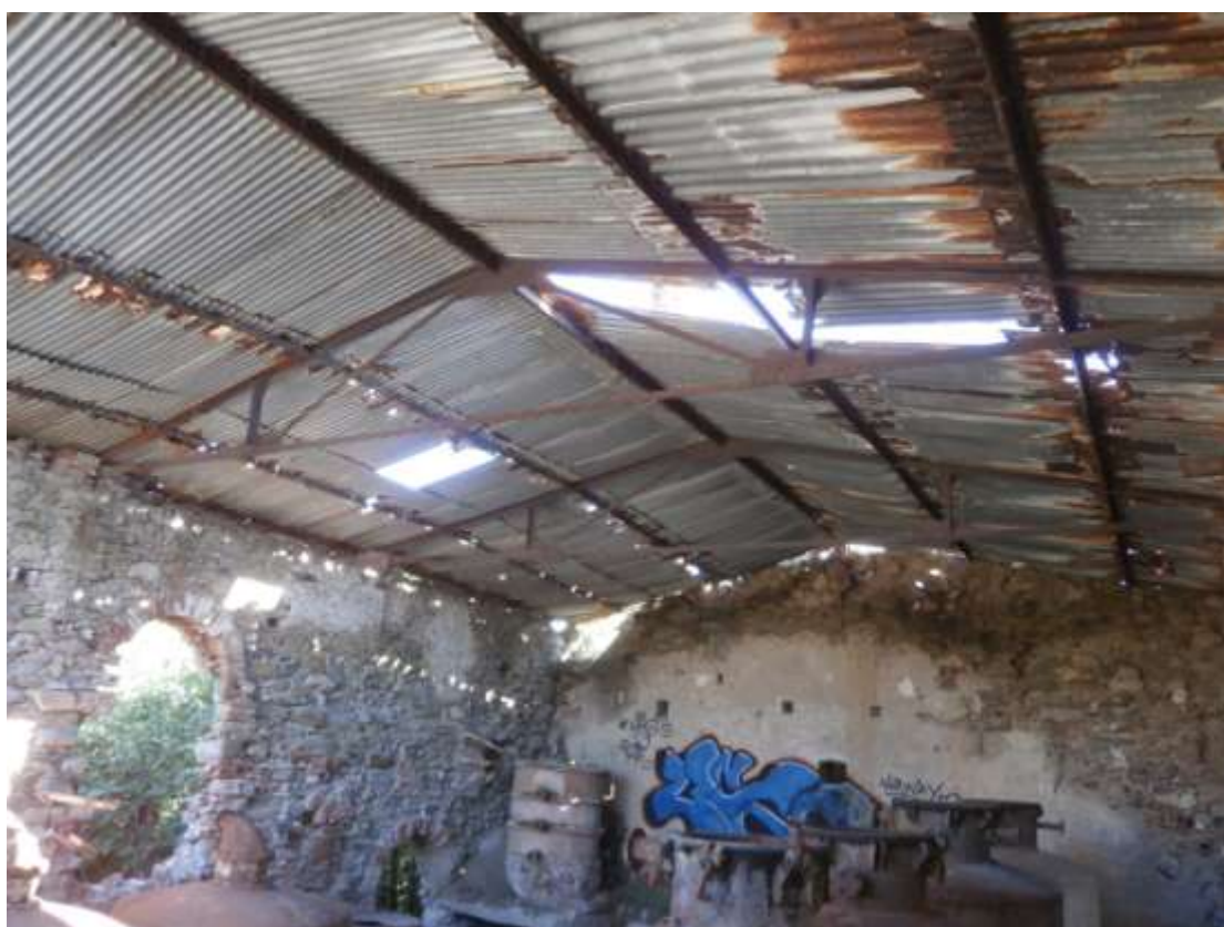
Εικόνα 18 : Μεταλλικός φορέας της στέγης
