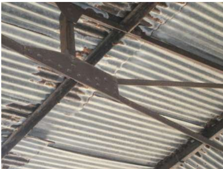
Εικόνα 17 : Σύνδεση με ηλώσεις
