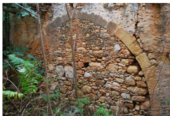
Οξυκόρυφα τόξα στις οικίες Πλεμμένου και Σκλαβάκη στο Μελιδόνι, αμφότερες χρονολογημένες στο 19ο και 18ο αι. (ΦΕΚ ΦΕΚ 308/Β/10-3-2000)
