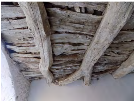
Χρήση κορμών στους Πασσαλίτες
