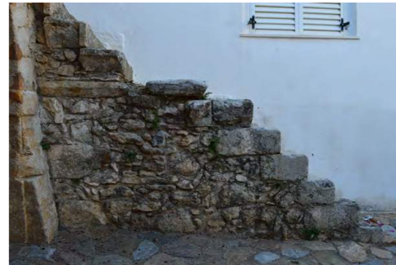
Εξωτερικές σκάλες με συμπαγή βαθμιδοφόρο στο Γαράζο και την Αρκούδαινα
