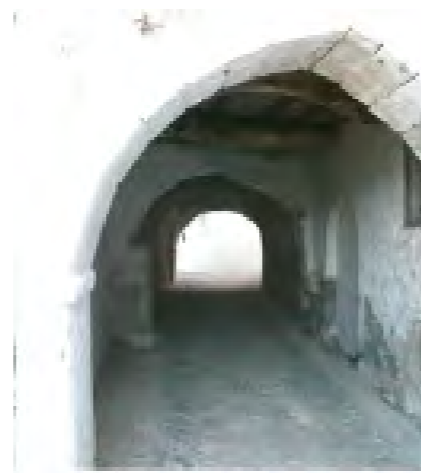
Διαβατικά στο Μούντρος και στη Μεγάλη Επισκοπή. Είναι συχνή η τοξωτή διαμόρφωση του ανοίγματος και η στέγαση με ξύλινο πάτωμα
