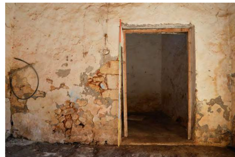
31 Μεταγενέστερο άνοιγμα στο ισόγειο
