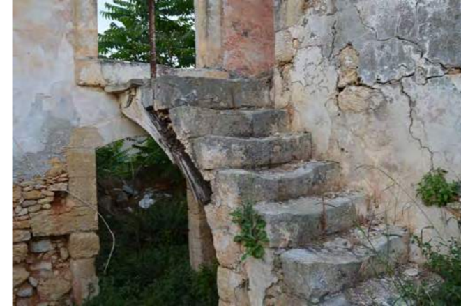
Σκάλες με αμφιέρειστο τμήμα στο Μελιδόνι και την Αρκούδαινα
