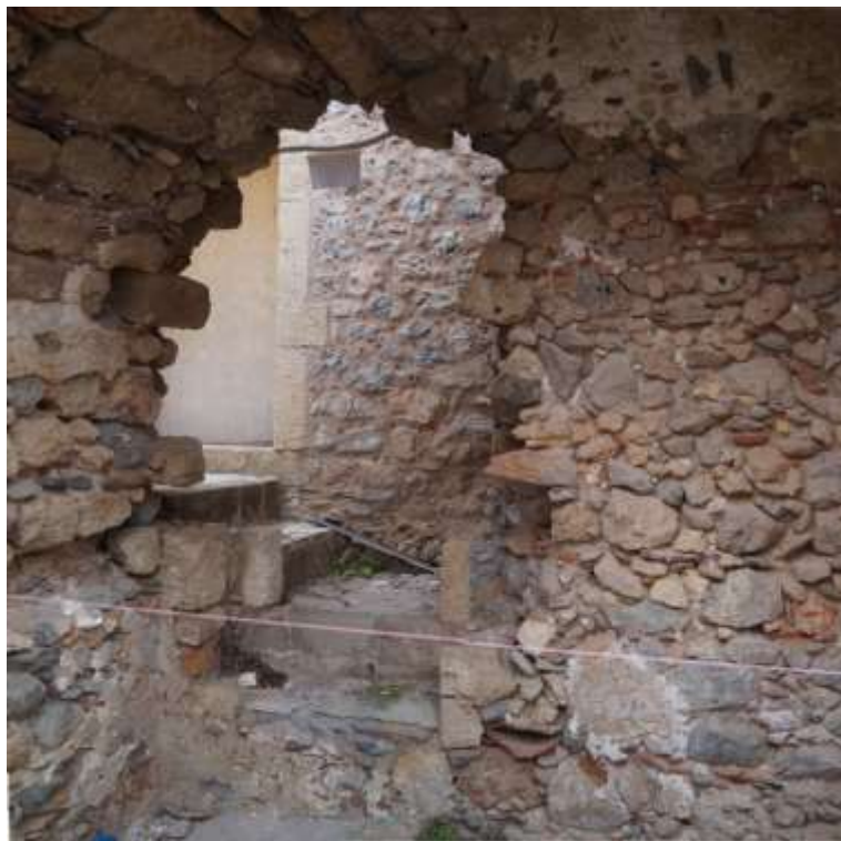
20. Το βόρειο άνοιγμα του λουτρού σήμερα. Έχει κατασκευαστεί και ένα δεύτερο σκαλοπάτι κατά το πάχος του τοίχου.
