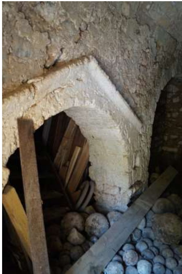
50. Ναός Σωτήρος-χώρος τροφοδοσίας (ΝΣ). Προϋπάρχοντα του λουτρού τόξα.
