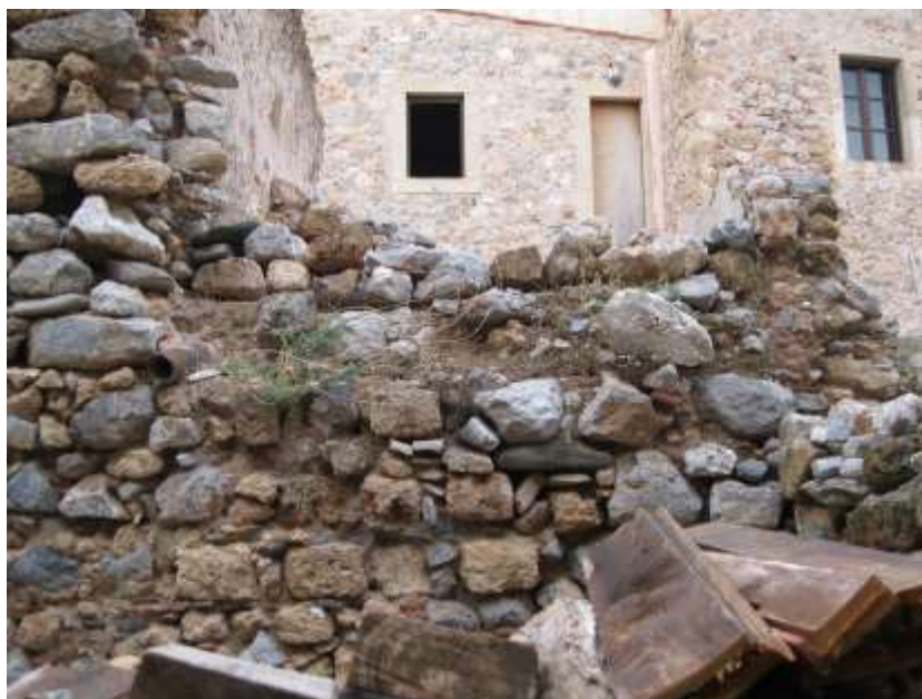
53. Ο χλιαρός χώρος και η εξωτερική προσθήκη από τα νότια. Αριστερά, διακρίνεται πήλινος αγωγός στον γκρεμισμένο τοίχο της προσθήκης χαμηλά.
