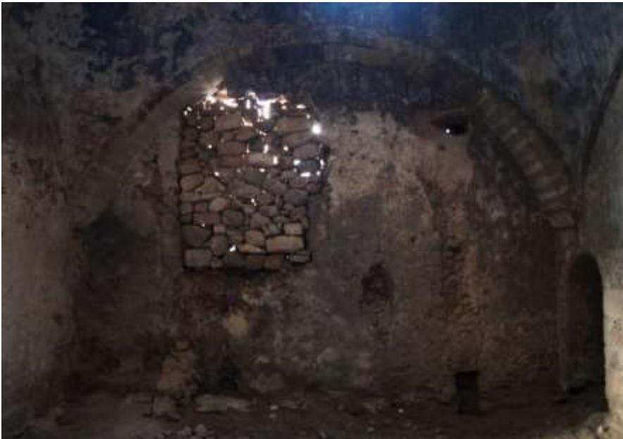
29. Νότιος τοίχος θερμής αίθουσας (Θ). Διακρίνεται μεταγενέστερη διάνοιξη, σφραγισμένη σήμερα με πρόχειρο τρόπο και τοπική καταστροφή της τοιχοποιίας στη θέση που υπήρχε αρχικά γούρνα και παροχή νερού.
