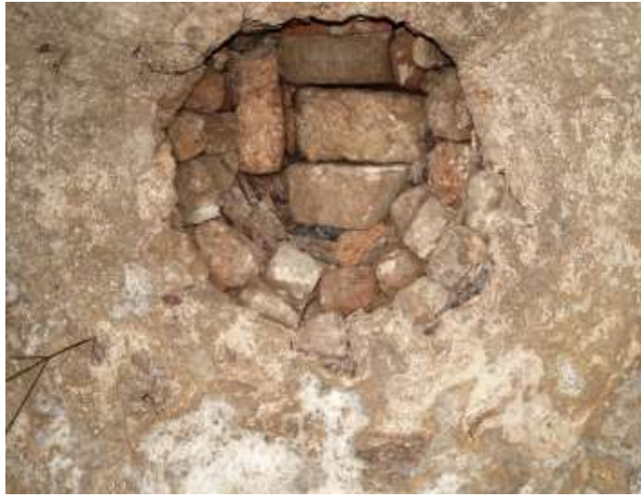
43. Κυκλική οπή στην κορυφή του βόρειου ατομικού δωματίου (H2) φραγμένη με λίθους.
