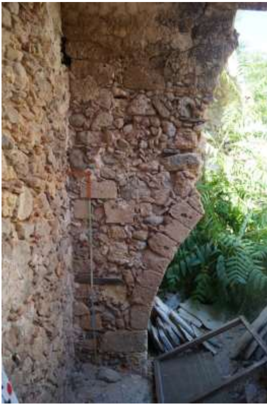
Εικ.3,4: Βόρειο και νότιο τμήμα ενδιάμεσου τόξου στήριξης της δίδυμης καμάρας του αποδυτηρίου
