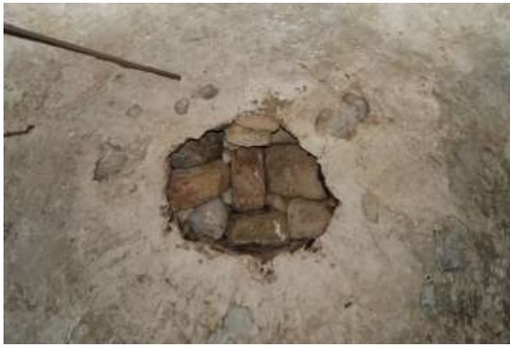
42. Κυκλική οπή στην κορυφή του νότιου ατομικού δωματίου (H1) φραγμένη με λίθους.
