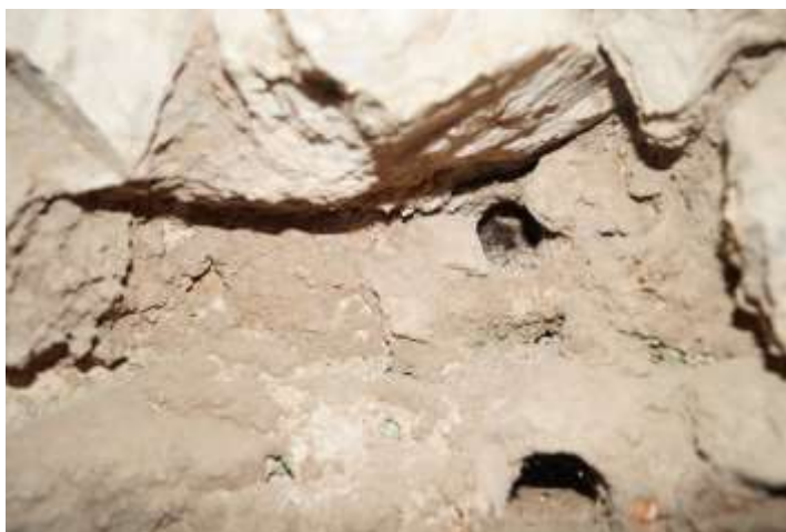
4. Λεπτομέρεια στην παραπάνω θέση. Στον πάνω αγωγό διακρίνεται υπόλειμμα μετάλλου.
