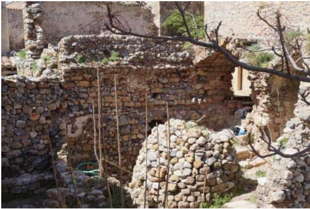
7: Στο βάθος ο δυτικός τοίχος του αποδυτηρίου
