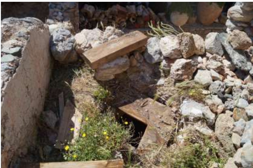
52. Ανοιχτή σήμερα κυκλική οπή στο δάπεδο του δώματος του λουτρού που επικοινωνεί με το νότιο τμήμα του χλιαρού χώρου (Χ2) που έχει διαμορφωθεί ως δεξαμενή.
