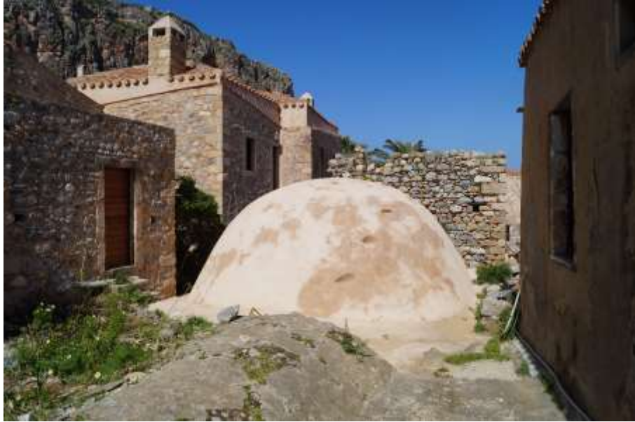
39. Εξωτερικά ο ημισφαιρικός θόλος της θερμής αίθουσας (Θ). Επικάλυψη σύγχρονη.
