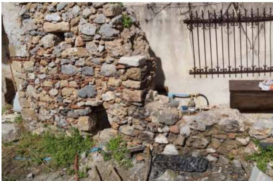
11. Ίχνη λαμπά προϋπάρχοντος παραθύρου. Ανατολικός τοίχος αποδυτηρίου (Ψ).
