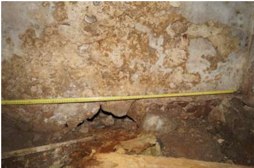
44. Νότιος τοίχος ατομικού δωματίου (H2). Χαμηλά. Επικοινωνία μέσω υποδαπέδιου ανοίγματος με την εστία του λουτρού.
