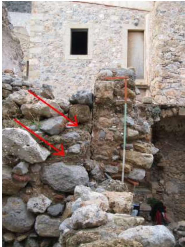
8: Δυτικός τοίχος αποδυτηρίου. Άποψη από νότια. Σημειώνονται η αρχική στάθμη του δώματος του λουτρού πριν την προσθήκη και η στάθμη του δαπέδου της προσθήκης.
