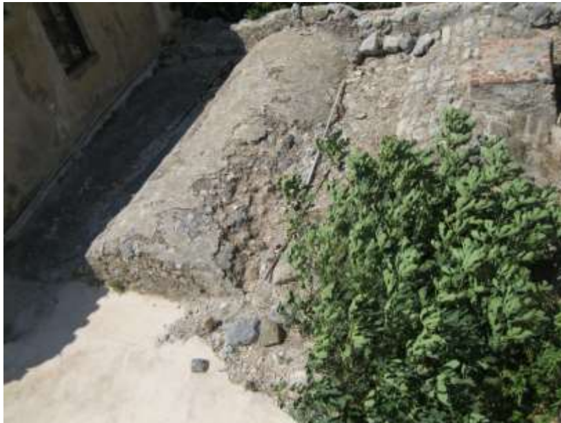
2. Ανεξέλεγκτη βλάστηση στους θόλους του μνημείου..
