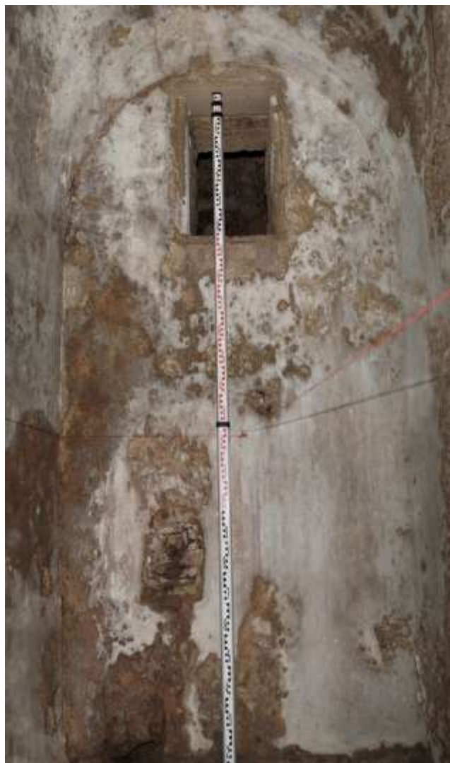
40. Νότιο ατομικό δωμάτιο (H1). Διακρίνεται χαμηλά τοπική κατάρρευση της τοιχοποιίας.
