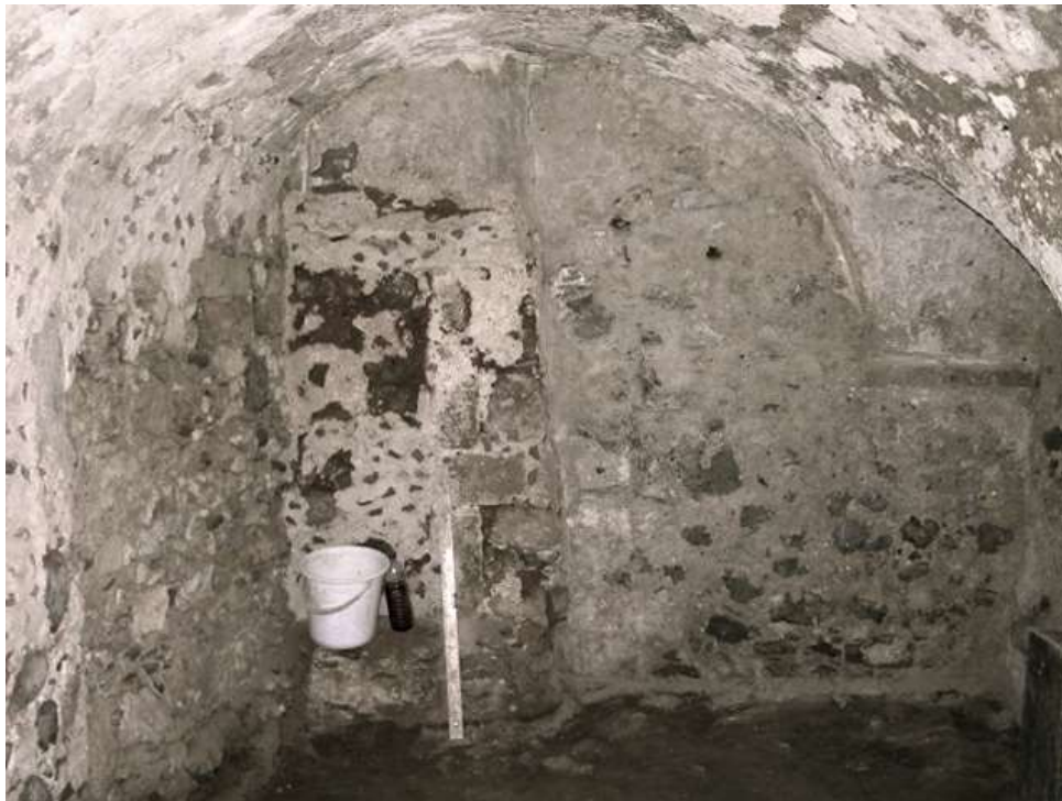
3. Κτήριο ιδιοκτησίας Λαζαρέτο Α.Ε. Ισόγειο. Πιθανή εστία στη ΝΔ γωνία που έχει σφραγιστεί με λίθους, πριν από την αποκατάστασή του. Πηγή: Γιαξόγλου Γ.
