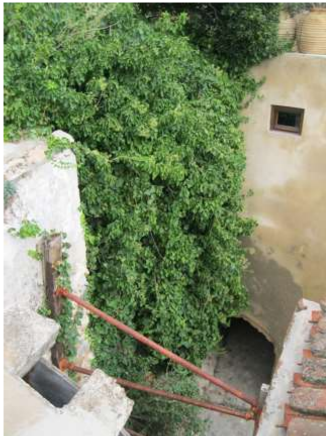
8. Θέση απότομου βραχώδους κατεβάσματος. Δεν φαίνεται να υπήρχε ποτέ πέρασμα.
