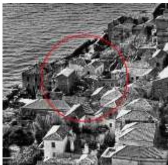
13α. Απόκομμα φωτογραφία Μονεμβασίας 1982. Σημειώνεται το λουτρό και η κατάρρευση του πρώτου χώρου. Πηγή: Σπουδαστήριο Ιστορίας Αρχιτεκτονικής Ε.Μ.Π.
