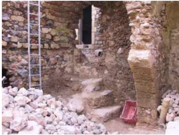
19. Το άνοιγμα στο βόρειο τοίχο του αποδυτηρίου το 2004. Δεν υφίσταται δεύτερο σκαλοπάτι. Πηγή: Γιαζόγλου Γ.
