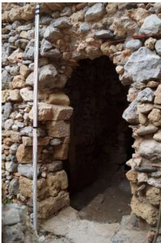
15. Ανατολικός τοίχος ψυχρού χώρου- αποδυτηρίου (Ψ). Άνοιγμα σε άσχημη κατάσταση προς τον επόμενο χώρο, το χλιαρό (X1 και X2).
