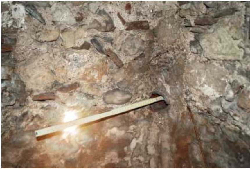
45. Παροχή νερού στις δύο δεξαμενές (Δ1 και Δ2) μέσω πήλινου αγωγού από τη βόρεια πλευρά του λουτρού.
