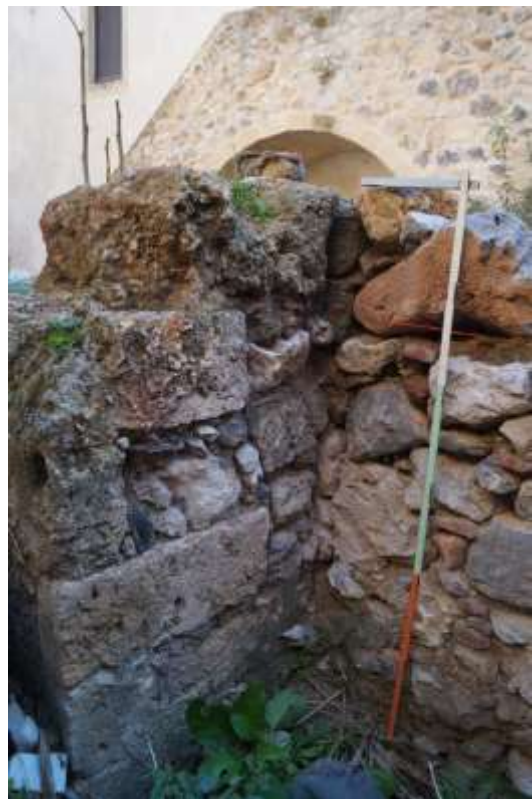
5,6: Νότιο τμήμα ενδιάμεσου τόξου στήριξης της δίδυμης καμάρας του αποδυτηρίου
