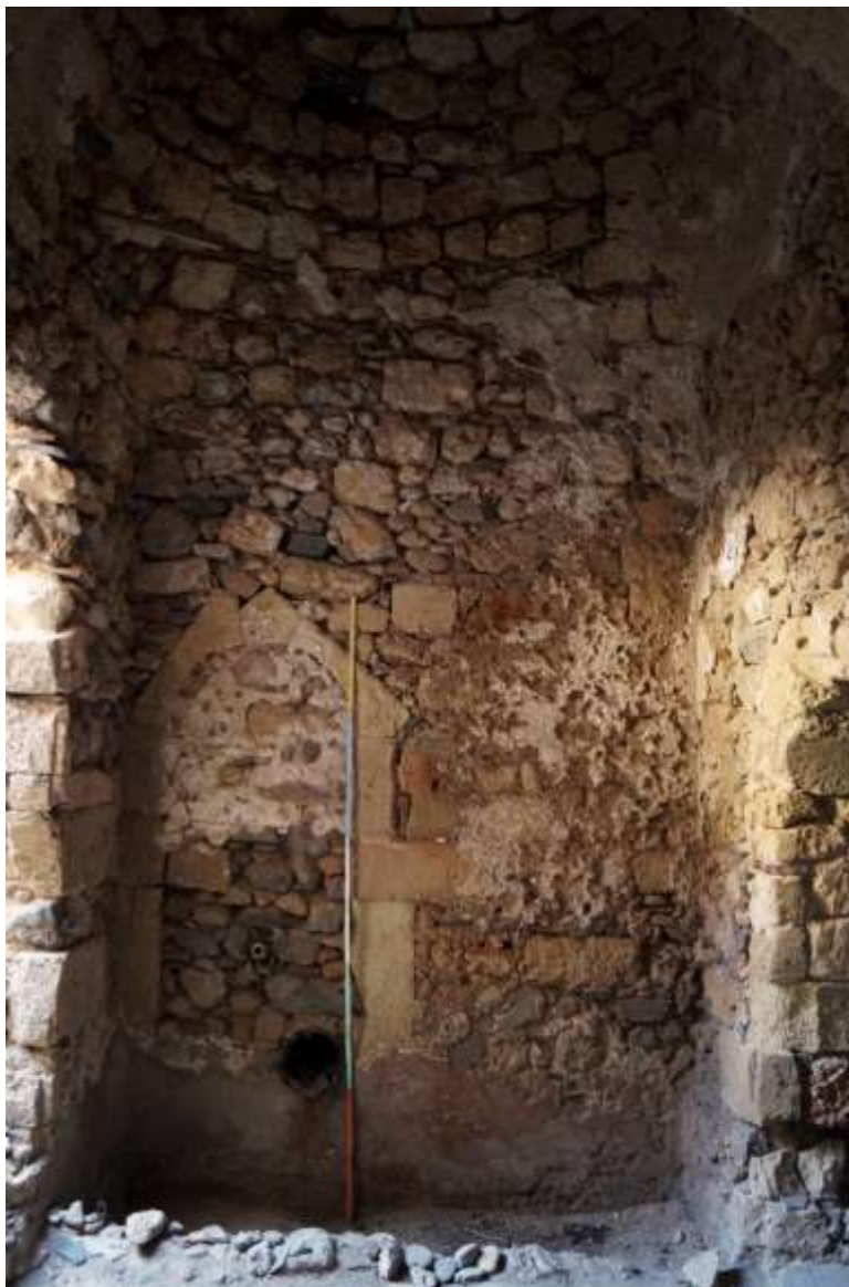
16. Τοίχος που διαχωρίζει το χλιαρό χώρο (X) σε δύο τμήματα (X1, X2). Το άνοιγμα έχει φραχθεί για δημιουργία δεξαμενής στο νότιο τμήμα X2.
