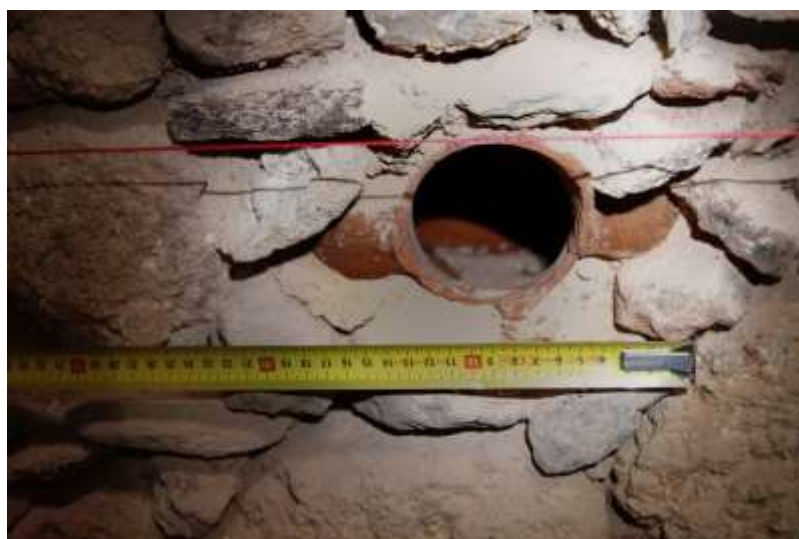
33. Λεπτομέρεια ανατολικού τοίχου θερμής αίθουσας (Θ). Πήλινο αγγείο στο πάχος του τοίχου.
