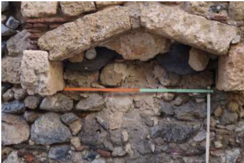
10. Προεξοχή με χρήση ως αποχωρητήριο. Εξωτερική λήψη από ανατολικά.
