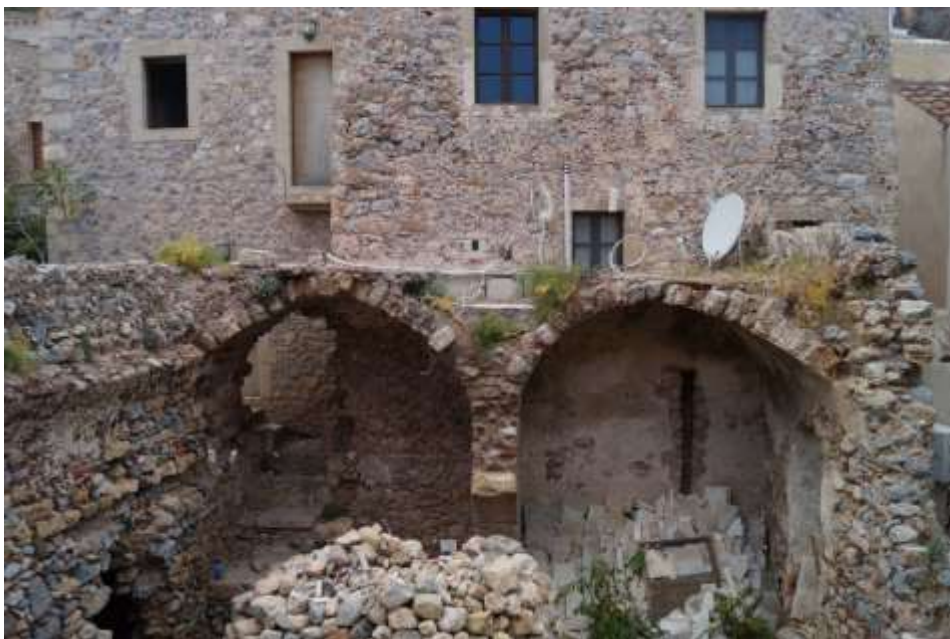
4. Ψυχρός χώρος – Αποδυτήριο (Ψ). Δίδυμη καμάρα με ενδιάμεση στήριξη σε ημικυκλικό τόξο. Αριστερά άνοιγμα σε κακή κατάσταση.
