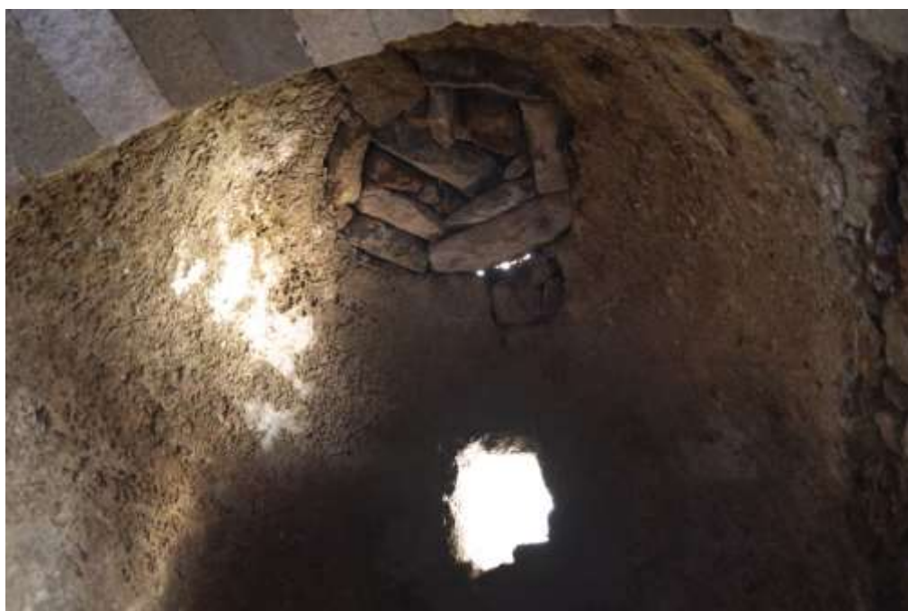
17. Φραγμένη με λίθους κυκλική οπή στο βόρειο ημισφαιρικό θόλο του χλιαρού χώρου (Στο τμήμα X1).
