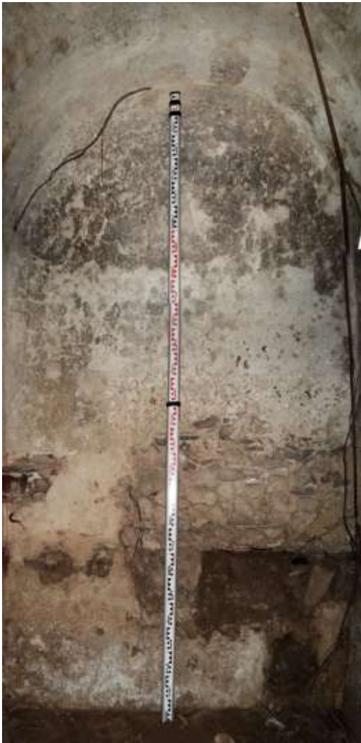
40. Νότιο ατομικό δωμάτιο (H1). Διακρίνεται χαμηλά τοπική κατάρρευση της τοιχοποιίας.
