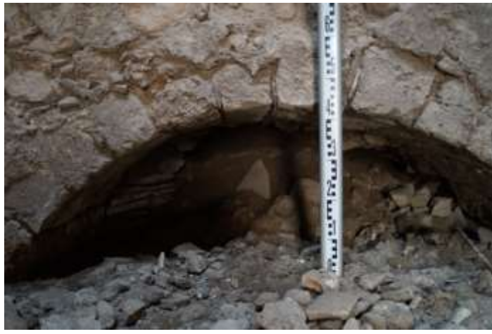
28. Λεπτομέρεια βάσης ανατολικού τοίχου θερμής αίθουσας (Θ). Τοξωτό άνοιγμα στη βάση του. Στο βάθος διακρίνεται τμήμα πλίνθινου μικρού τοίχου.
