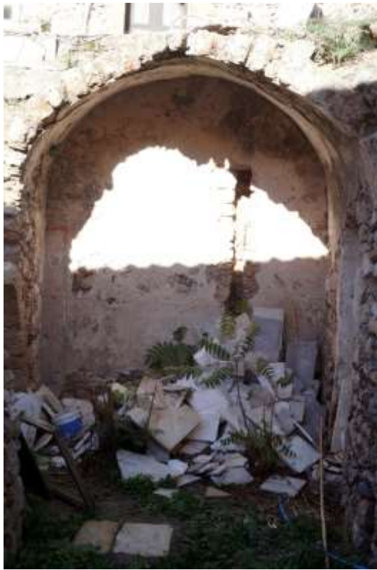
9. Ανατολικό τμήμα αποδυτηρίου (Ψ). Καλυμμένο στόμιο στέρνας στο δάπεδο.
