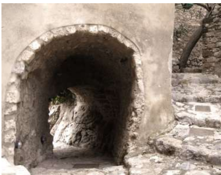
12. Σημείο διαχωρισμού των κινήσεων, Αριστερά κάτω από τη δρομική διακρίνεται το απότομο κατέβασμα που σχολιάστηκε. Στα δεξιά φαίνεται το καλντερίμι που κατεβαίνει από το Τζαμί.
