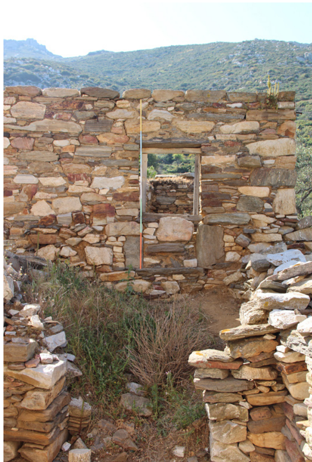
Εικ.89 Βορειοδυτική όψη ελαιοτριβείου. Δεξιά γωνία Διακρίνεται το θωράκιο στο άνοιγμα
