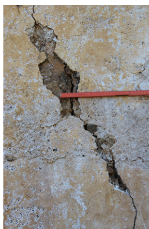
Εικ.83 & 84 Εύρος κατακόρυφης ρωγμής νοτιοδυτικής όψης πύργου
