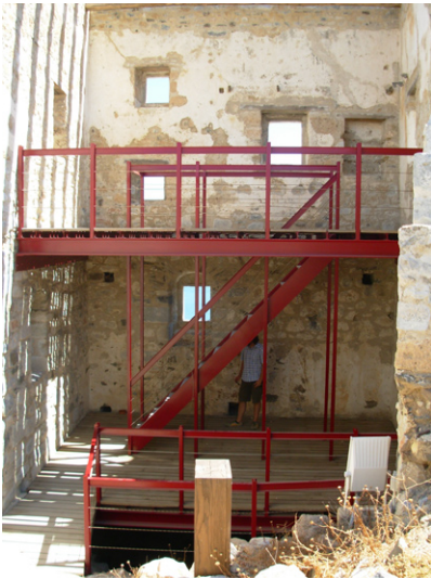
Εικ.104 & 105 Αστυπάλαια. Μεταλλικές κατασκευές ενταγμένες στα ερείπια του κάστρου της Χώρας
