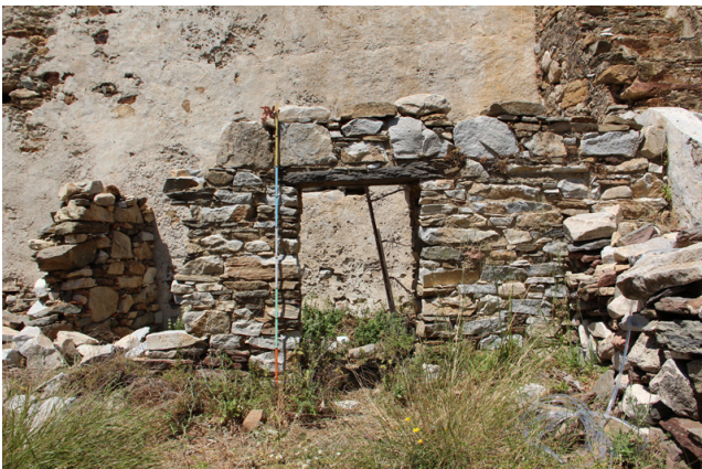
Εικ.97 Ο τοίχος της βορειοανατολικής όψης βοηθητικού κτίσματος σε επαφή με την εξωτερική σκάλα.
