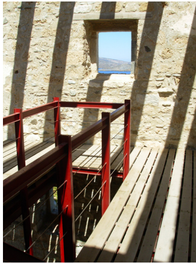
Εικ.104 & 105 Αστυπάλαια. Μεταλλικές κατασκευές ενταγμένες στα ερείπια του κάστρου της Χώρας
