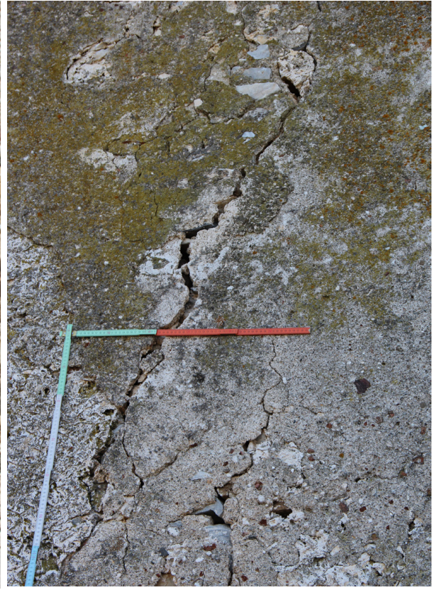
Εικ.79 Εύρος διαγώνιας ρωγμής βορειοδυτικής όψης πύργου.
