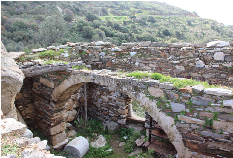
Εικ.64 Φέρων οργανισμός δώματος ελαιοτριβείου, υφιστάμενη κατάσταση
