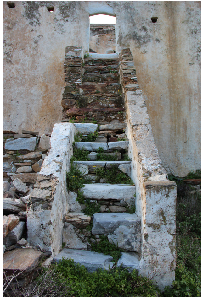
Εικ.100 Ο Πύργος της Αγίας. Η εξωτερική σκάλα του πύργου που φαίνεται να οικοδομήθηκε σε δύο φάσεις
