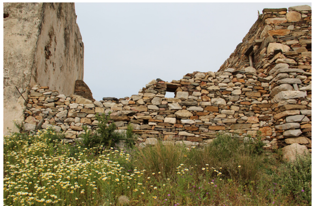
Εικ.98 Ο τοίχος της νοτιοανατολικής όψης του βοηθητικού κτίσματος μεταξύ πύργου και ελαιοτριβείου
