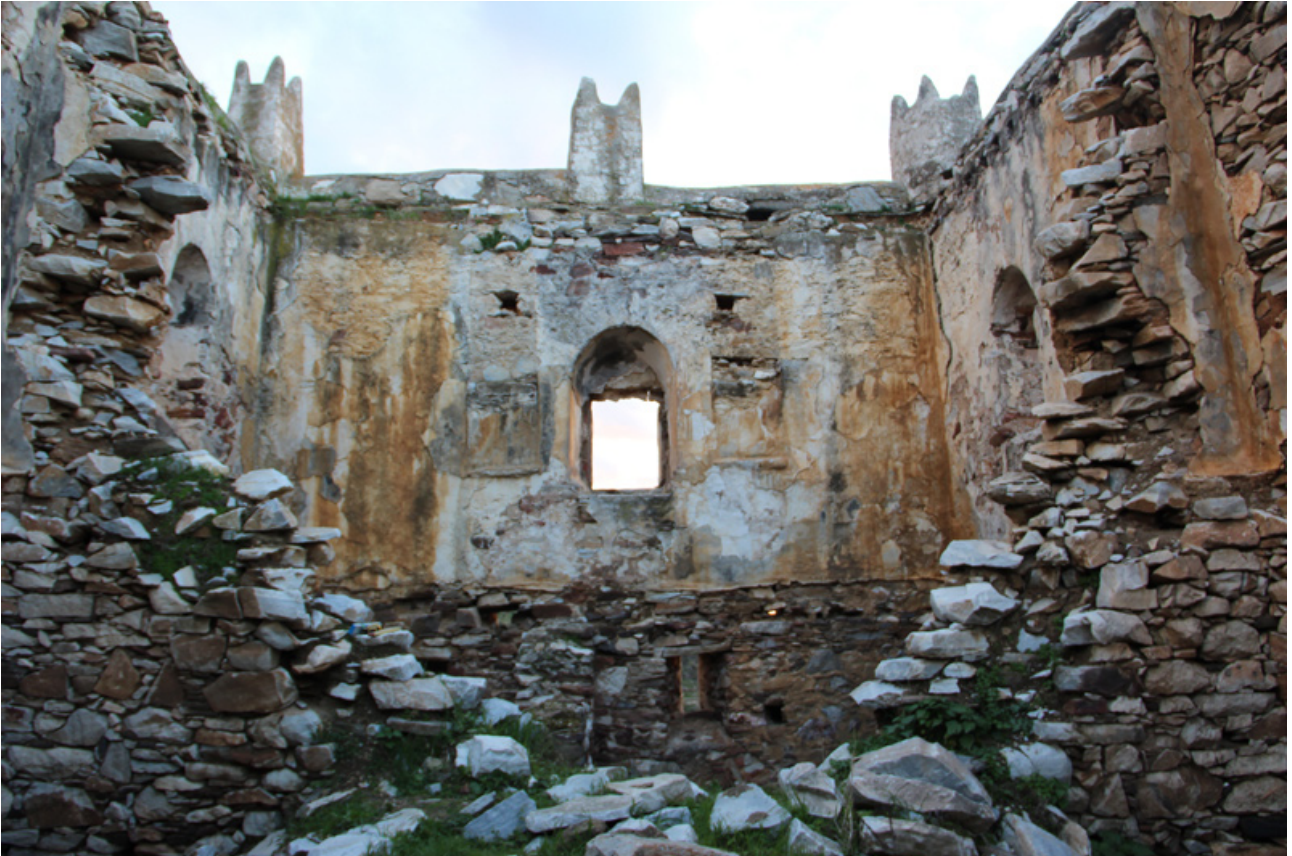
Εικ.63 Καταστροφή Φ.Ο. πατωμάτων Γ' Φάσης
