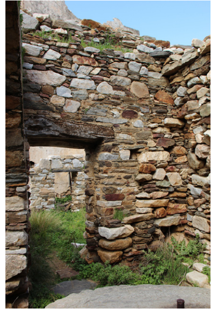
Εικ.92 Εσωτερική παρειά βορειοδυτικής τοιχοποιίας ελαιοτριβείου. Δεξιά γωνία
