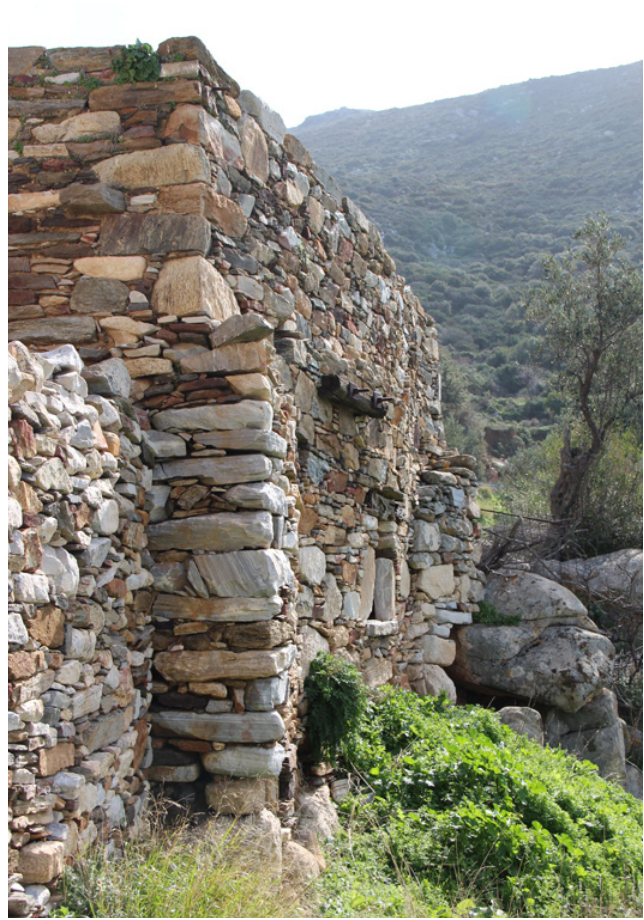
Εικ.94 Αριστερή γωνία της νοτιοδυτικής τοιχοποιίας του ελαιοτριβείου.
