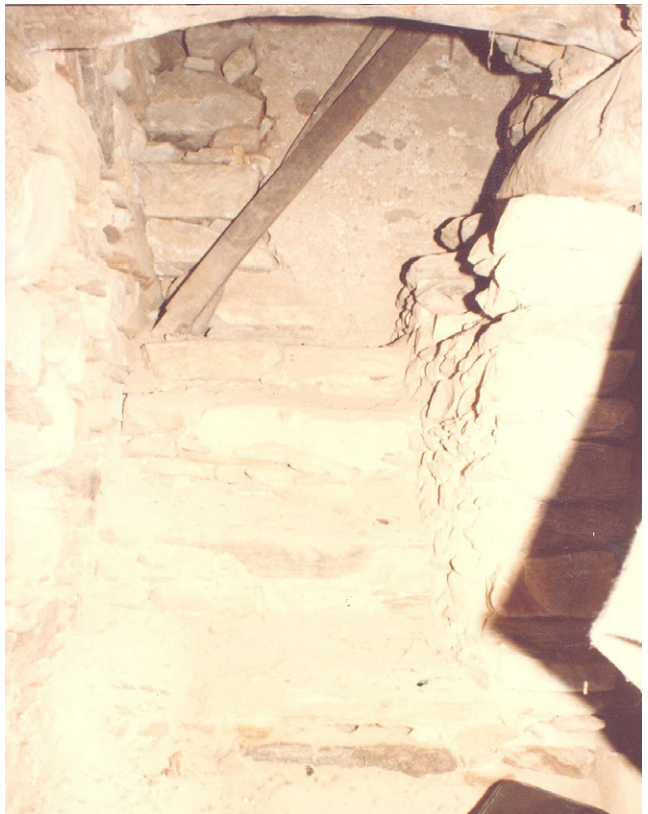
Εικ.58 Ο Πύργος της Αγιάς. Η κλίμακα που συνδέει το επίπεδο Ε1 με το Ε2 στο κομμάτι της Γ' οικοδομικής φάσης πηγή: αρχείο Στέλλας Δεμενοπούλου
