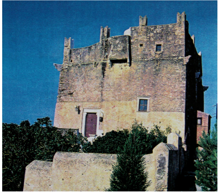
εικ.33 Ο πύργος Φραγκόπουλου. Διακρίνεται η εσοχή στην τοιχοποιία της τελευταίας στάθμης. πηγή: Δέτση Α., "Φράγκικα κτίσματα", σπουδαστική διάλεξη, 1994
