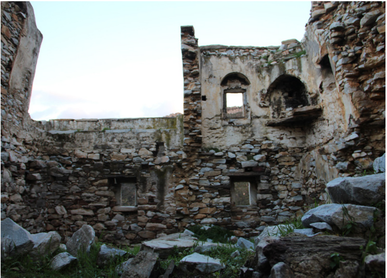
Εικ.61 Καταστροφή Φ.Ο. πατωμάτων Β' Φάσης
