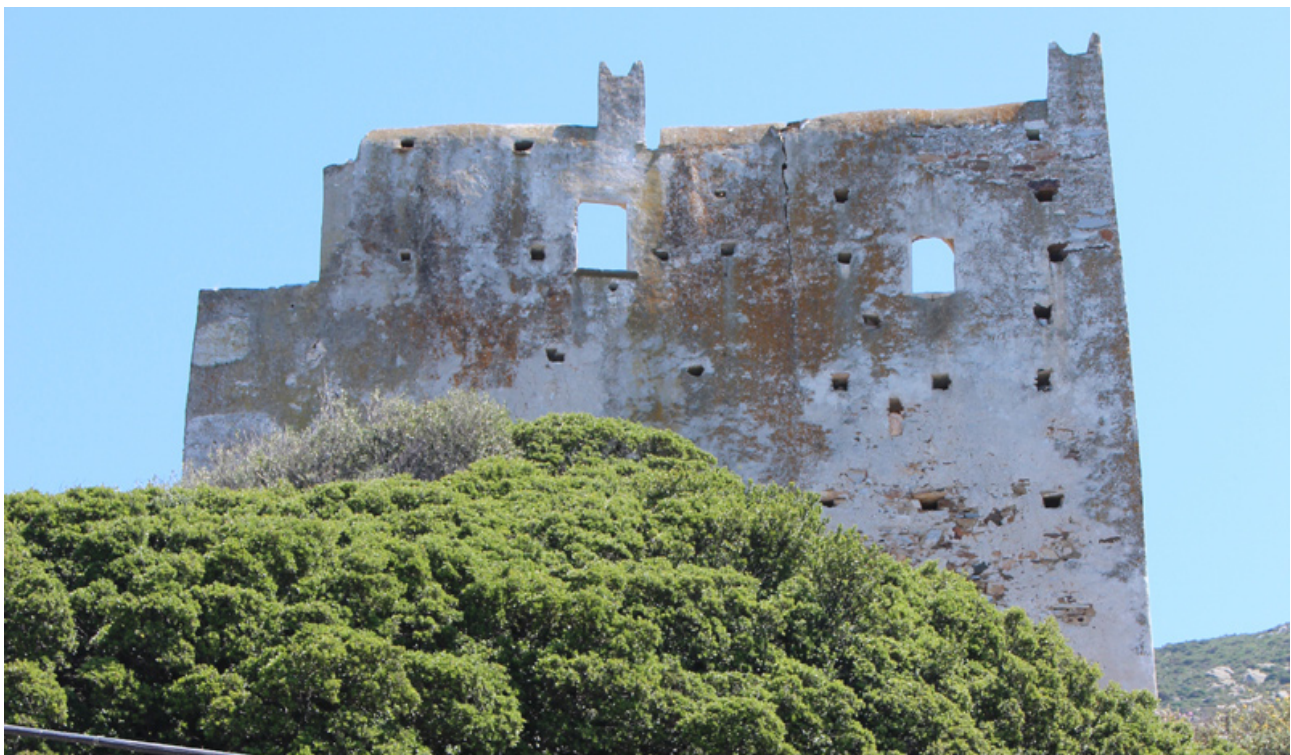
Εικ.77 Βορειοδυτική όψη πύργου.
