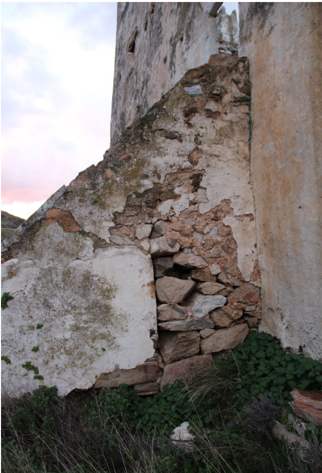
Εικ.99 Είναι εμφανής ο αρμός που αποδεικνύει με σαφήνεια τις δύο οικοδομικές φάσεις κατασκευής της σκάλας.
