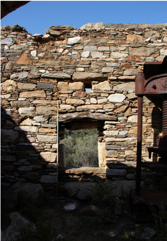
Εικ.93 Εσωτερική παρειά νοτιοδυτικής τοιχοποιίας ελαιοτριβείου.
