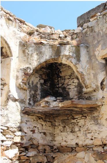
εικ.49 Πύργος Αγιάς. Εστία - τζάκι στο χώρο του μαγειρείου στο τελευταίο επίπεδο.
