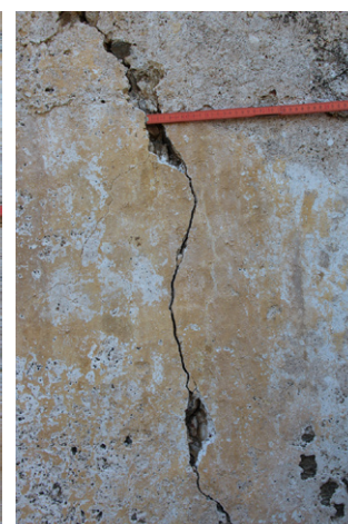
Εικ.83 & 84 Εύρος κατακόρυφης ρωγμής νοτιοδυτικής όψης πύργου
