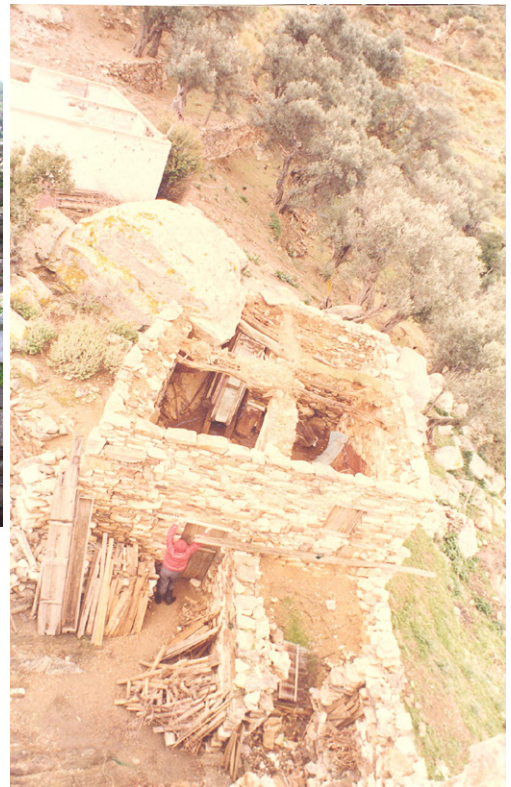
Εικ.64 Φέρων οργανισμός δώματος ελαιοτριβείου, υφιστάμενη κατάσταση
