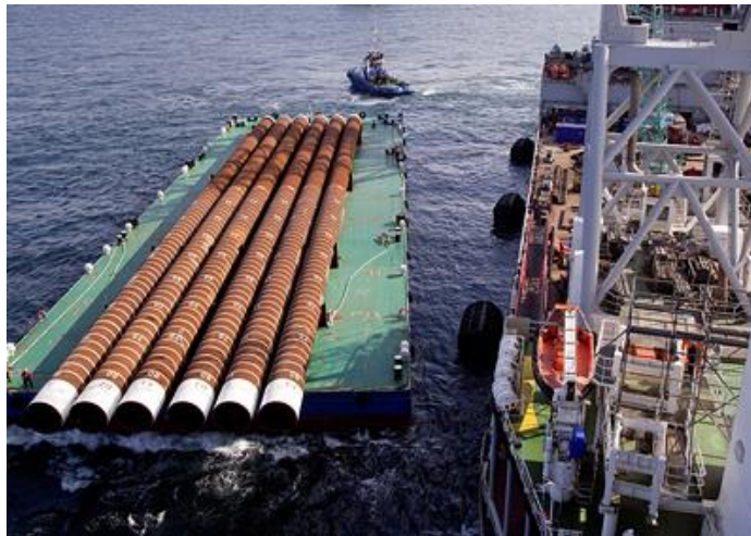
Εικόνα 5.1: Μεταφορά πασσάλων για την εγκατάστασή τους σε υπεράκτια κατασκευή.[5.1]
