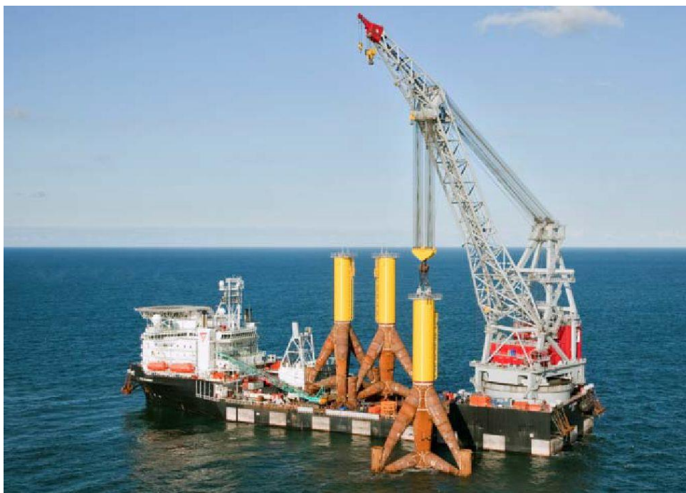
Εικόνα 5.5: Τοποθέτηση τριπόδου με πλωτά μέσα
