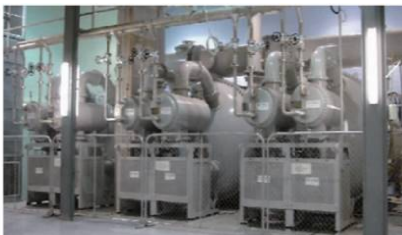
Εικόνα 1.6: Μετασχηματιστής μόνωσης αερίου 400 MVA σε υπόγειο υποσταθμό [9]
