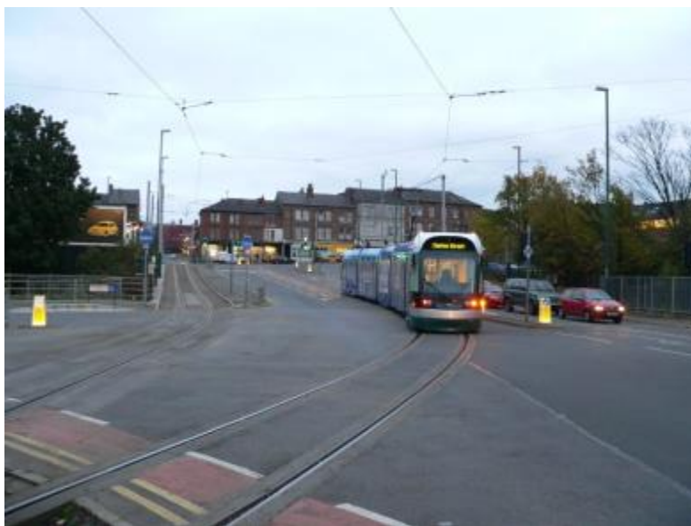
Εικόνα 1.28: Σύστημα 750 V με εναέρια καλώδια στο Ηνωμένο Βασίλειο (NottinghamExpressTransit) [30]
