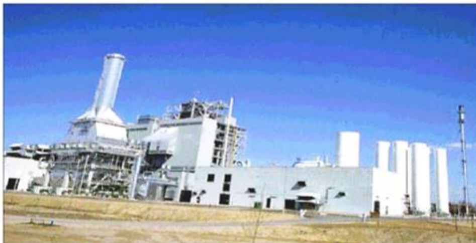
Εικόνα 1.2: Μονάδα συνδυασμένου κύκλου με αεριοποίηση 253 MW στην Ολλανδία [3]
