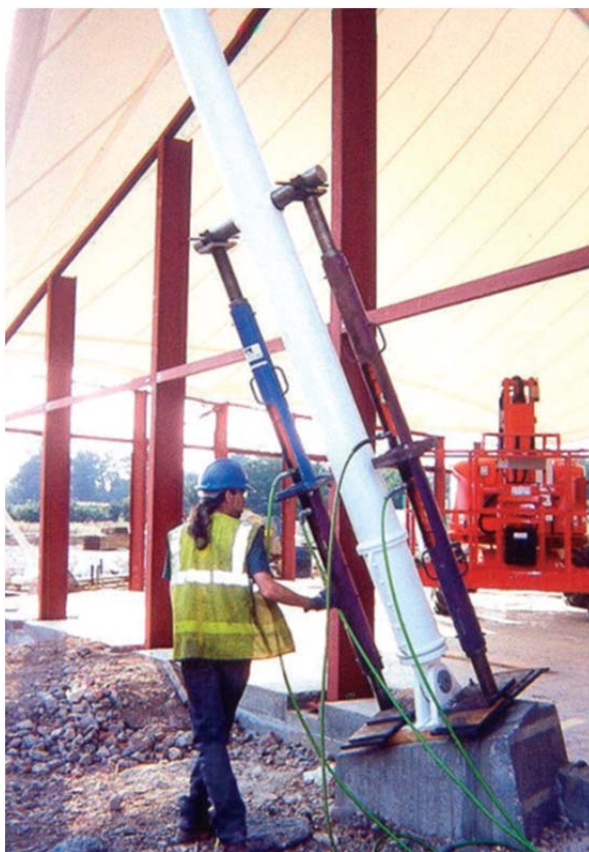
Σχ. 5.13 καθεστώς "δυναμικά-ελεγχόμενης" προέντασης της δομής της μεμβράνης με υδραυλικά έμβολα © Landrell
