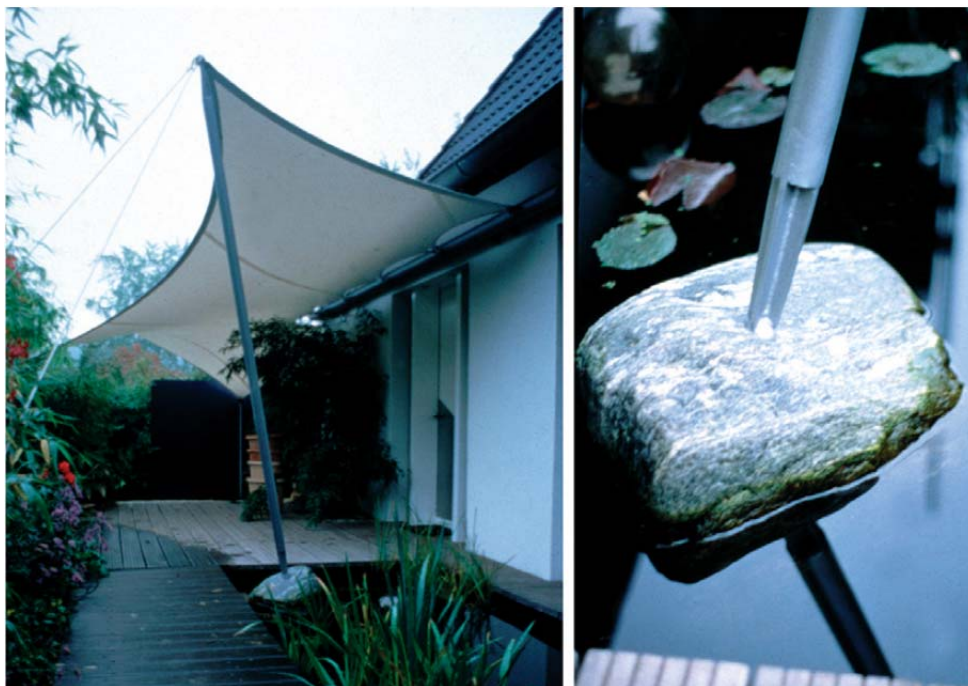
Σχ.4.21 Σχεδιασμένο θεμέλιο ενός ιστού ανάρτησης: Sail για το Δρ Molsberger, τη Γερμανία, το 1980, Rasch
