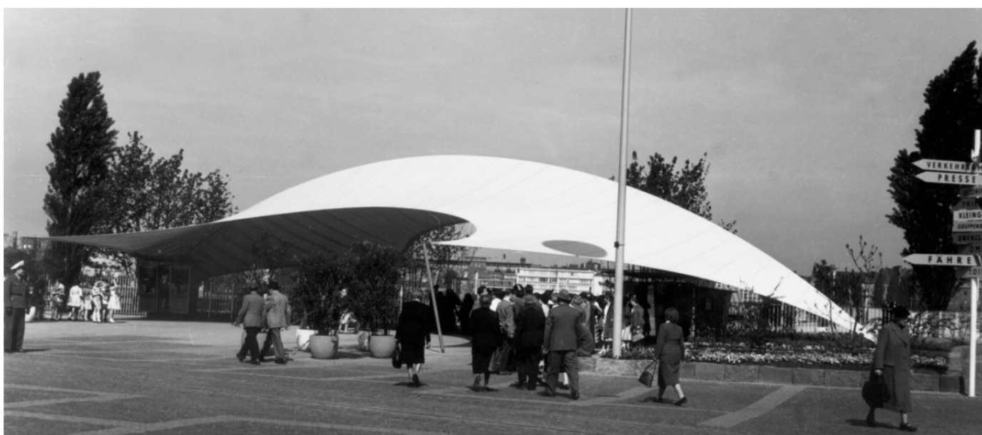
Σχ.4.14 Το τόξο χρησιμοποιείται ως δύσκαμπτη γραμμική στήριξη στη θολωτό είσοδο για την Ομοσπονδιακή Έκθεση Κήπος 1957, Frei Otto, Cologne, Germany.
