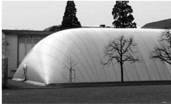
Σχ. 4.25 κυλινδρικού σχήματος αεροϋποστηριζόμενη κατασκευή
