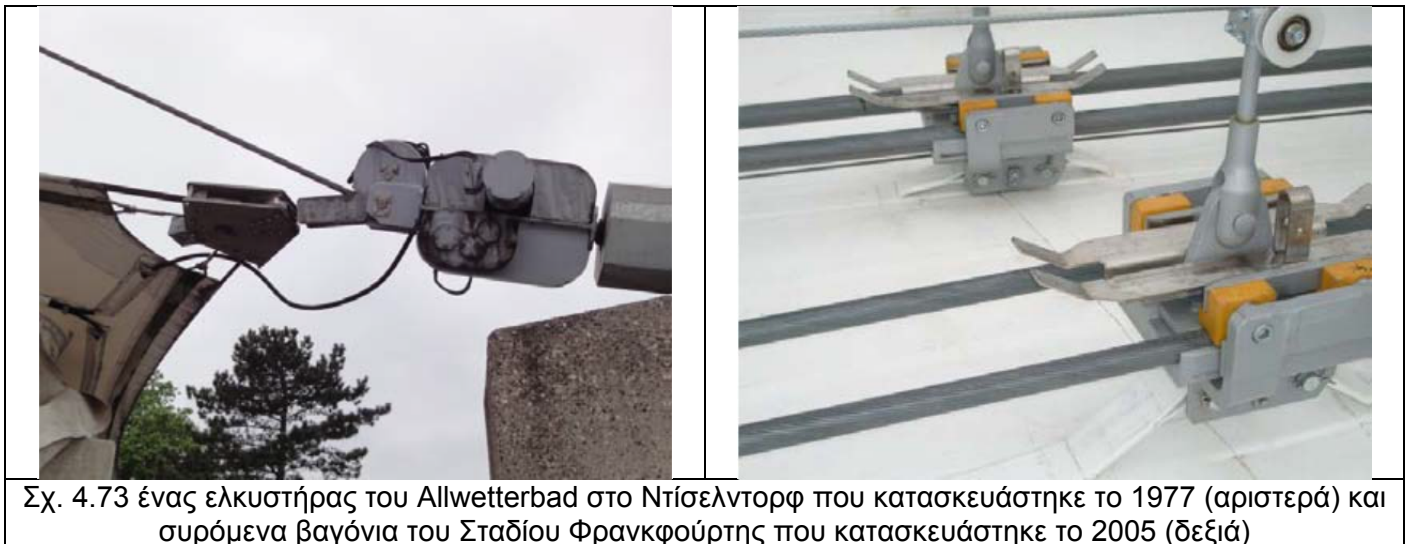
Σχ. 4.72 Δύο συστήματα οδήγησης για το σημείο στηρίξεως πτυσσόμενης οροφής μεμβράνης
