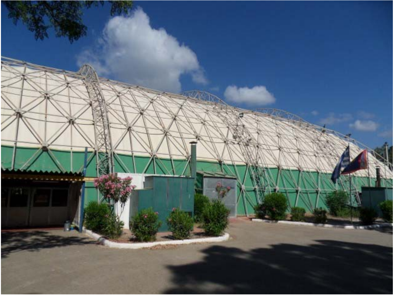
Φωτ.27 Κλειστό Γυμναστήριο Καλαμάτας.
