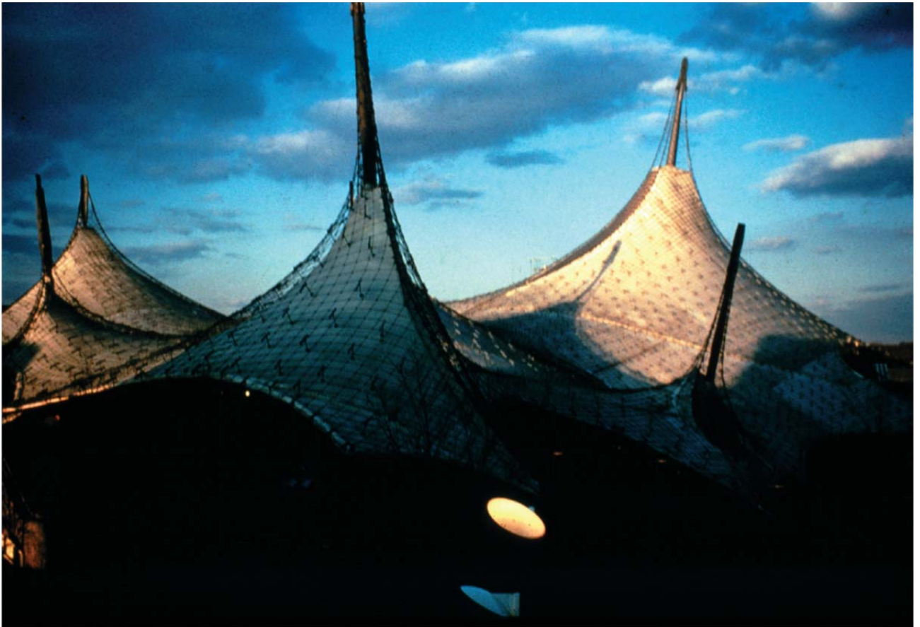
Fig.4.5 Γερμανικό περίπτερο στην Παγκόσμια Έκθεση στο Μόντρεαλ του Καναδά, το 1967, Frei Otto. Μια αντικλαστική εφελκυσόμενη κατασκευή ελεύθερης μορφής, με δίκτυο καλωδίων ως δομική στρώση και ένα επίπεδο μεμβράνης για την προστασία από την κακοκαιρία.
