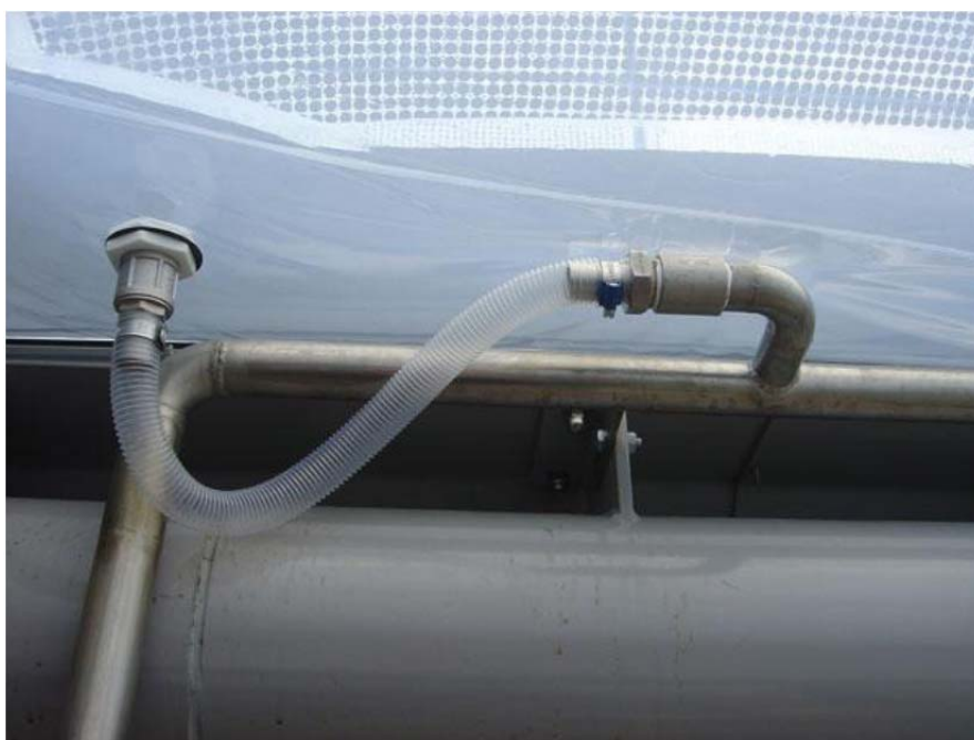
Σχ.4.41 Εύκαμπτος σωλήνας αέρα σε σύνδεση με ένα ETFE Cushion
