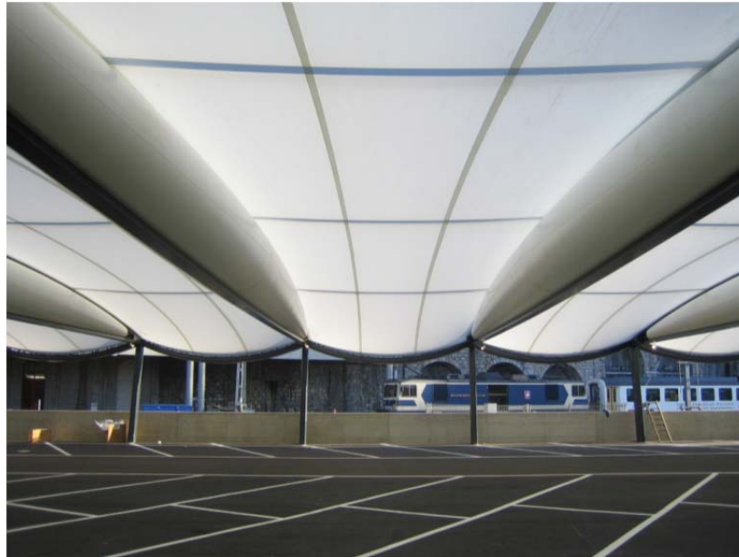
Fig.4.45 Tensairity πάρκο αυτοκινήτων στο Montreux
