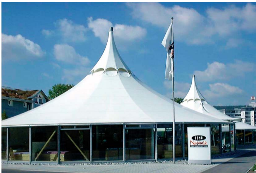
Σχ.4.13 24m Roundtent, Frei Otto with Architekturbüro Rasch + Bradatsch, Leonberg, Germany, 2000. Δομή με στρογγυλό δύσκαμπτο όριο μεμβράνης που καθορίζεται από την πρόσοψη, η οποία είναι επίσης ένα δομικό σταθεροποιητικό στοιχείο.
