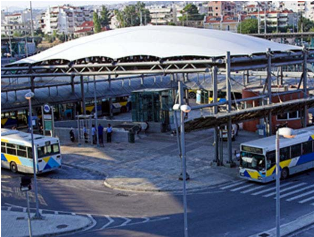
Φωτ.23 Σταθμός Δουκίσσης Πλακεντίας
