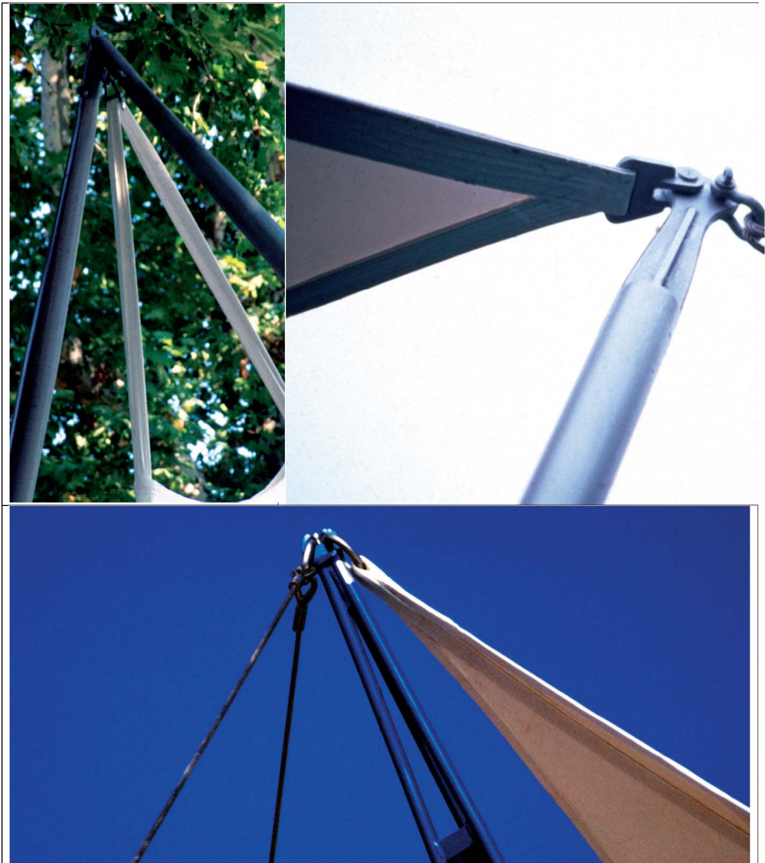
Σχ. 6.30 Διαφορετικά παραδείγματα συνδέσεων γωνιών με ιμάντες
