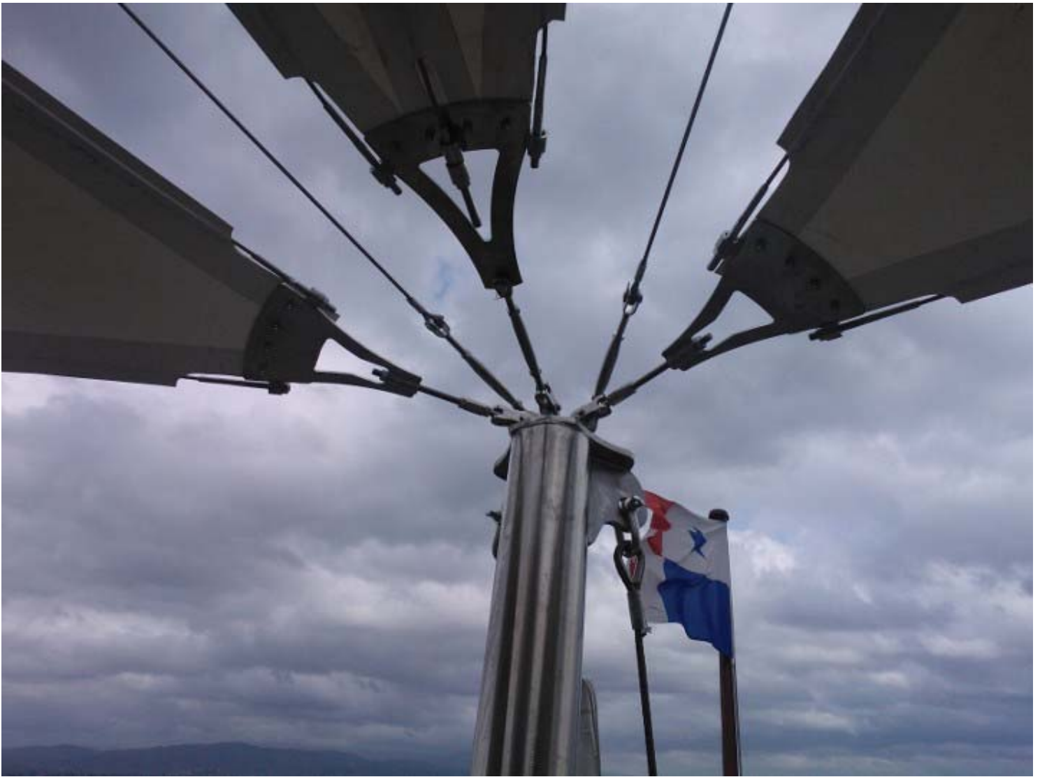
Σχ. 6.44 Τυποποιημένα εξαρτήματα επί γωνιακών πλακών Golden Iris Vessel σχεδιασμένο-υπολογισμένο από τον γράφοντα 2015.
