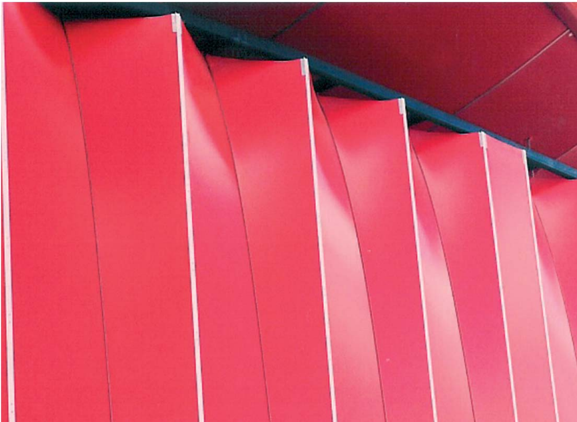
Σχ. 6.15 Καλώδια σχηματίζουν την κοιλάδα και άκαμπτα στοιχεία την κορυφογραμμή με αποτέλεσμα την κυματοειδή επιφάνεια. Στην περίπτωση αυτή το σχήμα κύματος εφαρμόζεται σε μια πρόσοψη (Αυστραλιανό περίπτερο στην EXPO 2000 στο Αννόβερο).
