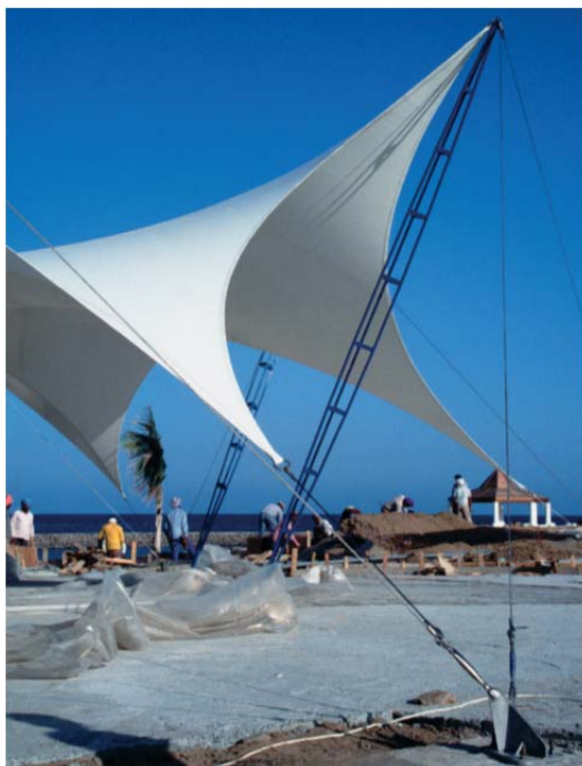
Fig.4.16 Λεπτομέρεια με δύο συντοριακούς ιστούς για το Spectators' Tent, Thowal, Saudi Arabia, 1991, SL Rasch.
