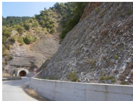
Εικόνα 24: Η ανατολική είσοδος στο Φράγμα (από Μεσοχώρα)
