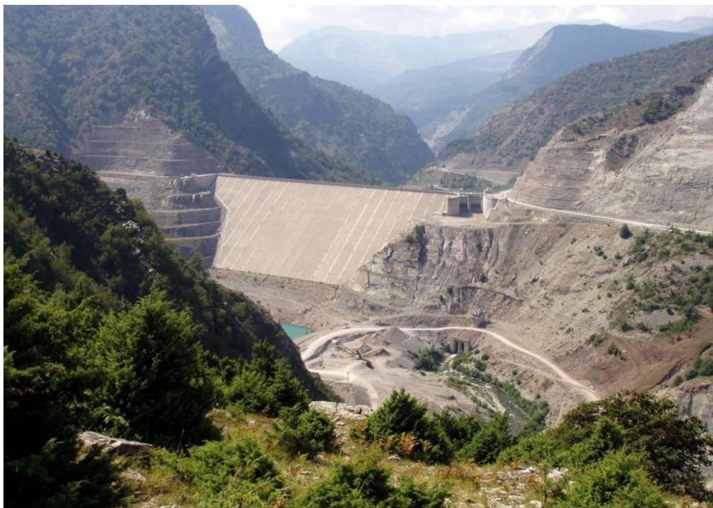
Εικόνα 20: Γενική άποψη Φράγματος Μεσοχώρας (2005)
