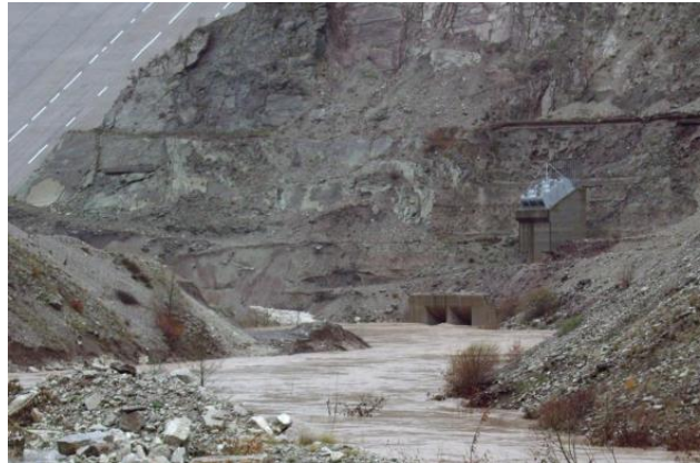
Εικόνα 21: Είσοδος σήραγγας εκτροπής
