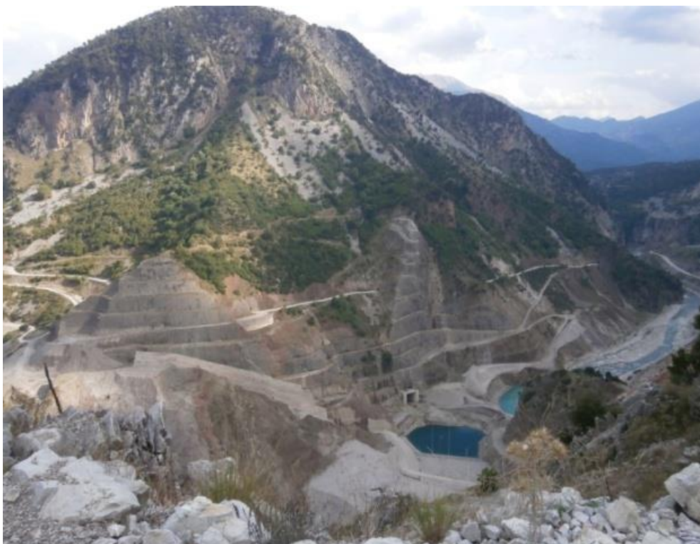
Εικόνα 32 Φράγμα Συκιάς (σήμερα) ο εκχειλιστής από Σκυρόδεμα και στο βάθος η σήραγγα εκκένωσης Ταμιευτήρα
