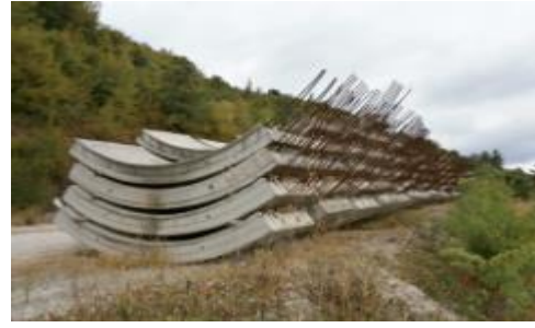
Εικόνα 38 : Προκατασκευασμένα κελύφη επένδυσης σήραγγας εκτροπής
