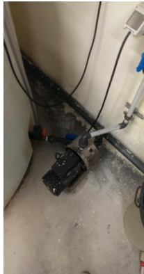
Εικόνα 5. Αντλία Πίεσης – Βαλβίδα αντεπιστροφής
