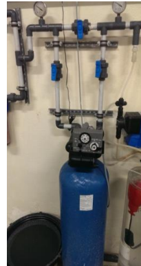
Εικόνα 7. Φίλτρο Άμμου – Μετρητές πίεσης
