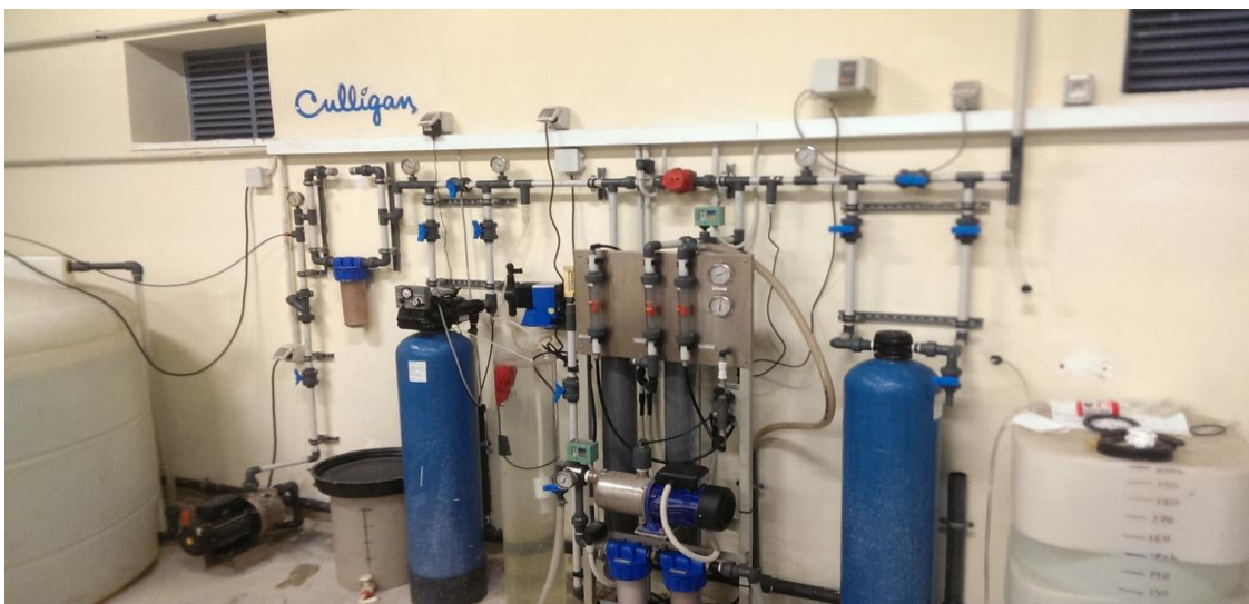
Εικόνα 1. Διάταξη Αντίστροφης Όσμωσης
