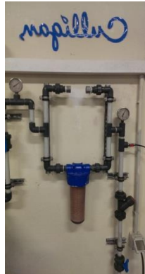
Εικόνα 6. Φίλτρο τύπου FILTR-GARD FP 3/2 3/4 (20μ) - Μετρητές πίεσης
