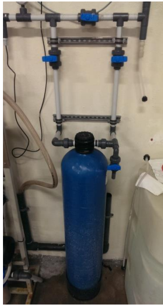
Εικόνα 11. Στήλη ιόντων - Χειροκίνητες βάνες
