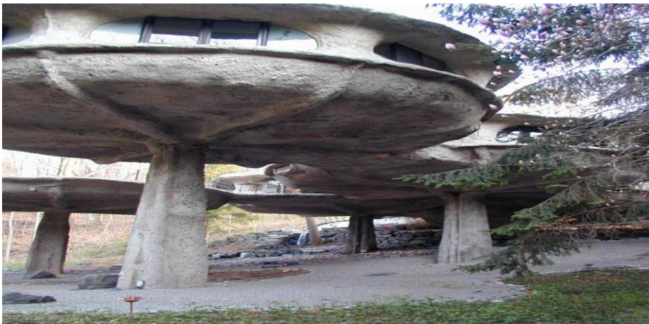
Εικόνα 1.1 "Μανιταρόσπιτα" κατασκευασμένα από οπλισμένο σκυρόδεμα, Powder Mills Park της Νέας Υόρκης [Πηγή: [3]]
