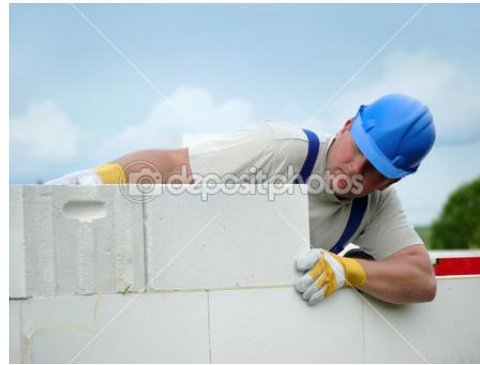
Εικόνα 1.3 (α) Αριστερά: Φρέσκο σκυρόδεμα χυτεύεται σε καλούπια [Πηγή: [7]] (β) Κυψελωτό σκληρυμένο σε κλίβανο σκυρόδεμα μπλοκ [Πηγή: [8]]
