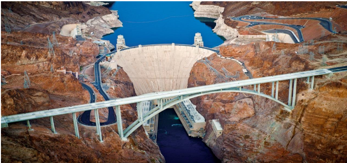
Εικόνα 1.2 Υδροηλεκτρικό Φράγμα Χούβερ, Δυτικές Η.Π.Α, Πολιτεία Νεβάδας. 2.3 εκατομμύρια m^3 σκυροδέματος εγχύθηκαν κατά τη διάρκεια της κατασκευής του. [Πηγή: [5]]
