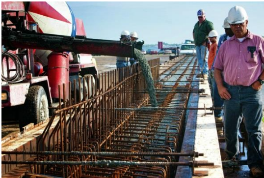
Εικόνα 1.3 (α) Αριστερά: Φρέσκο σκυρόδεμα χυτεύεται σε καλούπια [Πηγή: [7]] (β) Κυψελωτό σκληρυμένο σε κλίβανο σκυρόδεμα μπλοκ [Πηγή: [8]]
