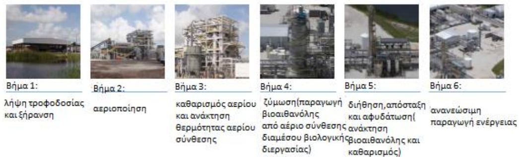
Εικόνα 29: Βήματα της διεργασίας INEOSBIO για την παραγωγή βιοαιθανόλης
