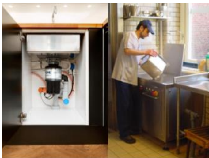
Εικόνα 14: Σκουπιδοφάγος κάτω από το νεροχύτη οικίας (αριστερά) και πάνω από το νεροχύτη (δεξιά) [19]
