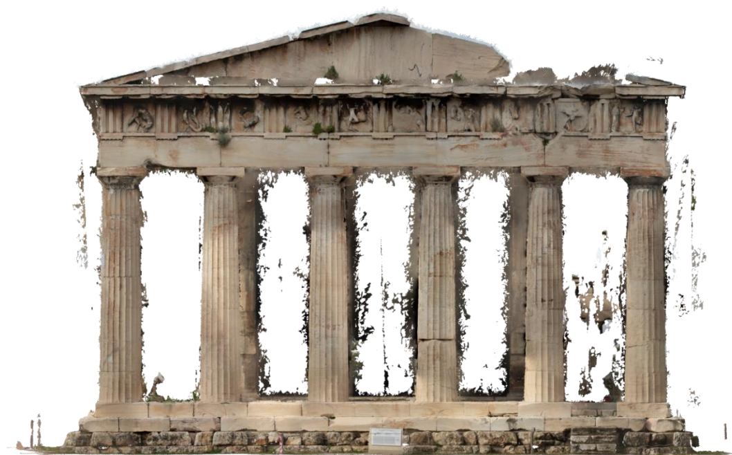
Εικόνα 4.7 Ορθοφωτογραφία ανατολικής όψης του ναού του Ηφαίστου.
