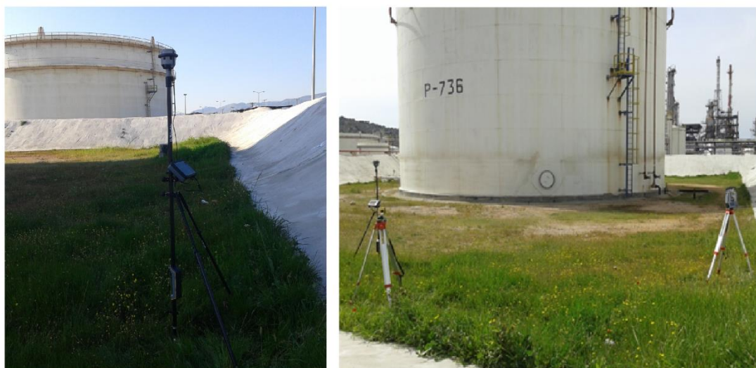
Εικόνα 4.14 Εργασίες πεδίου για την αποτύπωση της δεξαμενής P-8736.
