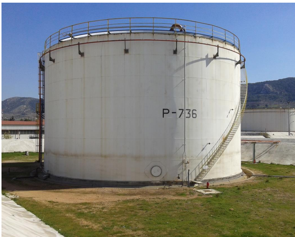
Εικόνα 4.10 Δεξαμενή P-8736 στις βιομηχανικές εγκαταστάσεις των διυλιστηρίων Ασπροπύργου.
