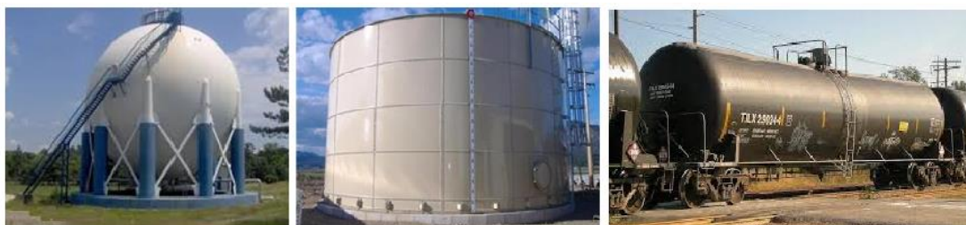
Εικόνα 4.9 Κατηγορίες δεξαμενών από αριστερά: σφαιρική, κατακόρυφη κυλινδρική, οριζόντια κυλινδρική.
