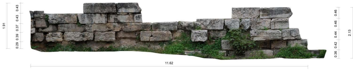
Εικ.97. Ορθοφωτογραφία της νότιας όψης του βόρειου θεμελιότοιχου
