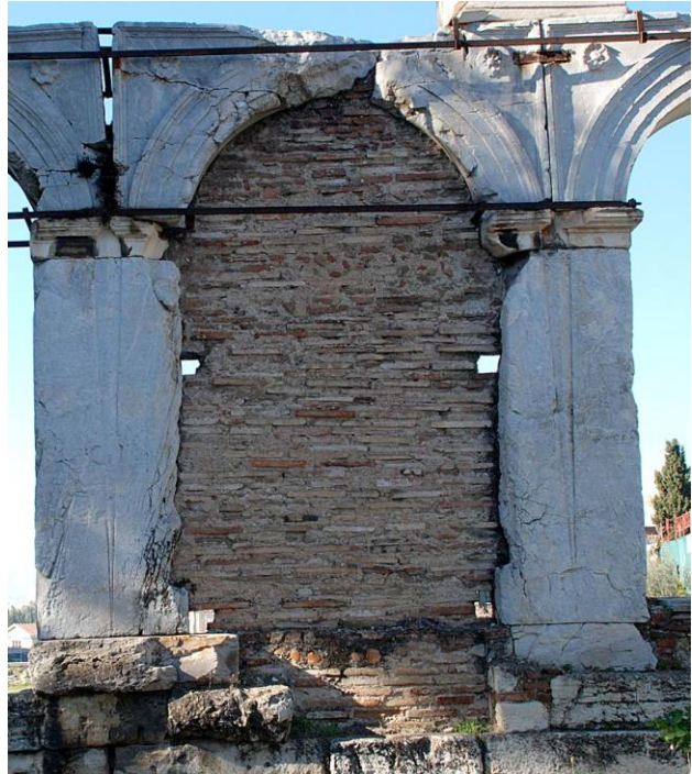
Εικ. 44, Η ανατολική όψη του τοίχου πλήρωσης του μεσαίου ανοίγματος
