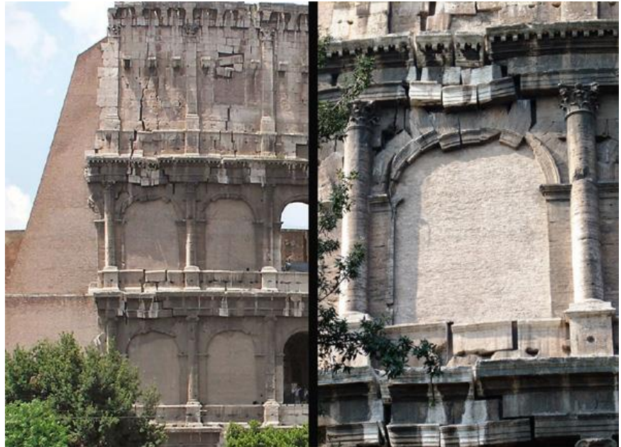
Εικ.,49. Η αντιστήριξη του ετοιμόρροπου, εξωτερικού, ανατολικού άκρου του Κολοσσαίου με αντηρίδα από οπτοπλίνθους και η πλήρωση των αιψιδωτών ανοιγμάτων με οπτοπλινθοδομή, F.Stern, 1806-1807
