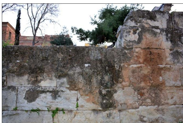
Εικ.117, Ιζηματογενείς αποθέσεις στη βόρεια όψη του βόρειου τοίχου
