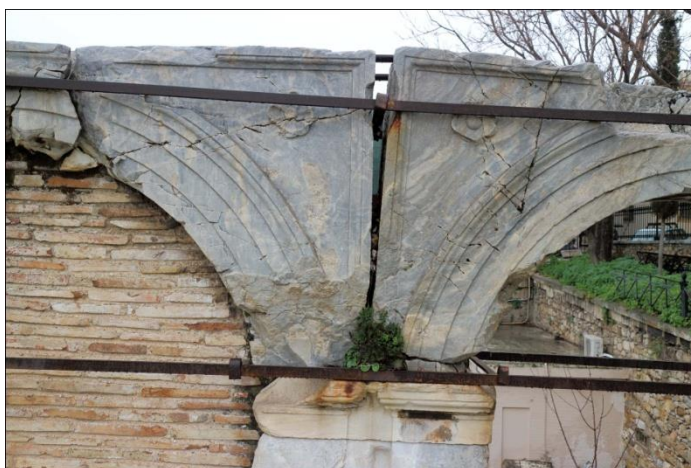
Εικ.106, Διάνοιξη του αρμού ώσεως, απώλεια υλικού στη βάση του τόξου T2
