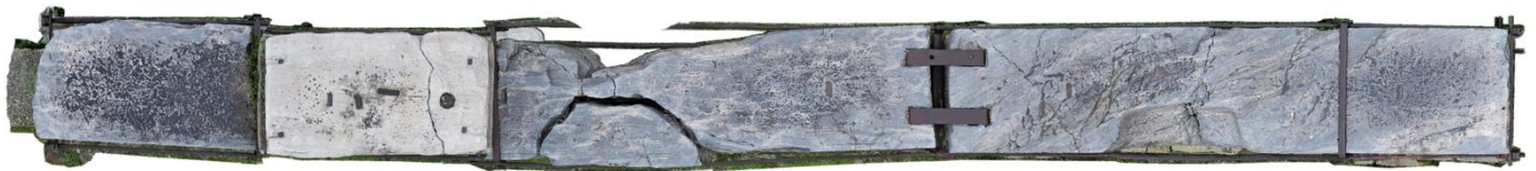
Εικ.83. Ορθοφωτογραφία των άνω εδρών των τοξωτών επιστυλίων
