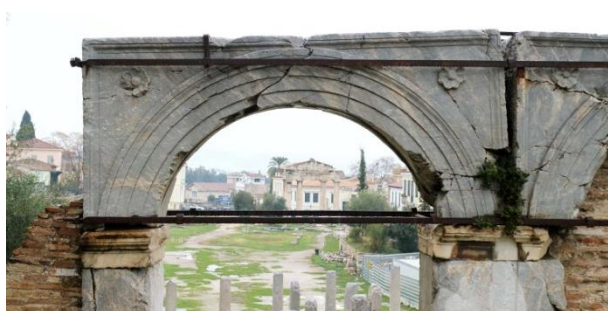
Εικ.118,Κηλίδες σκουριάς στην ανατολική όψη των επικράνων ΕΠ2 και ΕΠ3
