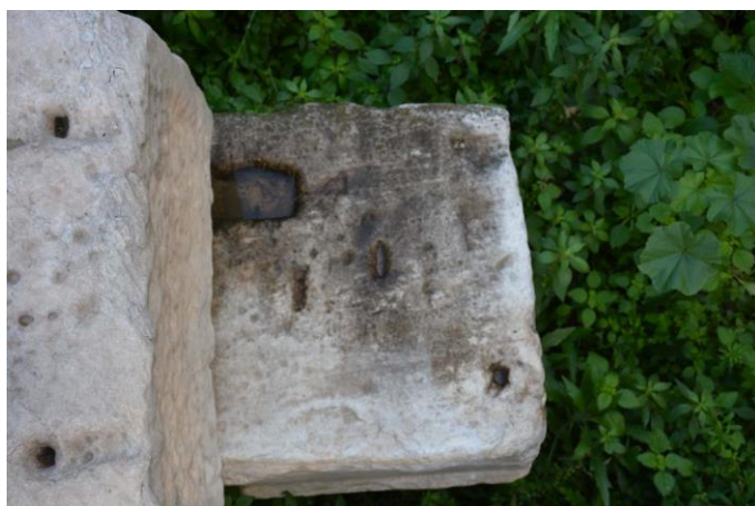
Εικ.96. Η άνω έδρα του λίθος 7(επάνω) και του λίθος 2(κάτω). Διακρίνονται τα μοχλοβόθρια και οι εντορμίες των πιόσχημων συνδέσμων
