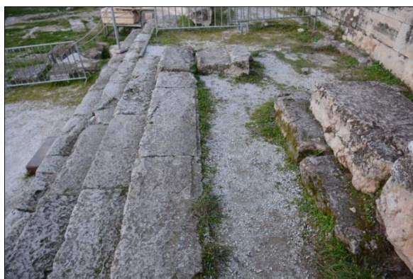
Εικ.56. Διακρίνονται οι οδηγοί στην άνω έδρα των βαθμίδων
