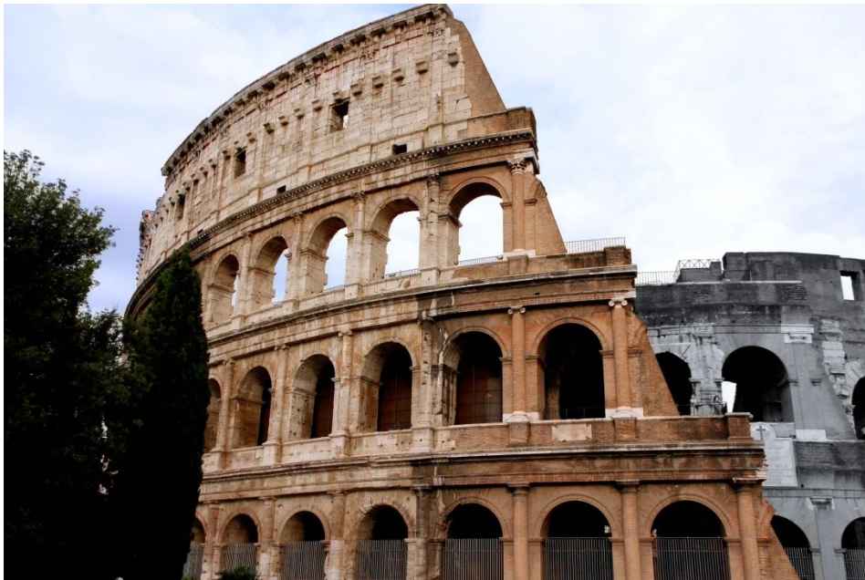
Εικ.50. Η στερέωση του περιμετρικού δακτυλίου του Κολοσσαίου με πλευρικές αντηρίδες από οπτοπλίνθους, G. Valadier, 1823
