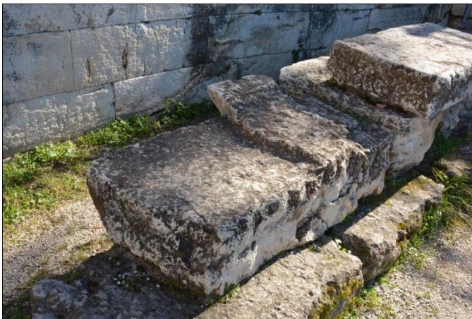
Εικ.55 . Διαφορετικοί τρόποι πλοκής των λίθων με εγκοπές
