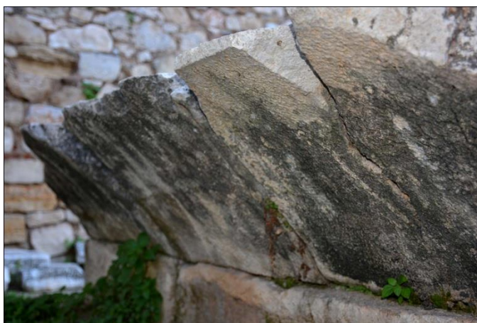
Εικ.66 , Λεπτομέρεια από τις κάτω έδρες των βαθμίδων της κλίμακας. Διακρίνονται ίχνη επεξεργασίας από οδοντωτό εργαλείο
