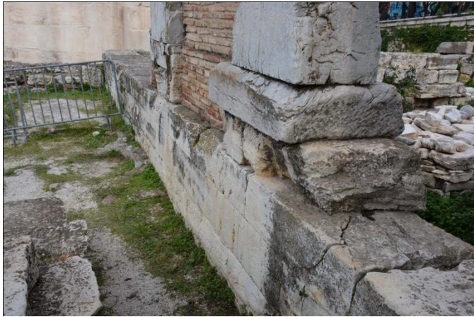
Εικ.58, Σύστημα εγκοπιών στην στάθμη κάτω από το κατώφλι
