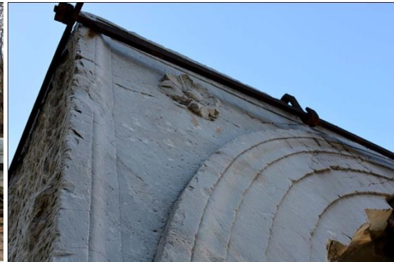
Εικ., 111, Ίχνη πρόσκρουσης βλήματος
