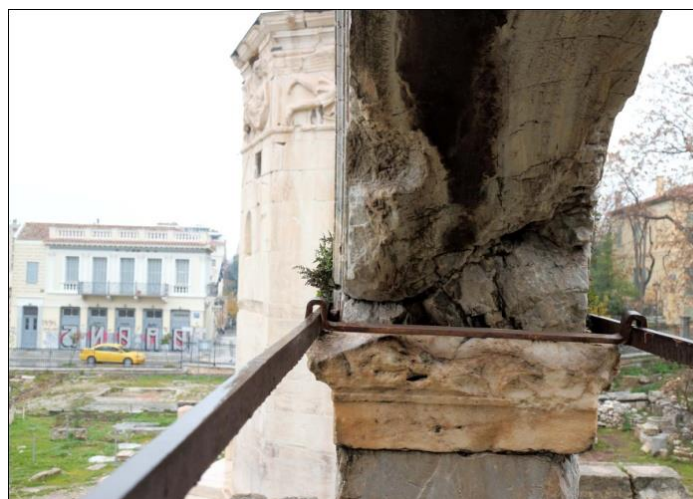
Εικ.107, Αστοχία του τόξου T3 στην έδραση
