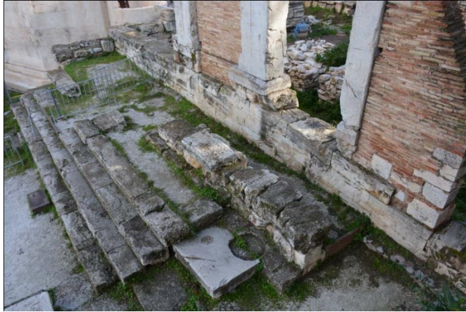
Εικ. 64, Γενική άποψη της θέσης του αγωγού
