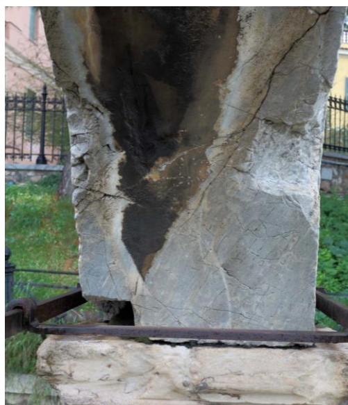
Εικ.116,Μαύρη κρούστα δενδριτικής μορφής στο σωρράχιο του τόξου T3
