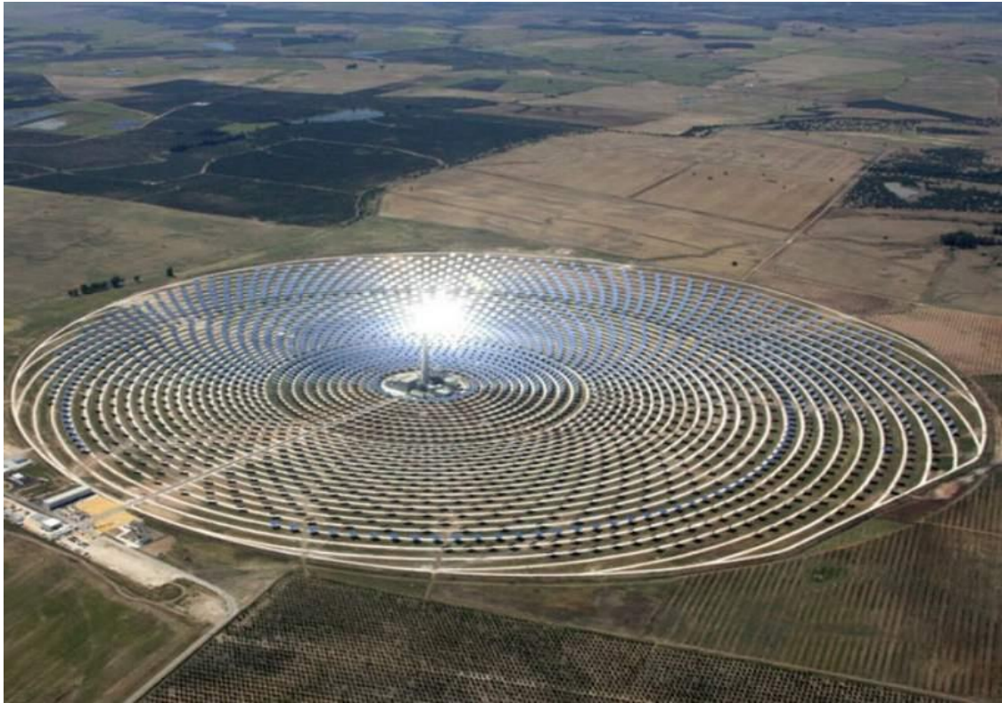
Σχήμα 5.20. Πεδίο ηλιοστατών περιβάλλουσας διάταξης (σταθμός Gemasolar, Ισπανία)
