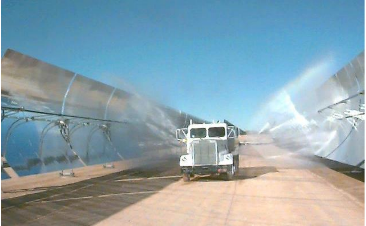
Σχήμα 5.9. Καθαρισμός με νερό υψηλής πίεσης (Πηγή : http://social.csptoday.com/technology/csp-om-dust-proof-solar-fields )
