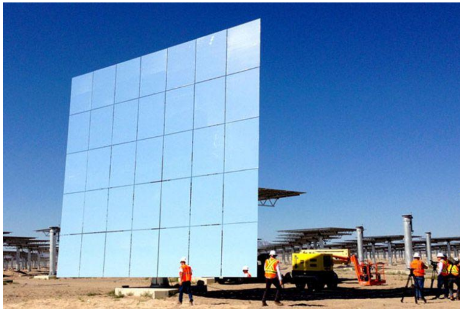
Σχήμα 3.14 Ο συνηθέστερος σχεδιασμός ηλιοστάτη, μοντέλο ASUP 140 της εταιρείας Abengoa ( Πηγή : http://informeanual.abengoa.com/ )
