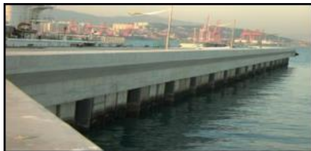
Σχήμα 2.12: Διάτρητος κυματοθραύστης στο λιμάνι ακτοφυλακής στην πόλη Busan, Κορέα
