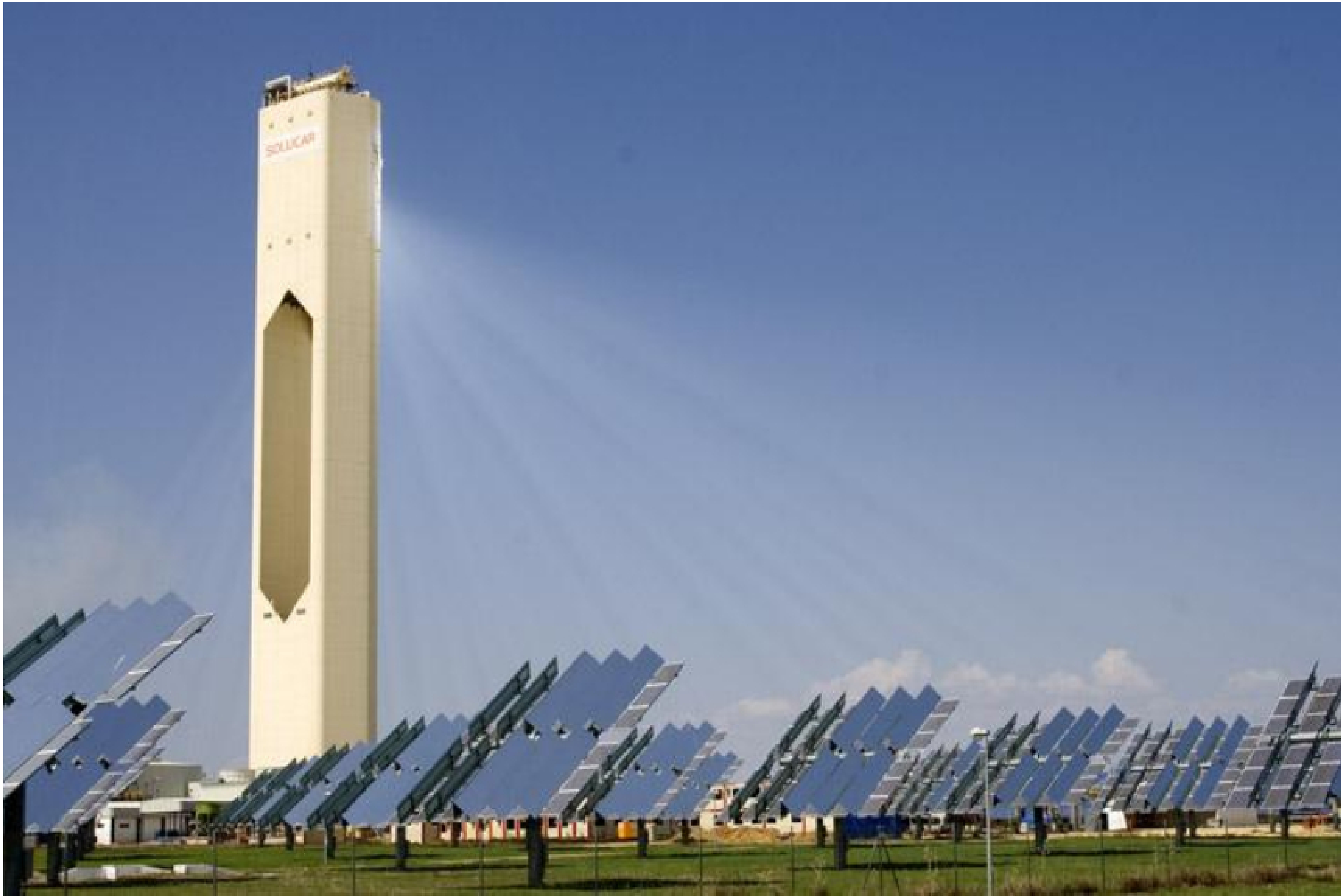
Εικ 4.6 : Ηλιακός Θερμικός Σταθμός Παραγωγής Ενέργεια PS10
