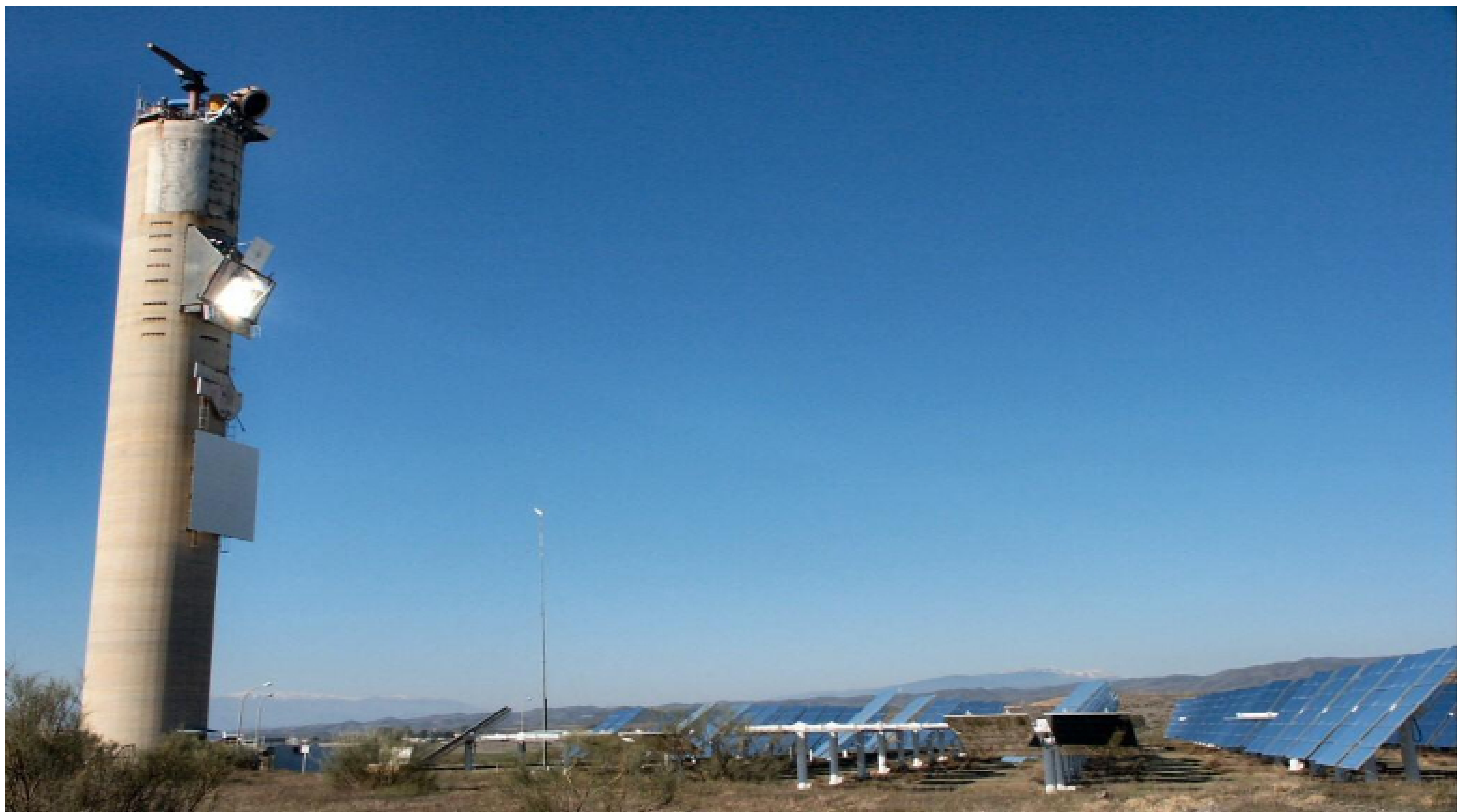
Εικ. 4.5: Πλευρική άποψη του τσιμεντένιου πύργου 80m της CESA-1 στην Plataforma Solar de Almeria στην Ισπανία.
