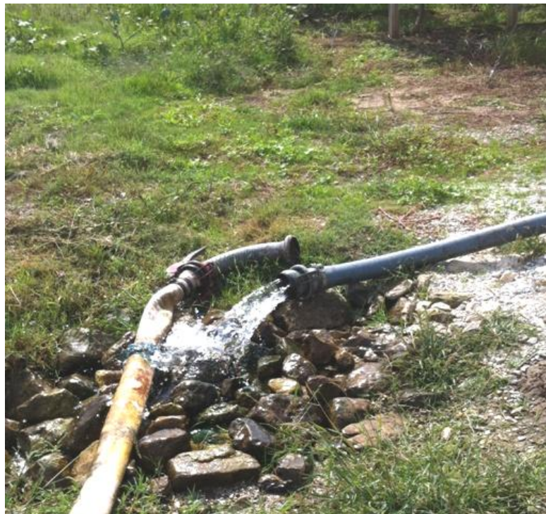
Σχήμα 23 Αρτεσιανές γεωτρήσεις στην περιοχή Δίου
