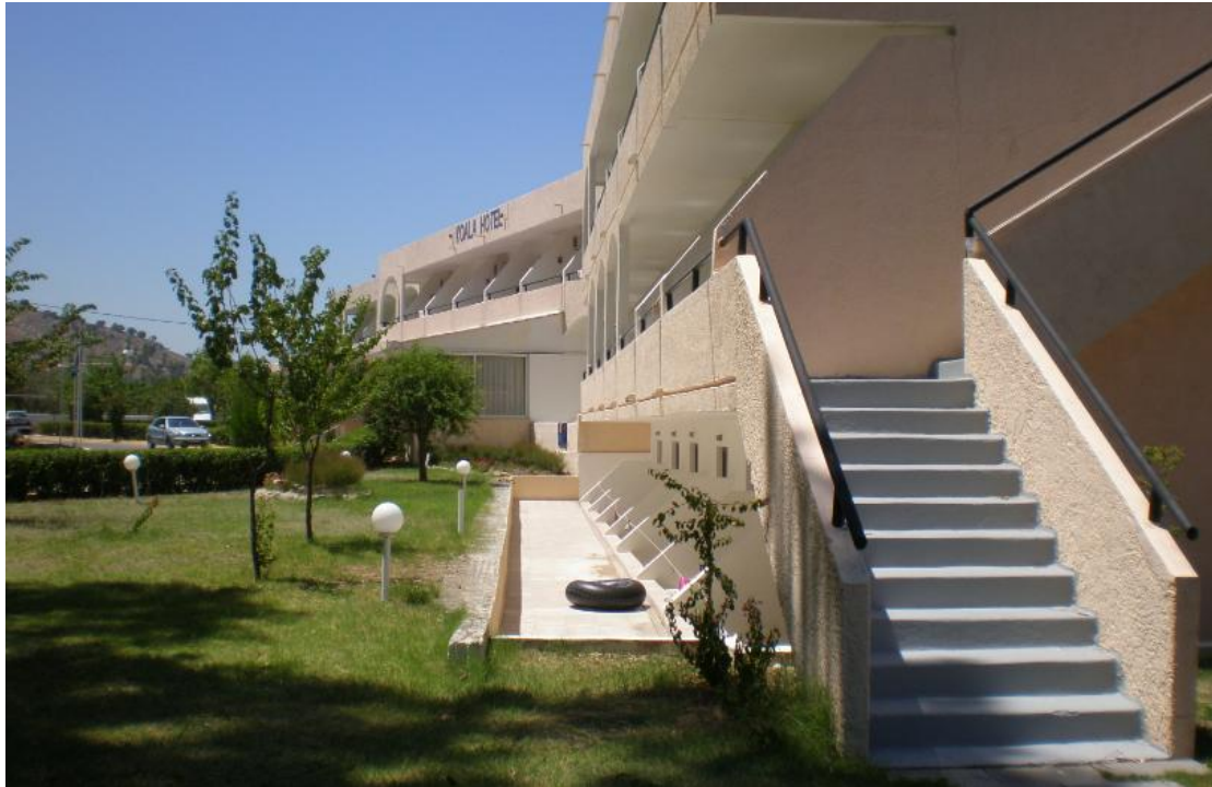
Εικόνα 3.5: Πλαϊνή όψη κτιρίου
