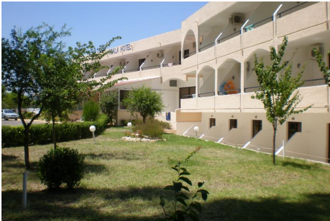
Εικόνα 3.6: Κεντρική όψη κτιρίου
