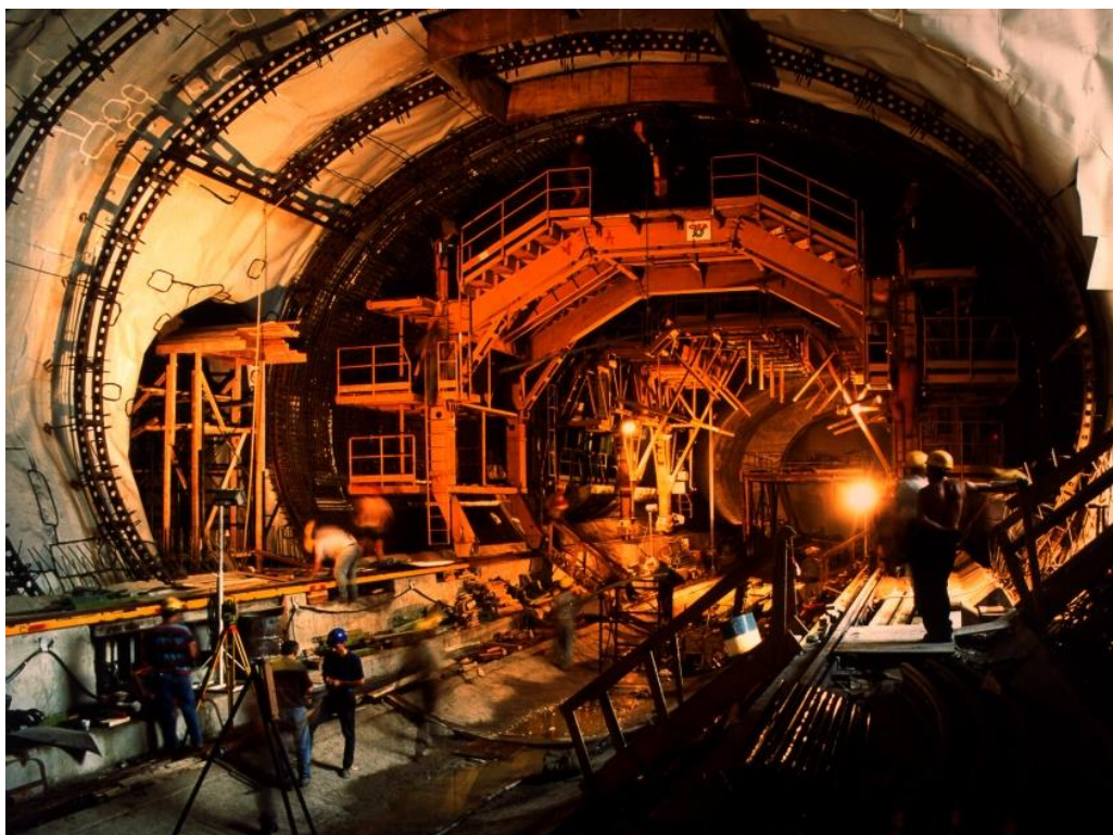
Εικόνα 44: Διάνοιξη σήραγγας με τη χρήση συμβατικών μεθόδων (NATM) (ametro.gr)
