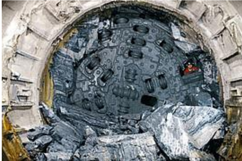
Εικόνα 52: Single Shield TBM ολομέτωπης κοπής (herrenknecht.com)
