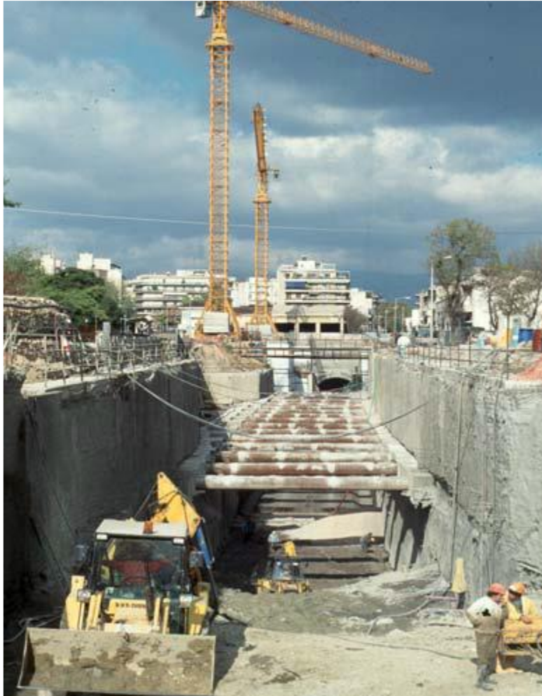
Εικόνα 60: Κατασκευή του σταθμού Αττική με τη μέθοδο ανοικτού ορύγματος (Αττικό Μετρό Α.Ε., 2007)
