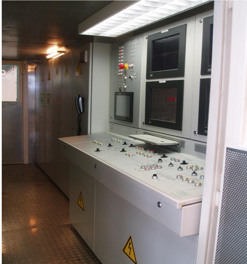
Εικόνα 76: Δωμάτιο ελέγχου της μηχανής EPB TBM στο Μετρό Θεσσαλονίκης
