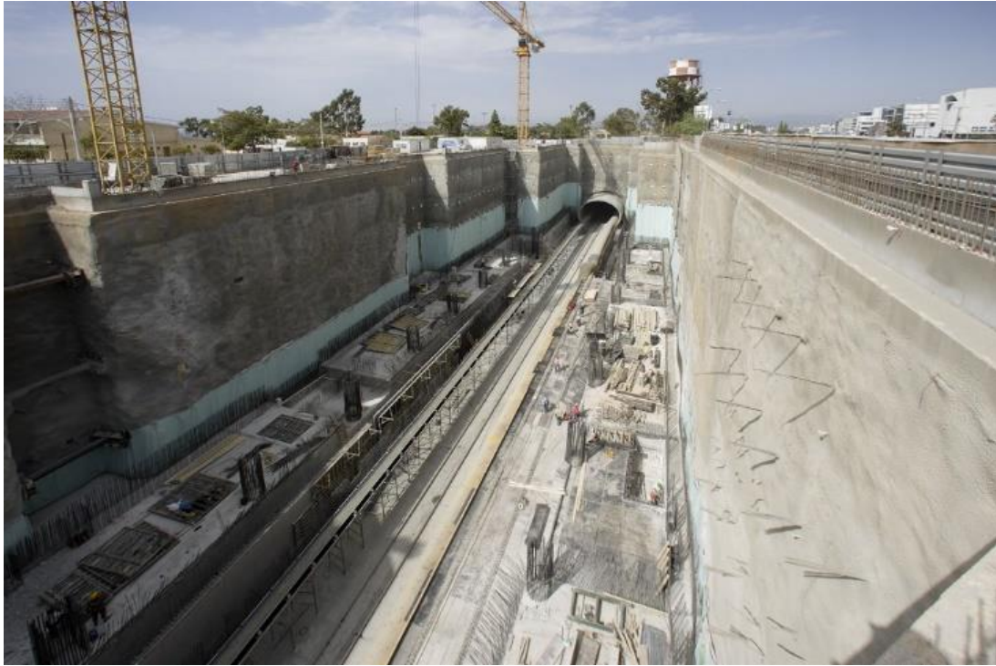
Εικόνα 46: Κατασκευή μέρους της σήραγγας με τη μέθοδο Cut & Cover (ametro.gr)
