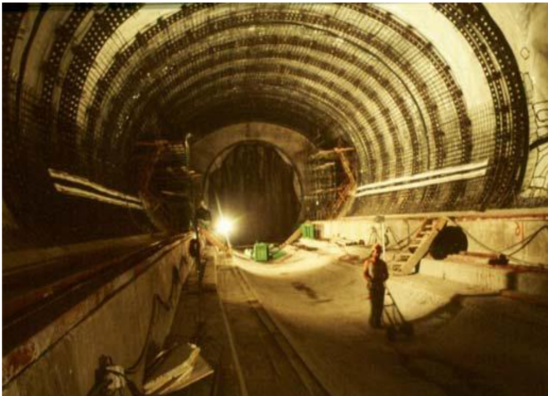
Εικόνα 59: Κατασκευή του σταθμού Αμπελόκηποι, με τη χρήση της συμβατικής μεθόδου (Αττικό Μετρό Α.Ε., 2007)
