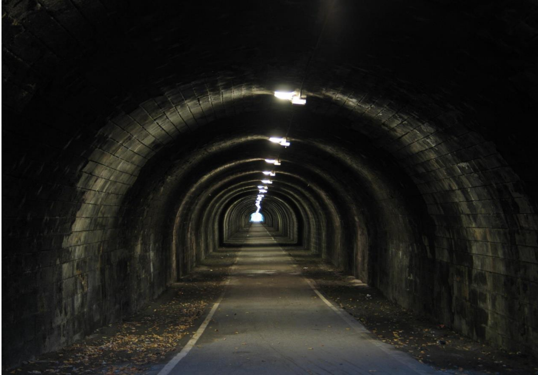
Εικόνα 8: Εσωτερικό σήραγγας (maxiscience.gr)
