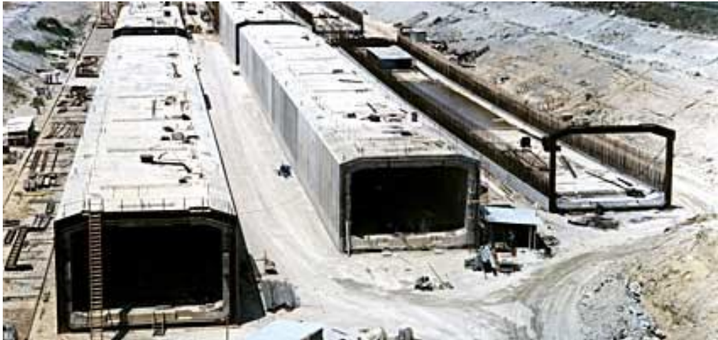
Εικόνα 14: Σπόνδυλοι κατά την κατασκευή τους στη νηοδόχο (gudconsult.de)
