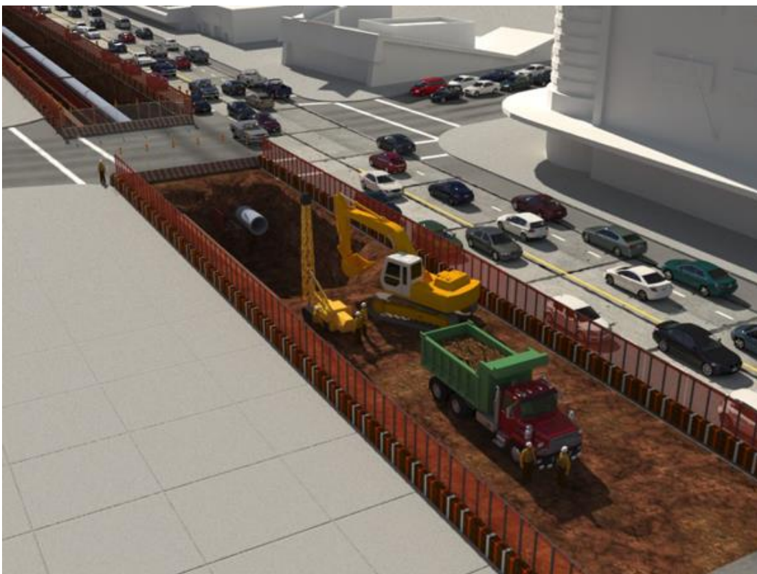
Εικόνα 77: Σχηματική απεικόνιση εργασιών κατασκευής σταθμού Μετρό σε αστικό περιβάλλον με τη μέθοδο ανοιχτού ορύγματος (metro.net)
