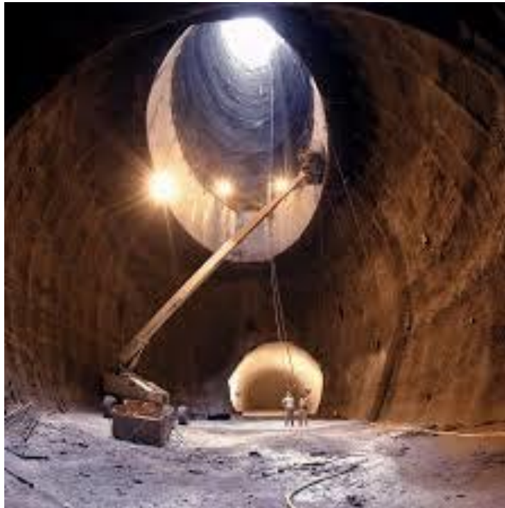
Εικόνα 83: Φρέαρ αερισμού (mred.tuc.gr)
