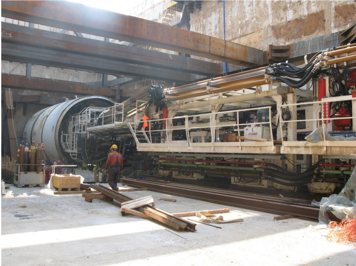
Εικόνα 70: Έναρξη εργασιών μηχανικής διάνοιξης σηράγγων, Φρέαρ Νέου Σιδηροδρομικού σταθμού Θεσσαλονίκης
