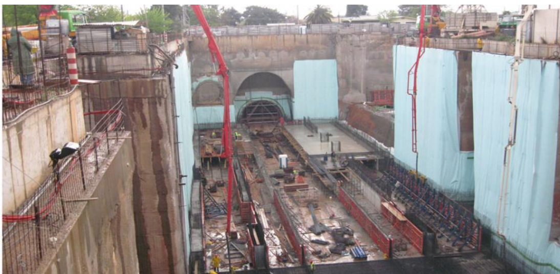
Εικόνα 61: Κατασκευή του σταθμού Αγία Παρασκευή με τη μέθοδο Cut & Cover (ergodomiki.eu)
