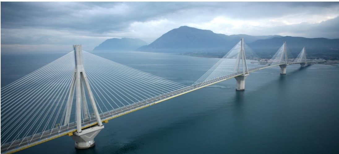
Εικόνα 5: Η γέφυρα Χαρίλαος Τρικούπης στο Ρίο-Αντίρριο (nafraktia.gr)
