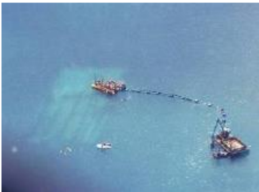
Εικόνα 5-22: Απεικόνιση διαδικασίας RAD: διάταξη γεωφάσματος, φορτηγίδα, τοποθέτηση στο σημείο, σύνδεση με τις αγκυρίδες, πλήρωση με άμμο (πηγή: ASR Ltd).
